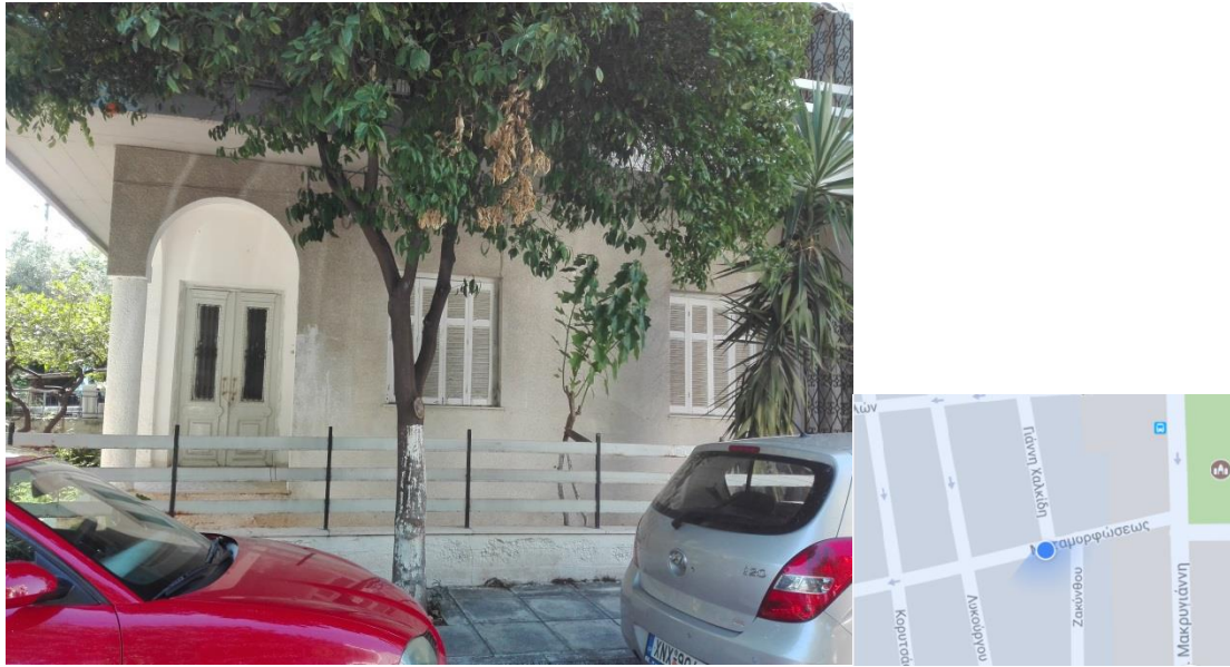
Εικ.34: Στην εικόνα αυτή απεικονίζεται μια κατοικία προσφύγων που βρίσκεται σε καλή κατάσταση. Η κατοικία αυτή βρίσκεται επί της οδού Μεταμορφώσεως.
