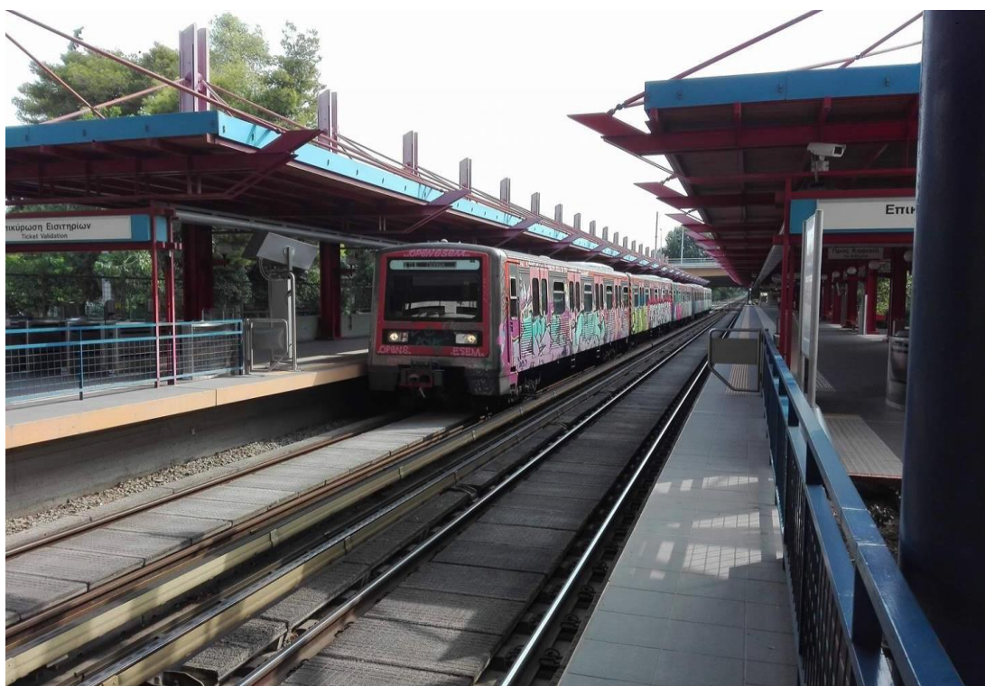
Εικ.110: Στην εικόνα αυτή φαίνεται ο ηλεκτρικός σιδηροδρομικός σταθμός του Μοσχάτου, ο οποίος βρίσκεται και σε καλή κατάσταση.
