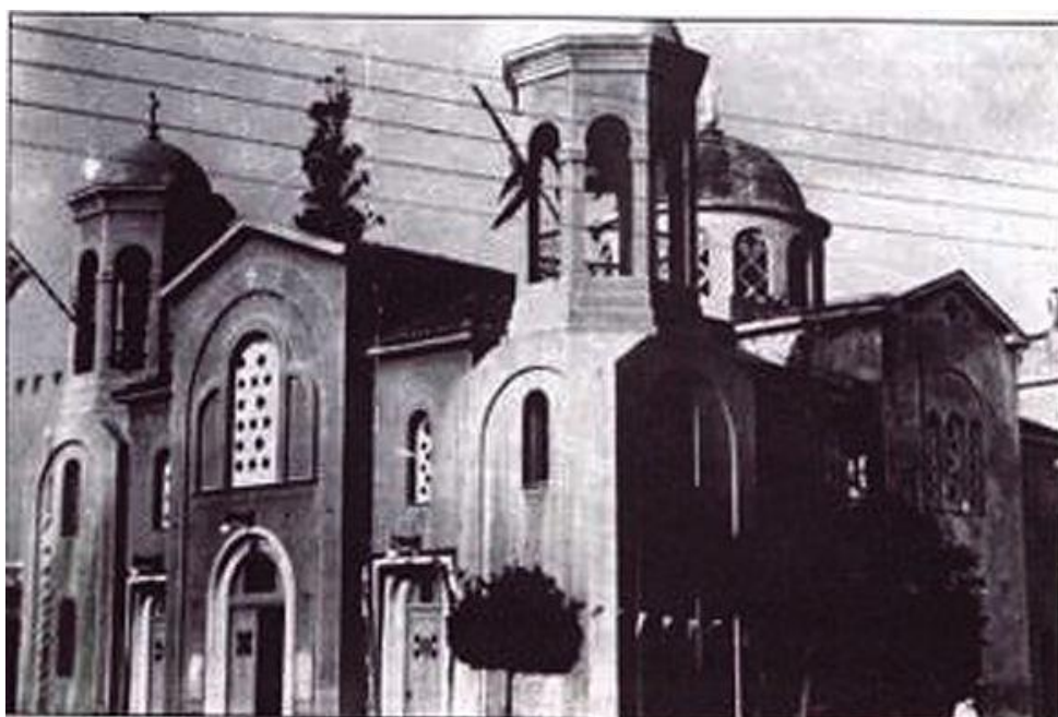
Ο ναός της Μεταμόρφωσης που κατεδαφίστηκε το 1973
