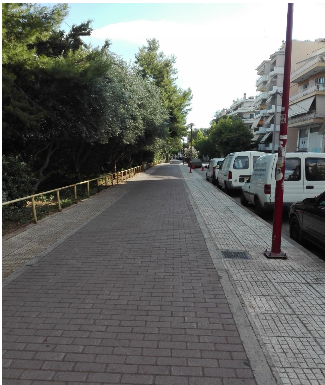
Εικ.75: Αυτός είναι ένας πεζόδρομος και ποδηλατόδρομος που βρίσκεται επί της οδού Ιλισού και είναι παράλληλος με τον ποταμό Ιλισό και έχει μεγάλο μήκος. Φαίνεται ότι είναι σε καλή κατάσταση, αποτελεί ένα από τα καινούργια έργα της περιοχής του Μοσχάτου αφού κατασκευάστηκε το καλοκαίρι του 2015.
