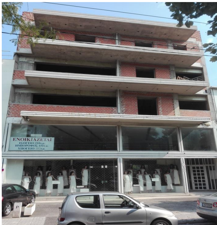
Εικ.38: Στην φωτογραφία αυτή παρατηρείτε ότι στο ισόγειο της κατασκευής λειτουργεί κατάστημα, ενώ στους υπόλοιπους ορόφους διακρίνεται ότι δεν έχει ολοκληρωθεί το στάδιο της τειχοποιίας. Αυτή η κατασκευή βρίσκεται στην οδό Θεσσαλονίκης.
