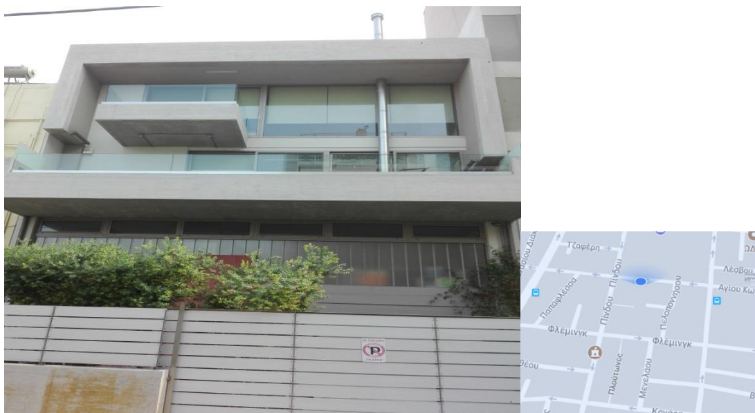
Εικ.45: Στην φωτογραφία αυτή φαίνεται μια κατασκευή περίπου ίδια με την κατασκευή της Εικόνας 44 που χρονολογείται και αυτή από το 2010 και μετά, αλλά αυτή αποτελείται από οπλισμένο σκυρόδεμα και τζαμαρία μόνο στην πρόσοψη. Βρίσκεται επί της οδού Αγ. Κωνσταντίνου.
