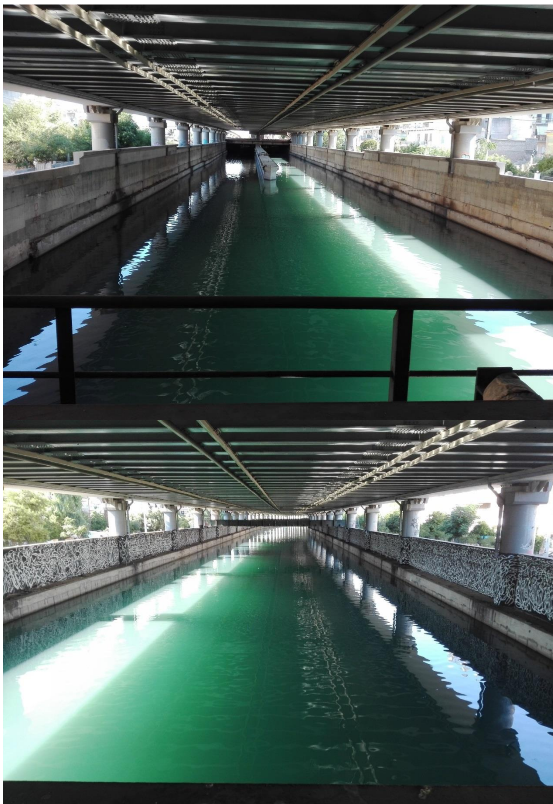
Εικ.127: Στις εικόνες αυτές φαίνεται η κατάσταση του Κηφισού σήμερα. Από πάνω του είναι η Εθνική Οδός Αθηνών – Λαμίας.
