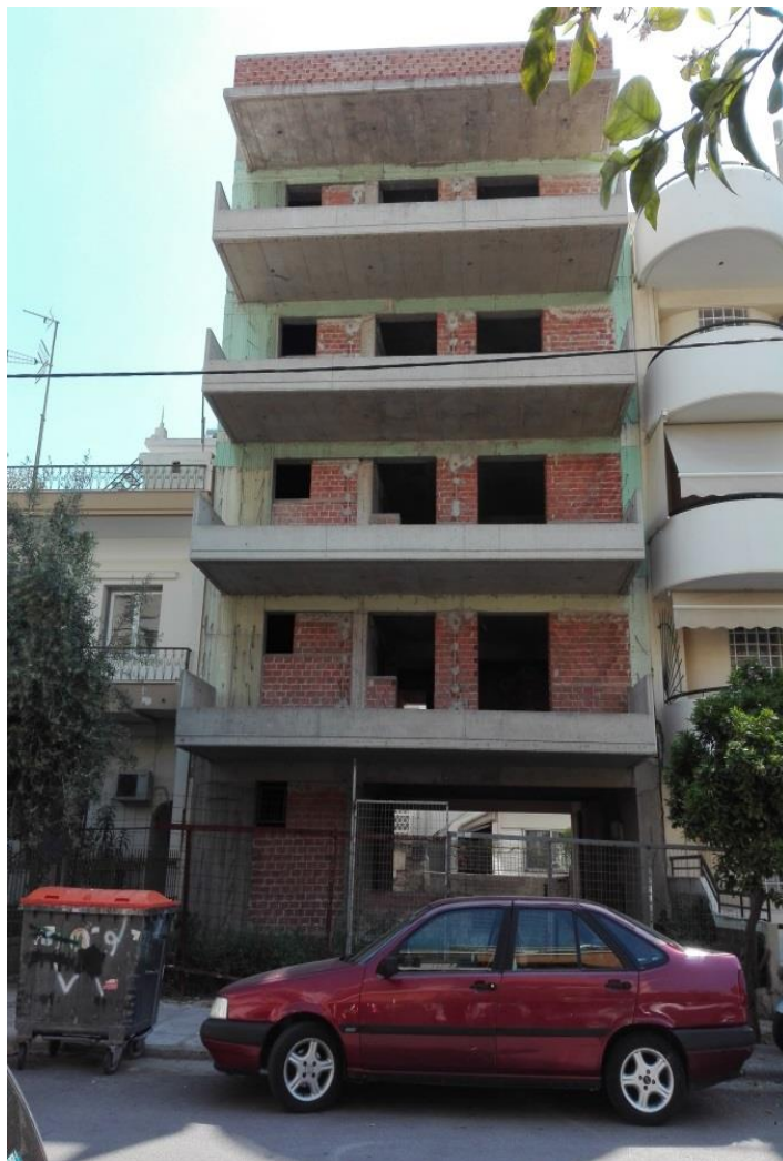
Εικ.39: Στην εικόνα αυτή διακρίνεται μια μη ολοκληρωμένη κατασκευή που έχει μείνει στην μέση του σταδίου της τειχοποιίας. Βρίσκεται επί της οδού Σολωμού.
