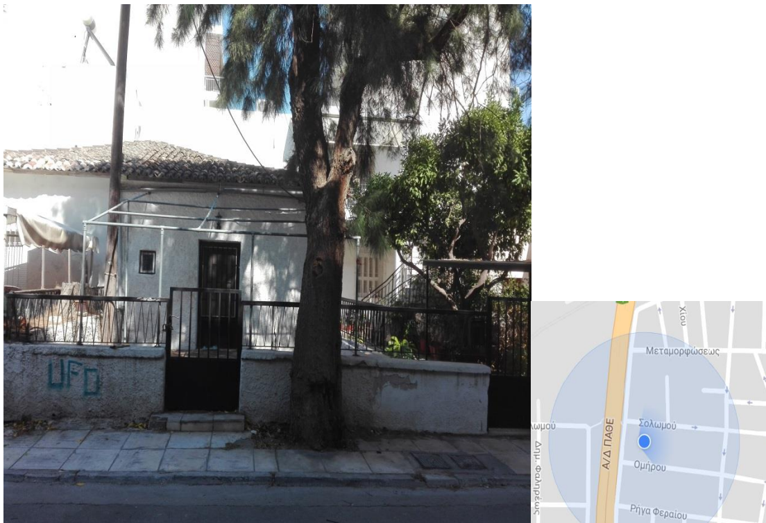
Εικ.35: Εδώ απεικονίζεται ακόμα μια προσφυγική κατοικία που δεν βρίσκεται σε τόσο καλή κατάσταση και χρειάζεται επισκευές. Βρίσκεται επί της οδού Κηφισού και οδού Σωλομού.
