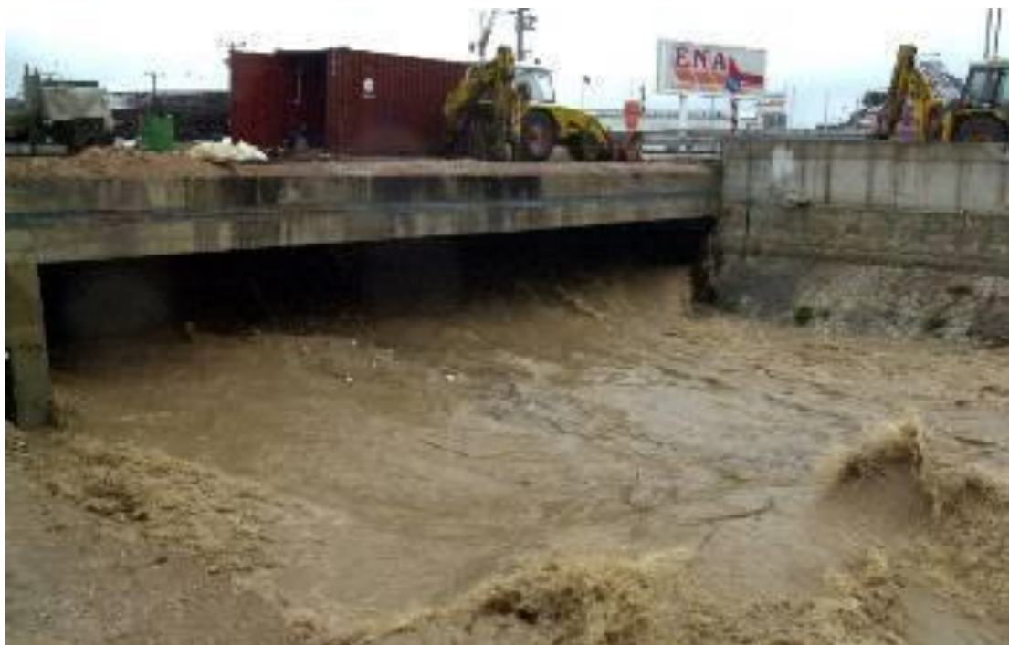
Εικ.129: Στην εικόνα αυτή φαίνεται η υπερχειλίση του ποταμού Κηφισού πριν αρχίσουν τα έργα του εγκυβοτισμού το 2000.
