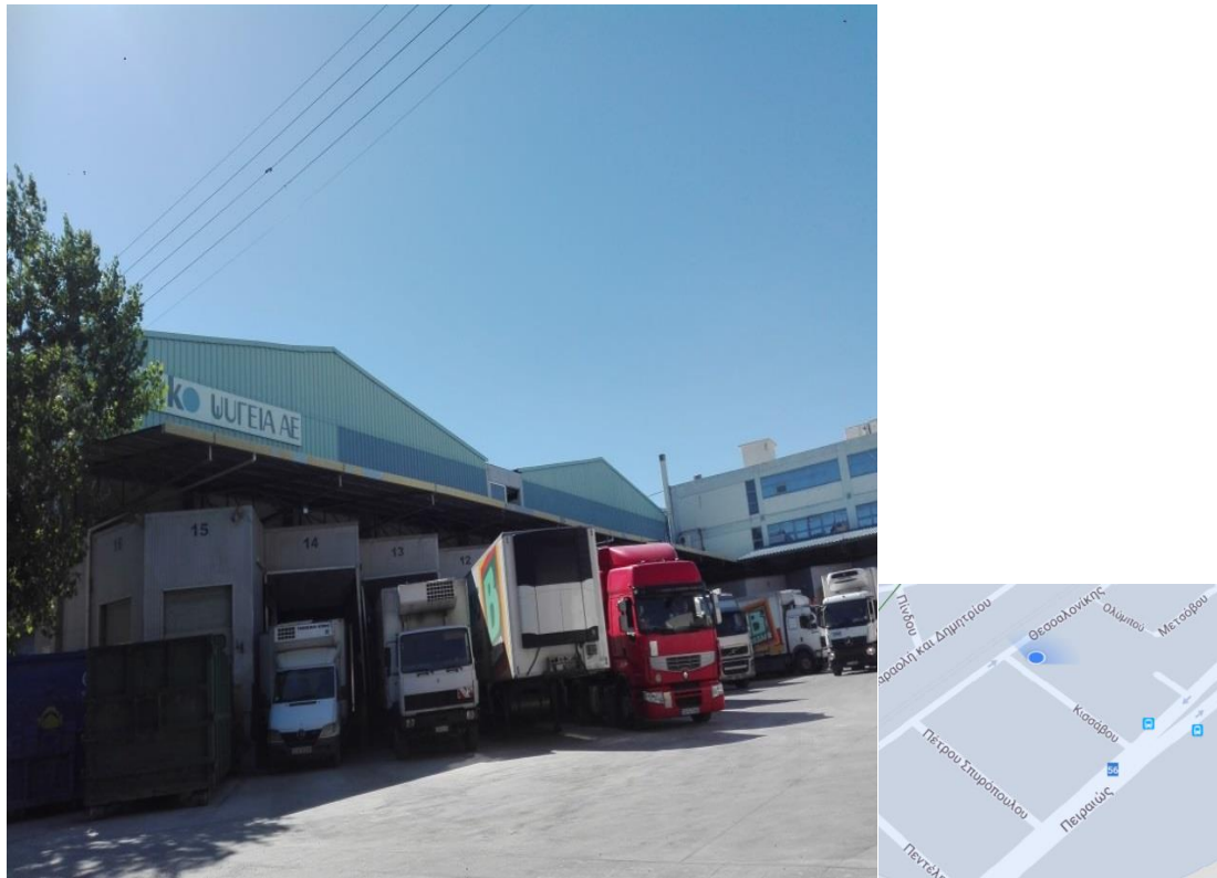
Εικ.54: Η βιομηχανία αυτή βρίσκεται επί της οδού Θεσσαλονίκης και οδού Κισσάβου. Η βιομηχανία αυτή κατέχει ένα μεγάλο αριθμό ψυγείων με σκοπό την αποθήκευση τροφίμων μεγάλων αλυσίδων Super Market καθώς και άλλων βιομηχανιών.
