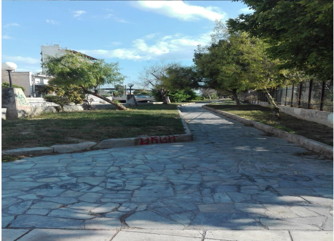
Εικ.77: Αυτός ο πεζόδρομος βρίσκεται στο τέλος της οδός Ιλισού. Βρίσκεται σε καλή κατάσταση αλλά κόβει τον δρόμο αναγκάζοντας τους οδηγούς για να βγουν στη Λεωφόρο Ποσειδώνος να κάνουν ολόκληρη παράκαμψη. Ο πεζόδρομος αυτός όπως και ο προηγούμενος θεωρούνται λανθασμένοι.
