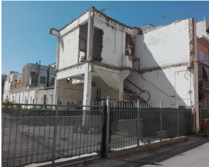
Εικ.8: Το εγκαταλελειμμένο κτίριο της φωτογραφίας βρίσκεται επί της οδού Κοντοζή 7. Οι κίνδυνοι αυτού του κτιρίου είναι μόνο ένας και αυτός είναι ο μεγάλος βαθμός επικινδυνότητας κατάρρευσης , αφού φαίνεται ξεκάθαρα ότι κάποιο τμήμα του κτιρίου έχει υποστεί ήδη κατάρρευση.
