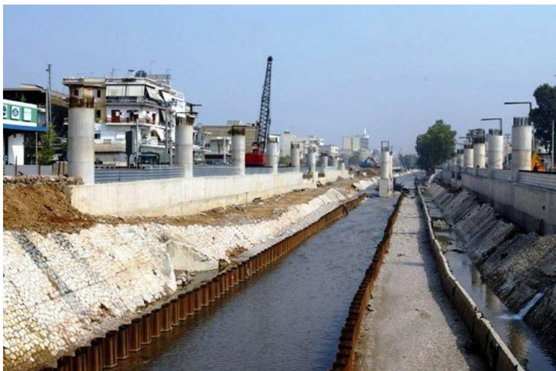
Εικ.128: Στην φωτογραφία αυτή φαίνεται ο εγκιβωτισμός του Κηφισού και η κατασκευή της Εθνικής Οδού κάπου το 2001.
