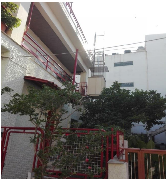
Εικ.20: Στην φωτογραφία αυτή απεικονίζεται ένας εξωτερικός ανελκυστήρας που έχει κατασκευαστεί αυθαίρετα. Η χρήση του είναι η μεταφορά ατόμων από το ισόγειο στον πρώτο και στον δεύτερο όροφο και αντίστροφα. Αυτή η αυθαίρετη κατασκευή είναι επί της οδού Λήμνου.
