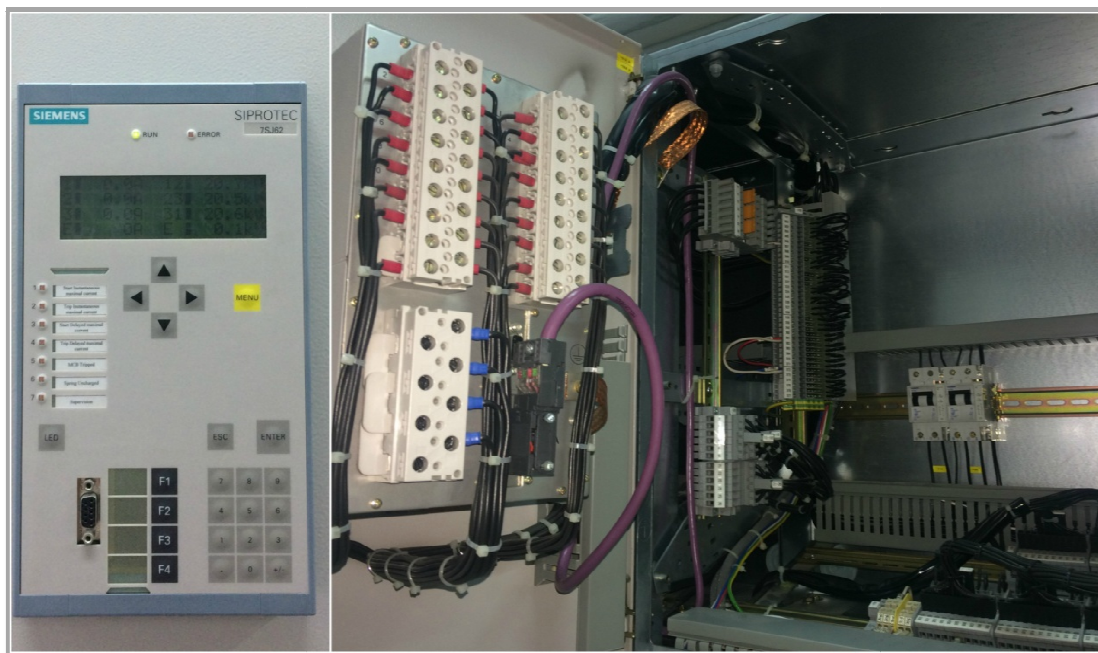
Εικόνα 38 Ηλεκτρονόμος Siprotec 4 7SJ625 εξωτερική και εσωτερική οψη
