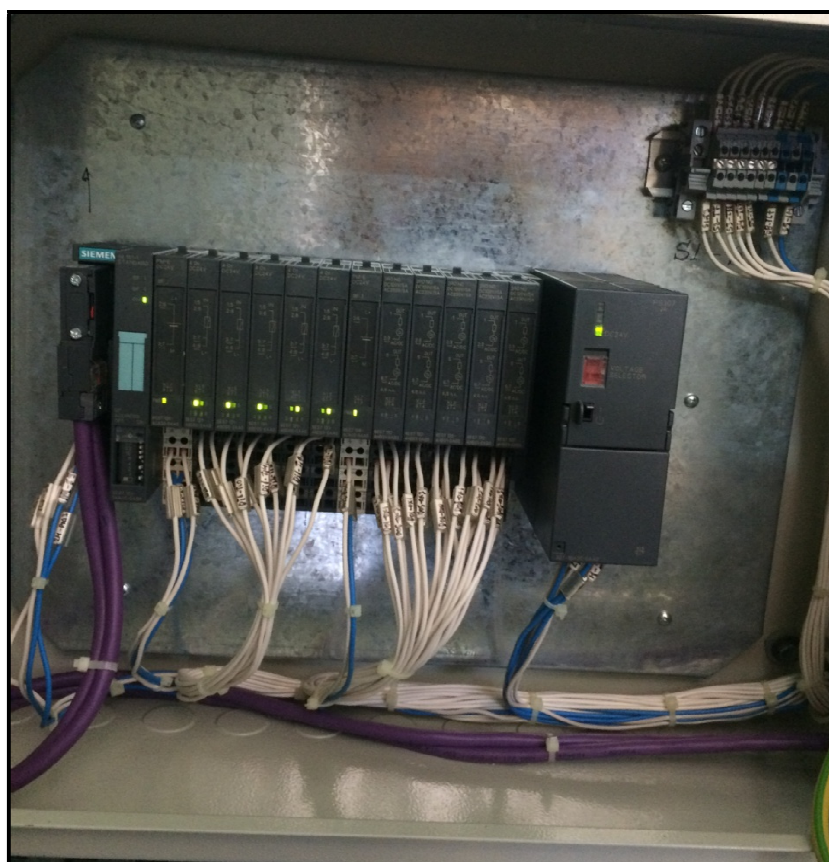
Εικόνα 35 Καταναμημένο σύστημα ET200S της εταιρείας SIEMENS
