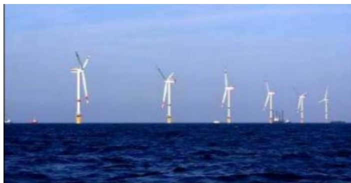
Υπεράκτιο αιολικό πάρκο στο Βέλγιο
