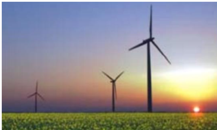
Αιολικό πάρκο πεδινής περιοχής
