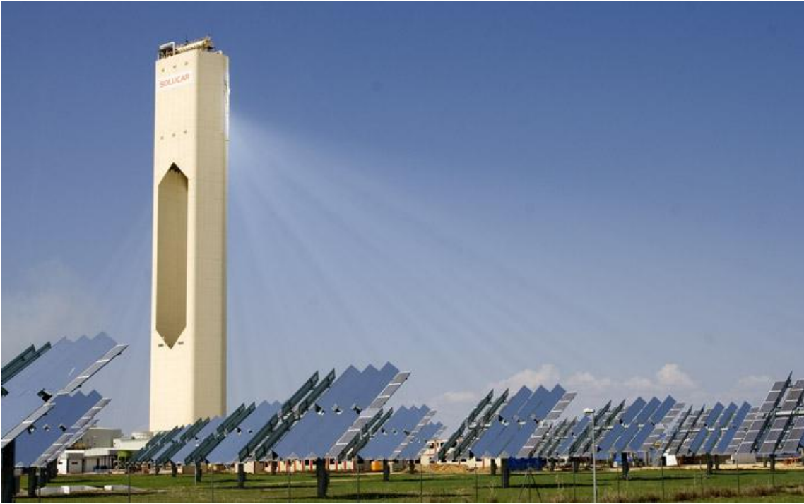
Εικόνα 7. Ο ηλιοθερμικός ηλεκτροπαραγωγός σταθμός, PS10 στην Ισπανία χρησιμοποιεί κάτοπτρα για να συγκεντρώσει τις ακτίνες του ήλιου σε ένα κεντρικό πύργο.
