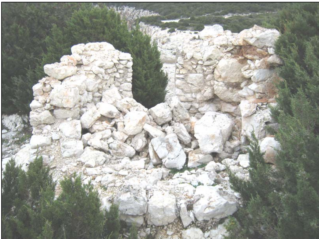
Εικ. 34 : Η πίσω όψη. Στο εσωτερικό της σκοπιάς ο σωρός από τα ερείπια της θολωτής σκεπής.
