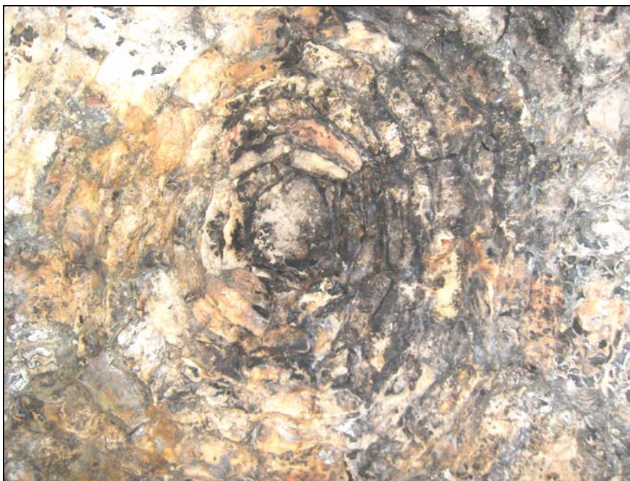
Εικ. 53 : Η άνοψη του τρούλου. Όπως μπορούμε να διακρίνουμε, πρόκειται για ιδιαίτερα επιμελημένη κατασκευή.
