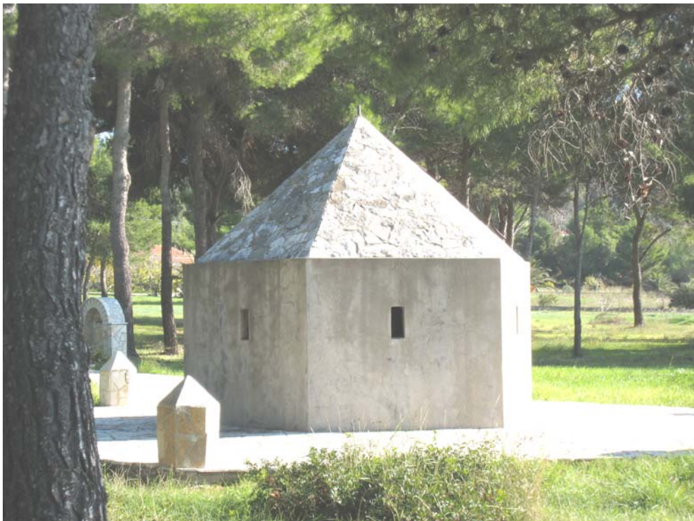
Εικ. 22 : Πλαϊνή όψη της ίδιας βαρδιόλας. Η κάτοψη της έχει σχήμα εξαγώνου και η οροφή της είναι εξαγωνική πυραμίδα.
