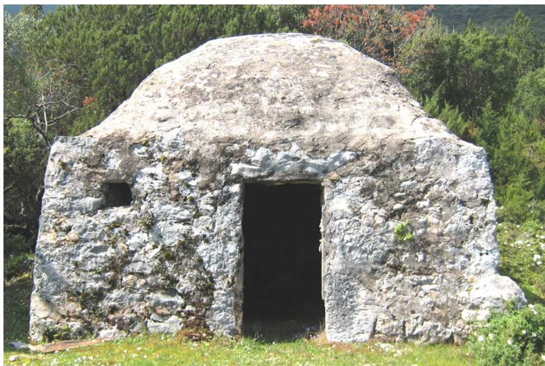
Εικ. 49 : Στη φωτογραφία διακρίνουμε την τυφεκιοθυρίδα που πλαισιώνει από αριστερά την είσοδο. Η αντιδιαμετρική της στα δεξιά έχει χτιστεί εξωτερικά, πιθανόν για λόγους αποθήκευσης.
