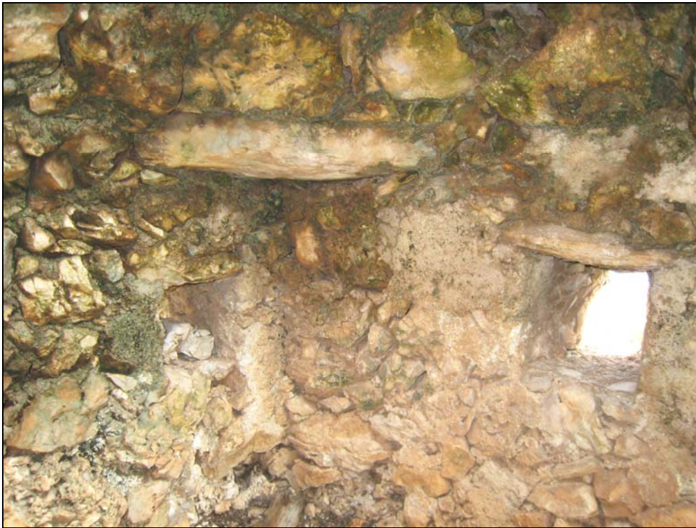
Εικ. 61 : Οι δύο τυφεκιοθρίδες από το εσωτερικό της βαρδιόλας. Παρατηρείται η ίδια τεχνοτροπία με αυτή της Κουτσοουπιάς.
