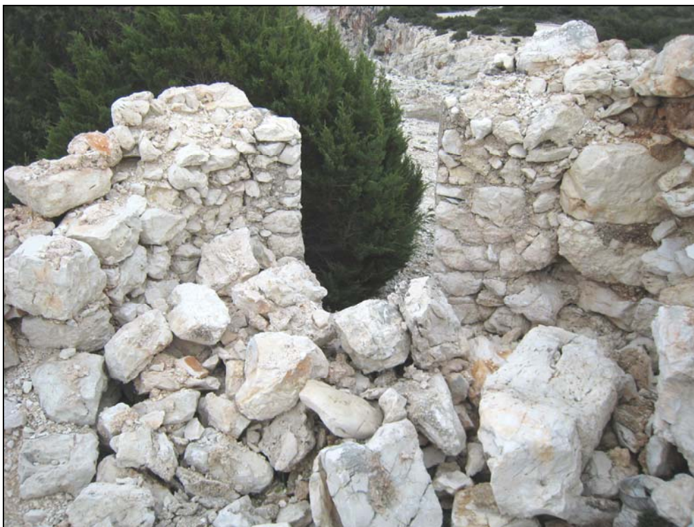
Εικ. 66 : Η εικόνα που αντικρίζουμε σήμερα με τα ερείπια του θόλου και της τοιχοποιίας να κείτονται στο εσωτερικό, καθιστά αδύνατο να καταλάβουμε εάν υπήρχαν στο παρελθόν τυφεκιοθυρίδες.
