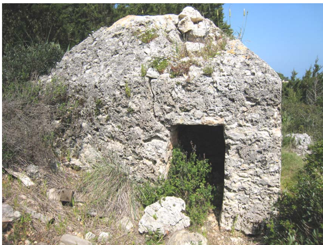
Εικ. 59 : Η πρόσοψη της βαρδιόλας. Διακρίνεται το μικρό άνοιγμα της εισόδου.
