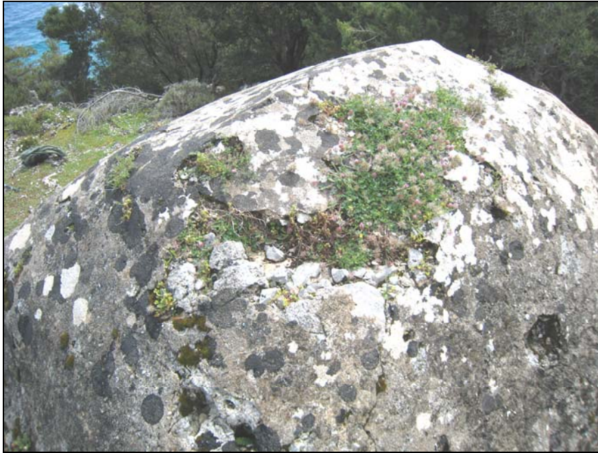
Εικ. 52 : Η οροφή της βαρδιόλας. Η εξωτερική επιφάνεια του τρούλου καλύπτεται από λεπτό στρώμα ισχυρού επιχρίσματος, το λεγόμενο “κουρασάνι”.
