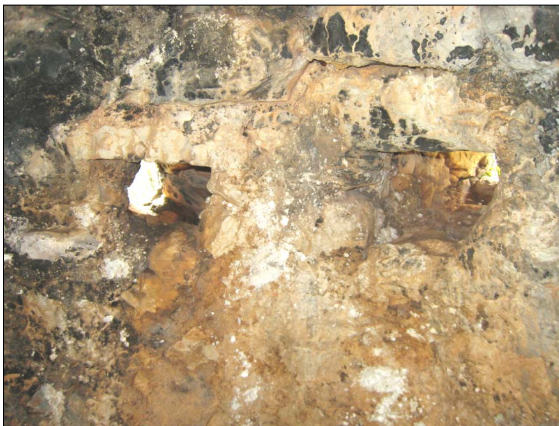
Εικ. 50 : Ένα από τα τέσσερα γωνιακά ζεύγη τυφεκιοθυρίδων, όπως φαίνονται από το εσωτερικό. Κάθε μία από το ζεύγος καταλήγει και σε διαφορετική πλευρά της βαρδιόλας.
