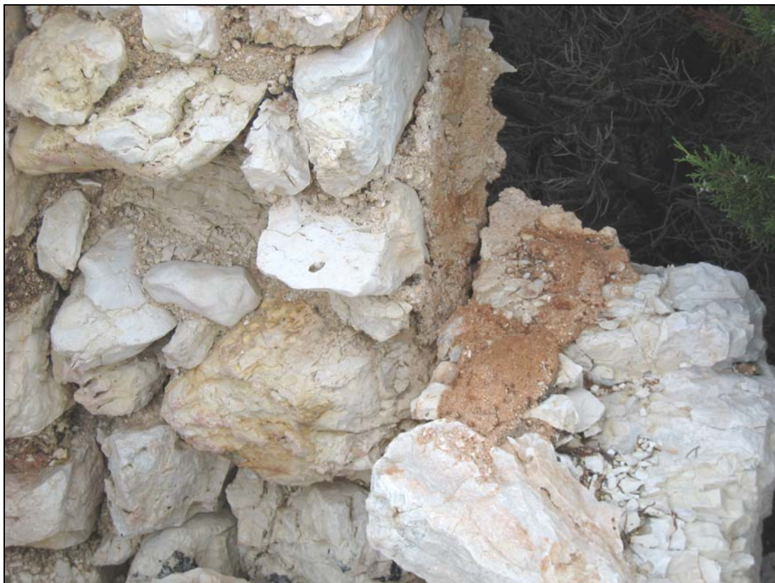
Εικ. 67 : Τμήμα της περιμετρικής τοιχοποιίας. Στη φωτογραφία διακρίνονται οι ασβεστόλιθοι διαφόρων σχημάτων και μεγεθών, καθώς και το κονίαμα που πιθανόν να περιείχε ασβέστη.
