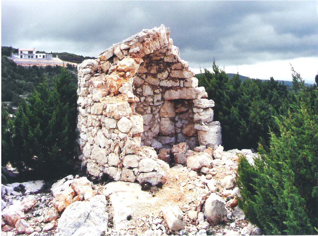
Εικ. 65 : Η πλαϊνή όψη της (26/04/2000), πριν ακόμα καταπέσει και το τελευταίο τμήμα του θόλου. Φωτογραφία επίσης από το αρχείο της Υπηρεσίας Νεοτέρων Μνημείων στο Αργοστόλι.
