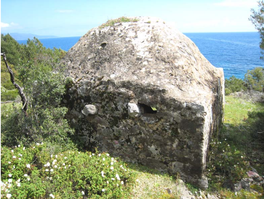
Εικ. 55 :Οι δύο μυτεροί λίθοι στο πίσω μέρος της βαρδιόλας. Ένα από τα τεχνικά χαρακτηριστικά της κατασκευής που πιθανώς χρησίμευε για να σκαρφαλώνει ο βαρδιάνος στην κορυφή της.
