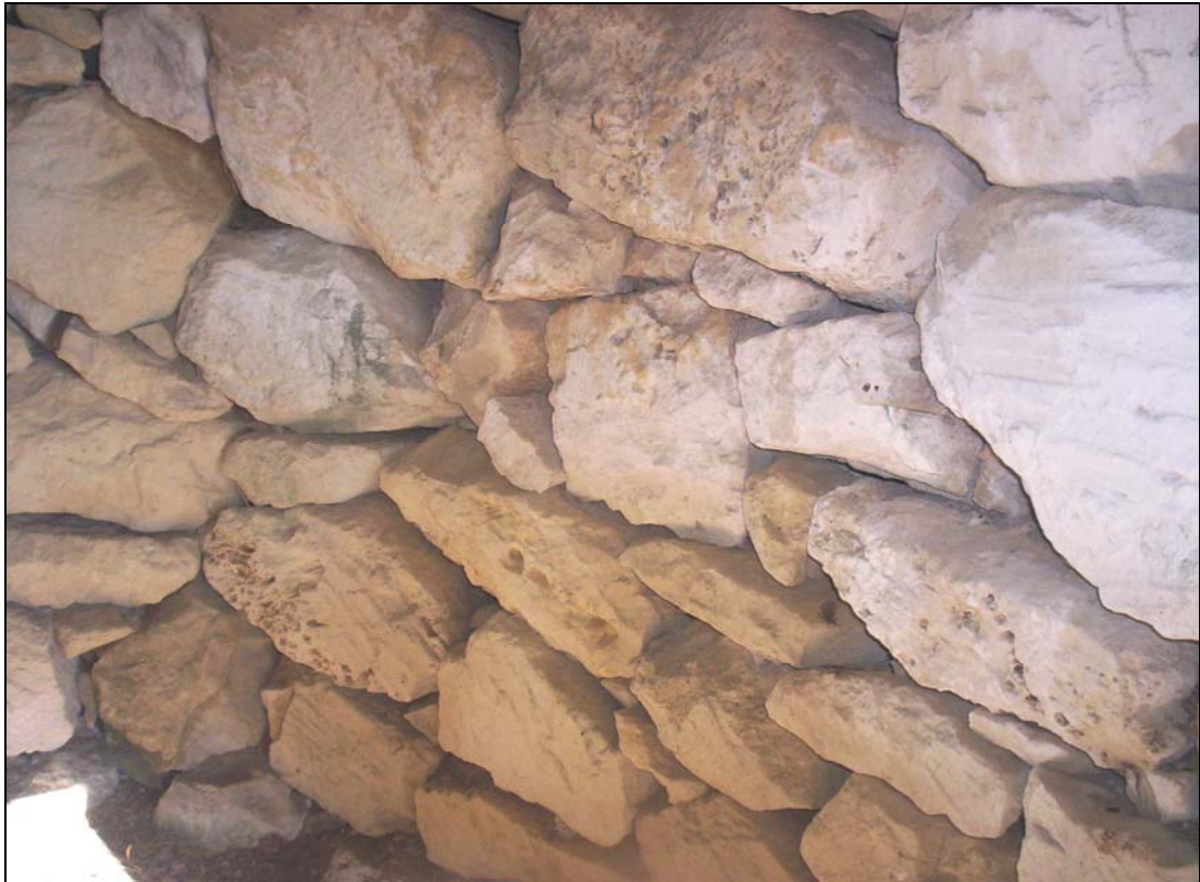
Εικ. 72 : Τμήμα του περιμετρικού τοίχου εσωτερικά. Διακρίνονται οι αργοί λίθοι και η απουσία κονιάματος ανάμεσά τους
