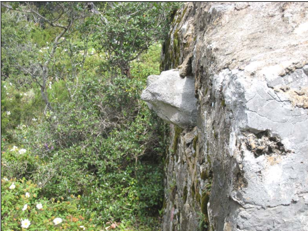
Εικ. 56 :Οι δύο μυτεροί λίθοι στο πίσω μέρος της βαρδιόλας χρησίμευαν ως πατήματα για να σκαρφαλώνει ο βαρδιάνος στην κορυφή της.
