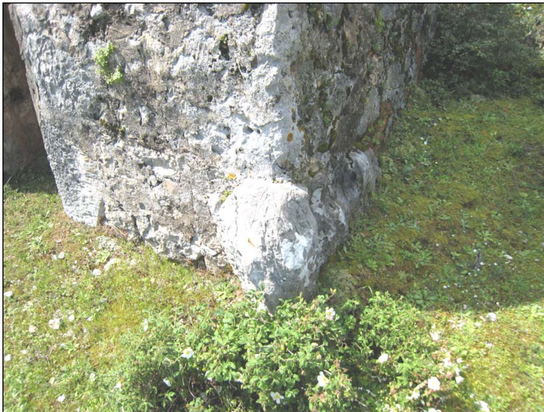
Εικ. 54 : Ο ακρογωνιαίος λίθος που ξεχωρίζει από την υπόλοιπη λιθοδομή στη δεξιά βάση της πρόσοψης.
