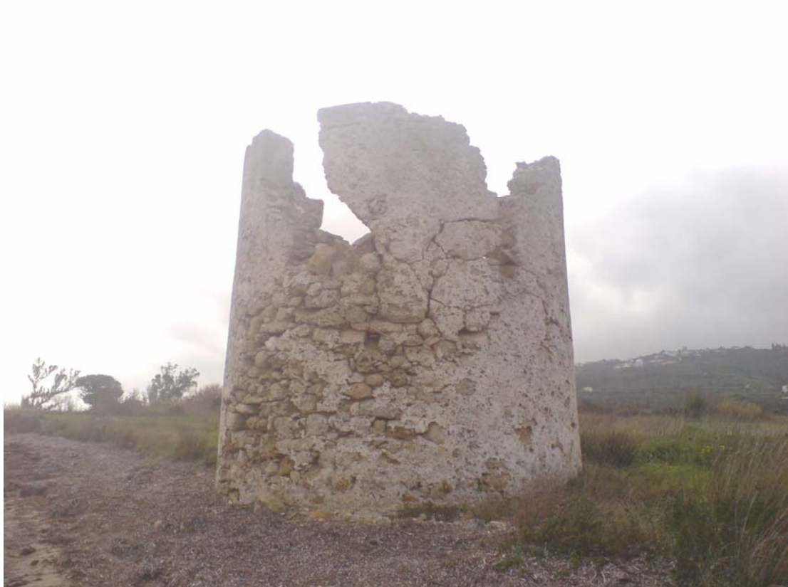
Εικ. 47 : Υψηλό κτίσμα στο Λιβάδι. Είτε υπήρξε μύλος, είτε αυτούσιος πύργος - παρατηρητήριο (βίγλα), λόγω του ύψους του, θα μπορούσε κανείς από εκεί να κατοπτεύει τον κάμπο και την παραλία του Λιβαδιού.
