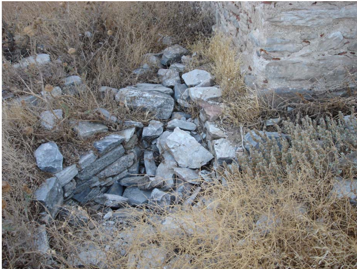
ΦΩΤΟΓΡΑΦΙΑ 12 Νότια γωνία βίγλας Κουτουμουλά Κυκλικό κτίσμα στο έδαφος
