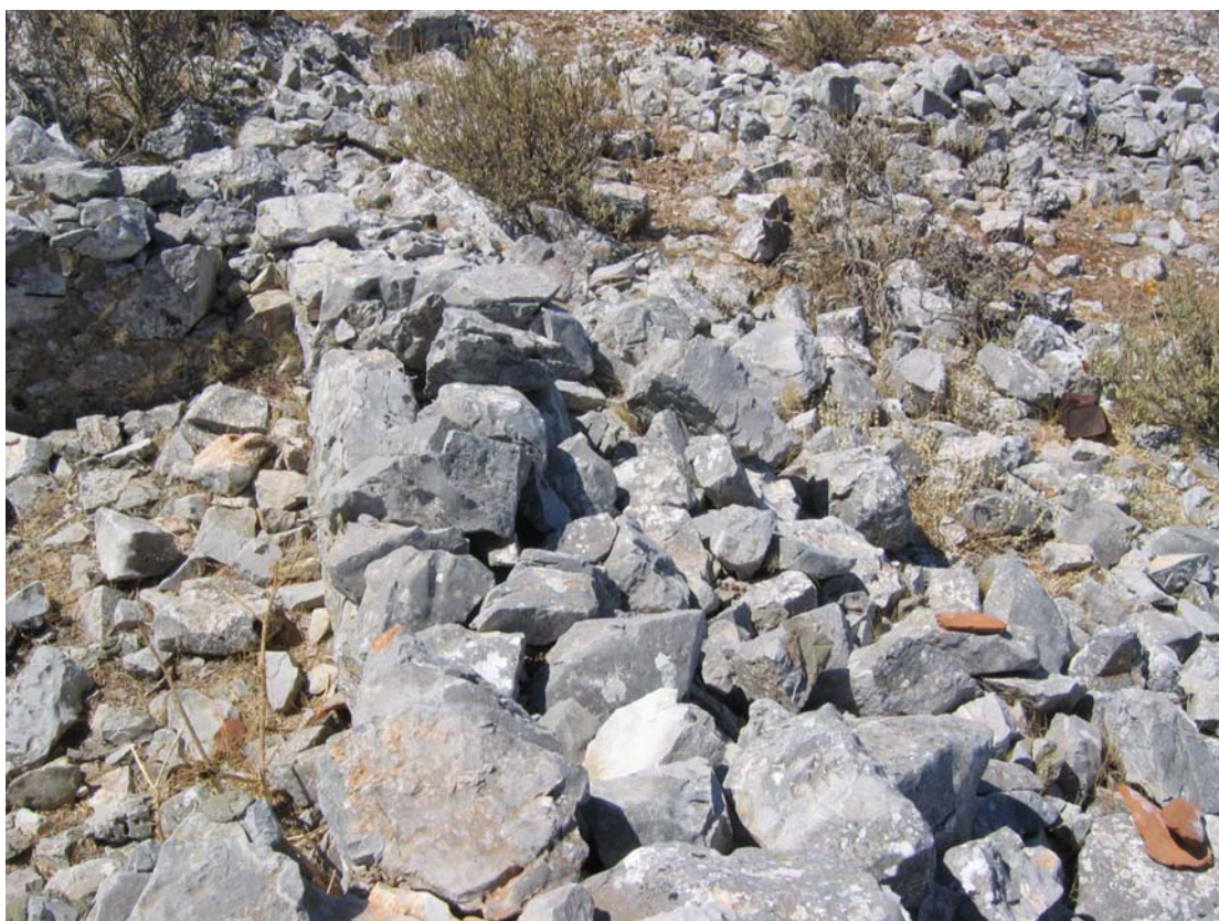
Φώτο. 27 Ο βόρειος τοίχος του κτισματος 3
