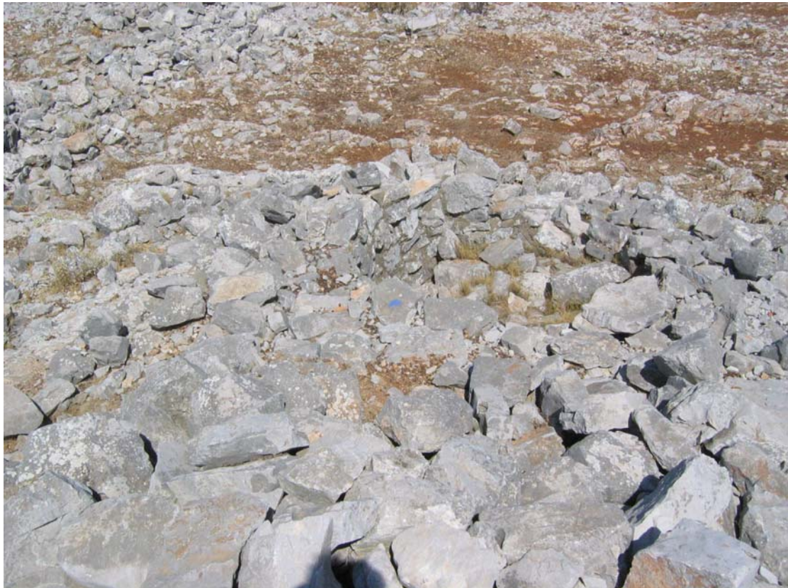
Φώτο. 20 Κατασκευή Α2
