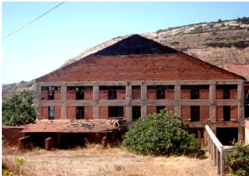
Εικόνα 2: Τμήμα της Βορεινή όψης του εργοστασίου.
