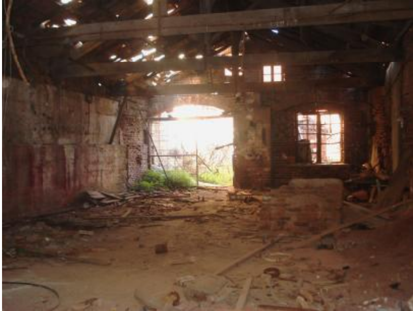
Εικόνα 64: Εσωτερικό εργοστασιακού χώρου.
