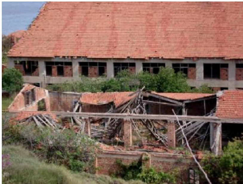
Εικόνα 7: Τμήμα δυτικής όψης.
