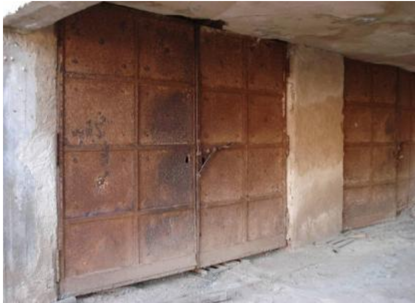
Εικόνα 52: Μεταλλική πόρτα αποθηκευτικού χώρου.
