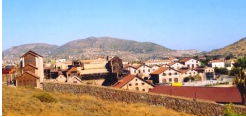
Εικόνα 168: Γενική άποψη Τεχνολογικού Πάρκου.
