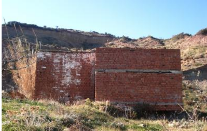
Εικόνα 26: Δεξαμενή νερού στον υπαίθριο χώρο του ανατολική πλευρά του εργοστασίου, δίπλα στα ορυχεία.
