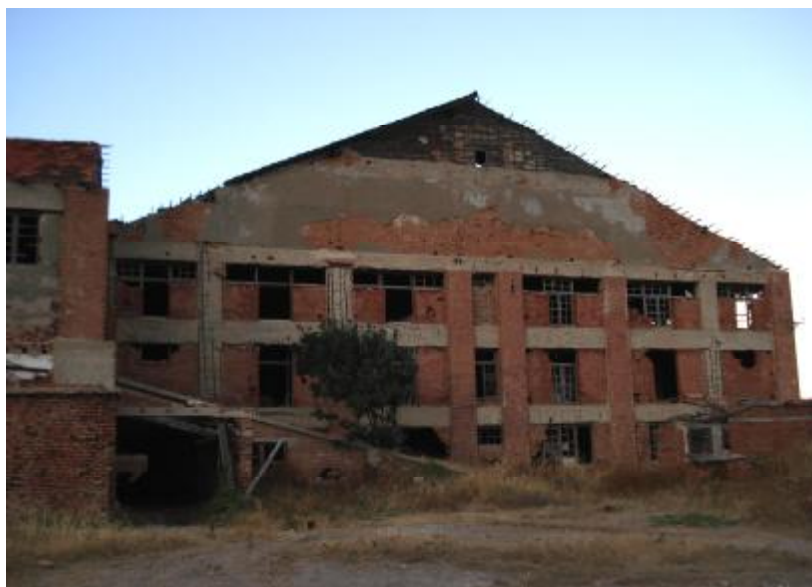
Εικόνα 11: Τμήμα νοτινής όψης.
