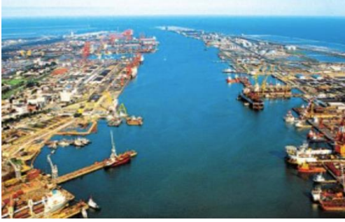
Εικόνα 6: Το λιμάνι του Tianjin
