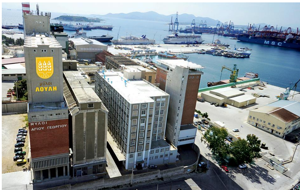
Εικόνα 2: Οι εγκαταστάσεις στο Κερατσίνι
