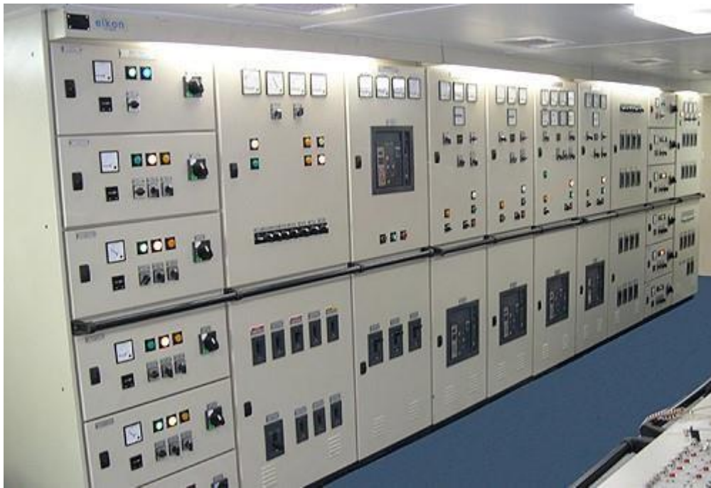
Σχήμα 3.11: Τυπικό κέντρο διανομής [ https://marinersdigest.blogspot.gr/2015/08/isolated-and-earthed-neutral-system.html ]
