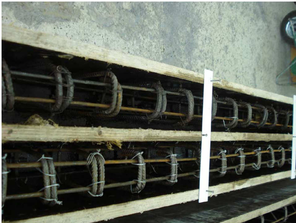
Εικόνα 2α καλούπια με τοποθετημένο οπλισμό για την κατασκευή δοκαριών
