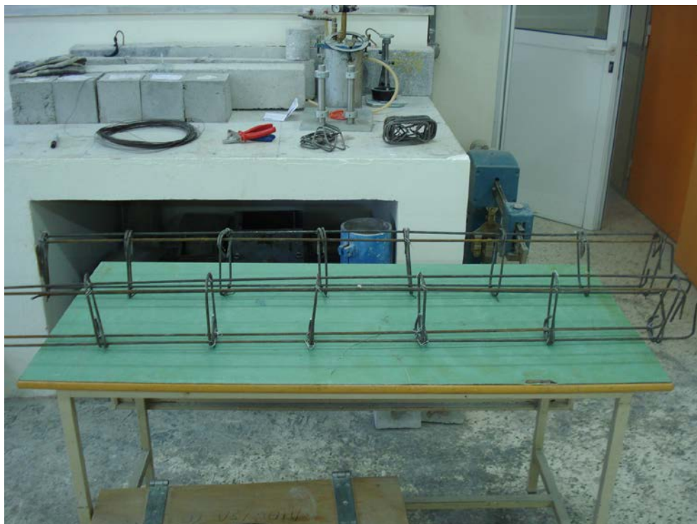
Εικόνα 1 κατά την κατασκευή του κλωβου
