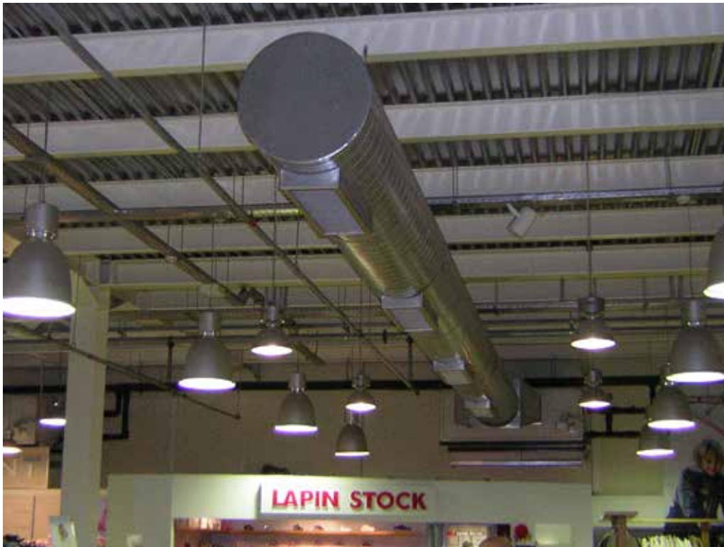
19) ΒΛΕΠΟΥΜΕ ΣΤΗΝ ΟΡΟΦΗ ΣΩΛΗΝΕΣ ΕΡΓΟΣΤΑΣΙΟΥ
