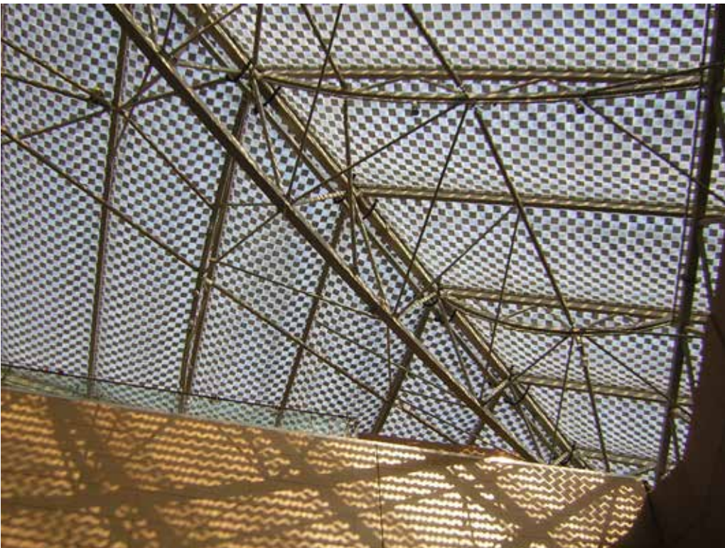
12) ΣΤΕΓΑΣΗ ΑΠΟ ΕΝΑ ΝΕΟ ΠΟΛΥΚΑΡΒΟΝΙΚΟ ΥΛΙΚΟ ΤΟ ΕΤΦΕ ΩΣΤΕ ΝΑ ΕΠΙΤΥΓΧΑΝΕΤΑΙ Η ΦΥΣΙΚΗ ΦΩΤΕΙΝΟΤΗΤΑ ΚΑΙ ΝΑ ΕΞΑΣΦΑΛΙΖΕΤΑΙ Η ΑΝΕΣΗ ΤΟΥ ΜΕΓΑΛΟΥ ΕΣΩΤΕΡΙΚΟΥ ΥΨΟΥΣ
