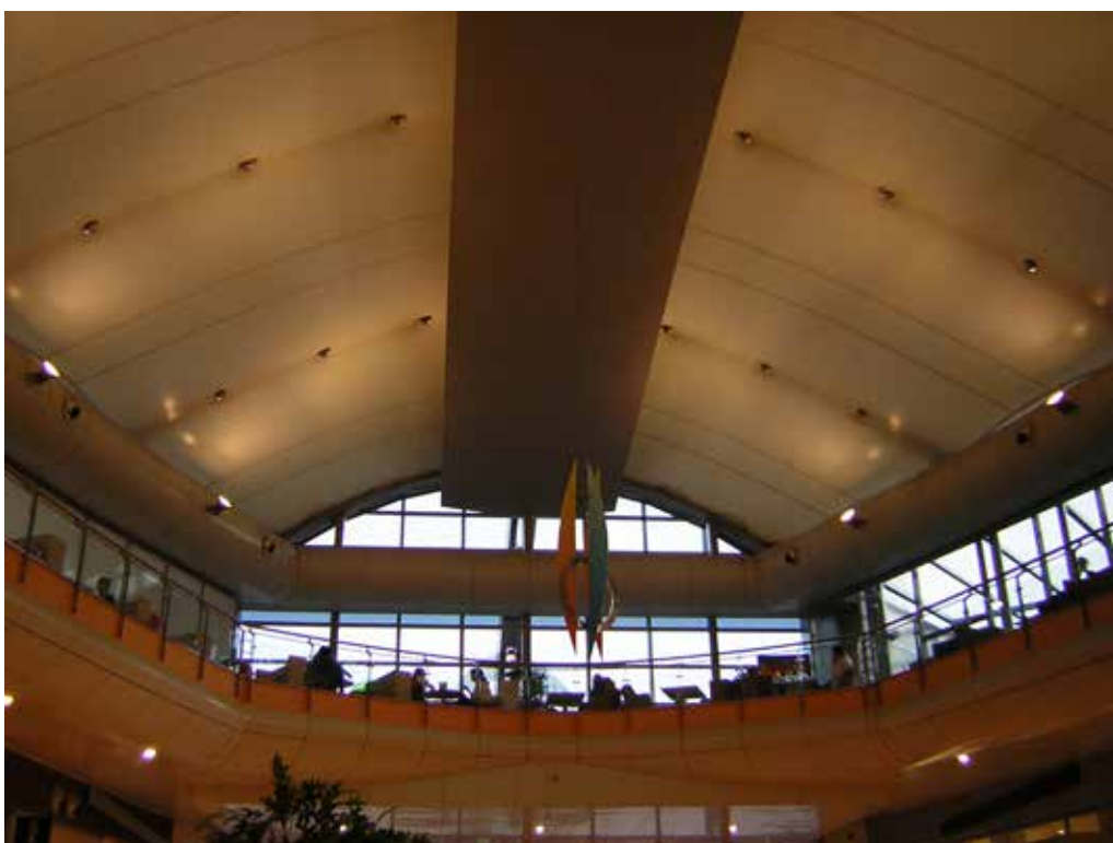
12) Η ΕΝΤΥΠΩΣΙΑΚΗ ΑΝΟΙΓΟΚΛΕΙΟΜΕΝΗ ΣΤΕΓΗ ΠΟΥ ΘΑ ΔΙΑΘΕΤΕΙ ΚΑΙ Η ΟΠΟΙΑ ΘΑ ΦΕΡΕΙ ΑΙΣΘΗΤΗΡΕΣ ΒΡΟΧΗΣ ΠΟΥ ΘΑ ΔΙΝΟΥΝ ΕΝΤΟΛΗ ΓΙΑ ΤΟ ΚΛΕΙΣΙΜΟ ΤΗΣ ΣΕ ΠΕΡΙΠΤΩΣΗ ΚΑΚΟΚΑΙΡΙΑΣ.
