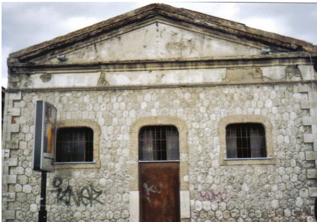
ΕΙΚ. 12 Πρόσοψη Β' πτέρυγας.
