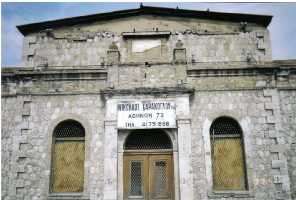
ΕΙΚ. 6 Ανώτερο κεντρικό τμήμα της πρόσοψης από την οδό Πειραιώς.
