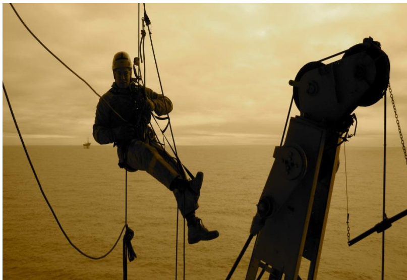
Εικόνα 3.1 – Επιθεώρηση πλωτού γερανού (AXIOM NTD Ltd)
