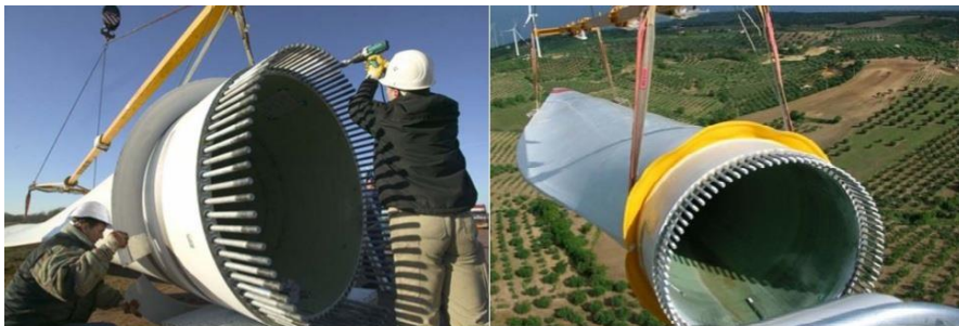
Εικόνα 39: Πτερύγια ανεμογεννήτριας-προετοιμασία πριν την τοποθέτηση [Πηγή: Καλαντζής, 2008]
