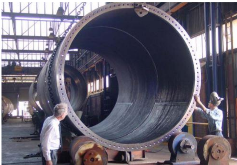
Εικόνα 49: Συγκόλληση τμημάτων χαλύβδινου πύργου [Πηγή: Καλαντζής, 2008]
