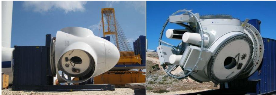
Εικόνα 38: Ρότορας ανεμογεννήτριας-προετοιμασία πριν την τοποθέτηση [Πηγή: Καλατζής, 2008]
