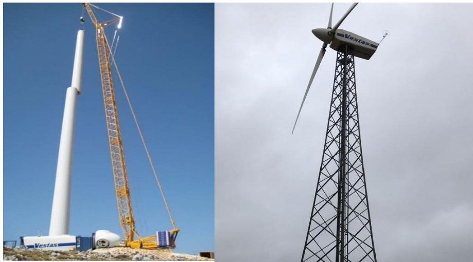
Εικόνα 48: Σωληνωτός και δικτυωτός πύργος [Πηγή: Καλαντζής, 2008]
