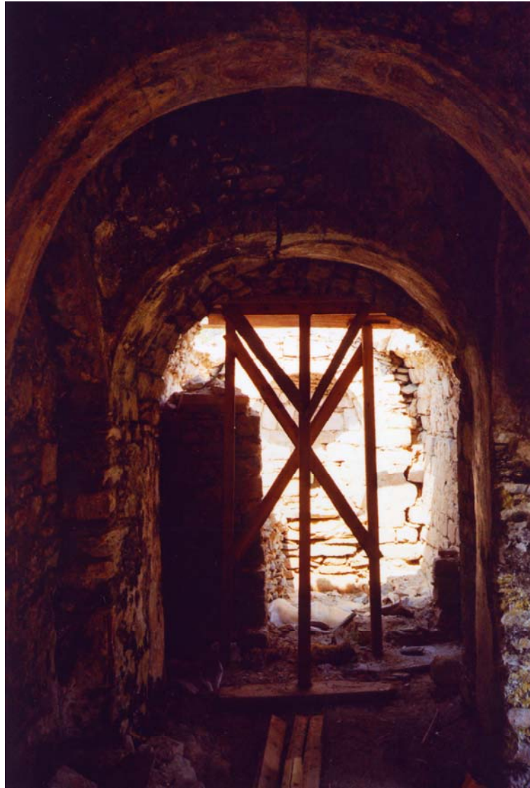
Λεπτομέρειες από την ανακατασκευή του Ιερού Ναού Αγίας Σοφίας, Λαγκάδα
