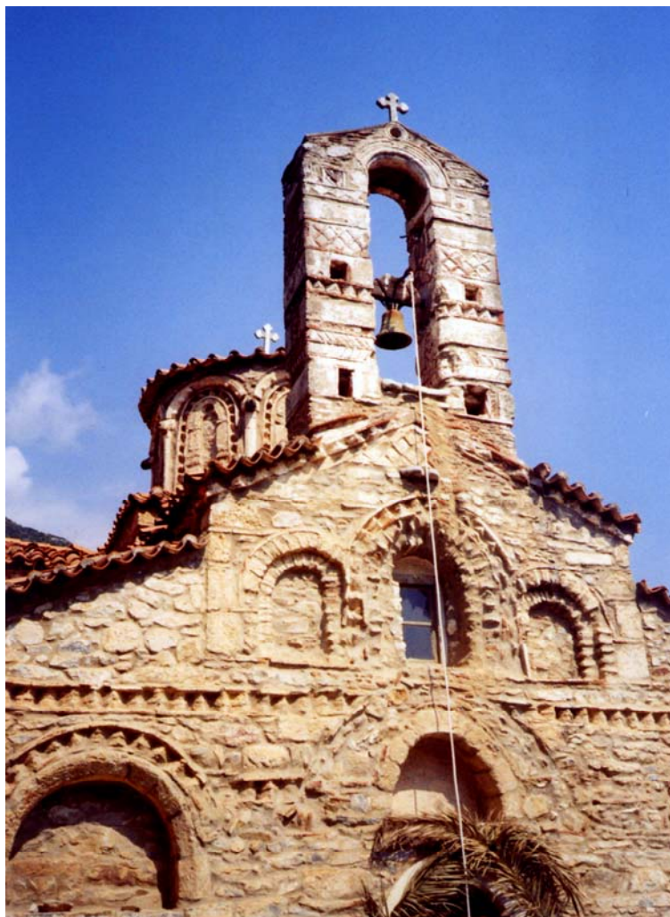
Ιερός Ναός Μεταμόρφωσης του Σωτήρα, Λαγκάδα (Μπλουτσιάνικα)
