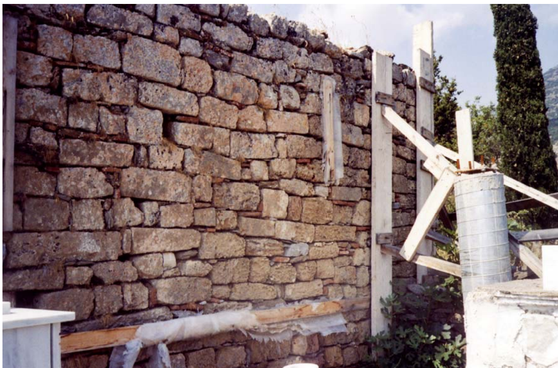
Λεπτομέρειες από την ανακατασκευή του Ιερού Ναού Αγίας Σοφίας, Λαγκάδα
