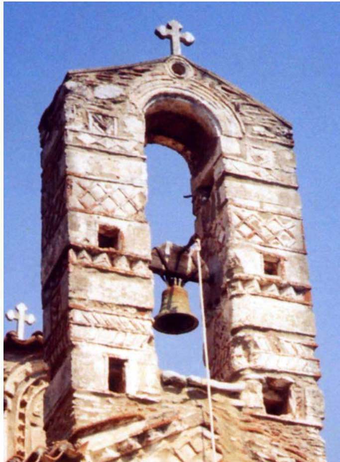
Ιερός Ναός Μεταμόρφωσης του Σωτήρα, Λαγκάδα (Μπλουτσιάνικα)
