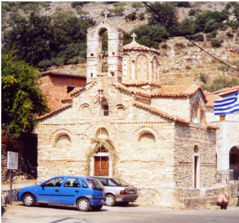
Ιερός Ναός Μεταμόρφωσης του Σωτήρα, Λαγκάδα (Μπλουτσιάνικα)
