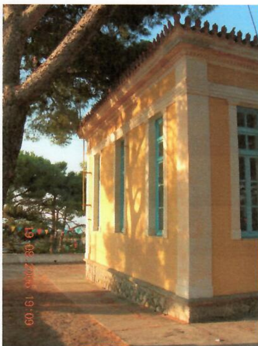
Εικόνα 11: Αποψη της δυτικής όψης του Παρθεναγωγείου
