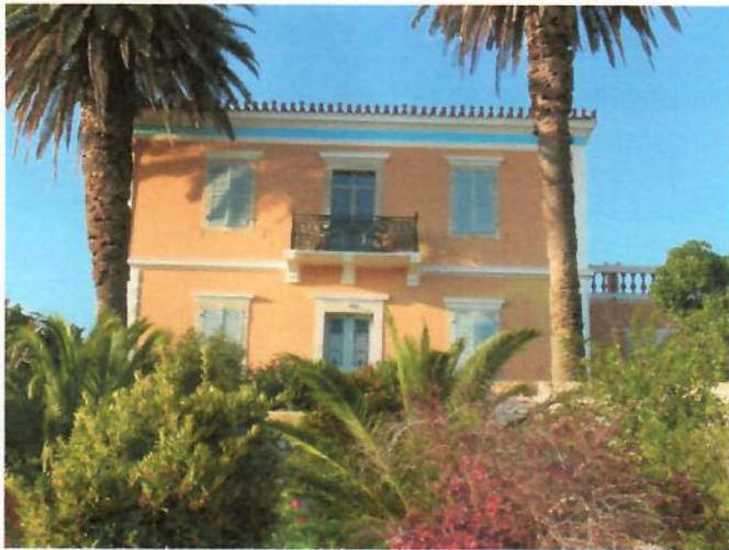
Εικόνα 2: Νεοκλασική κατοικία οικ. Μεγαλοκονόμου (οικισμός Ποταμός Κυθήρων)
