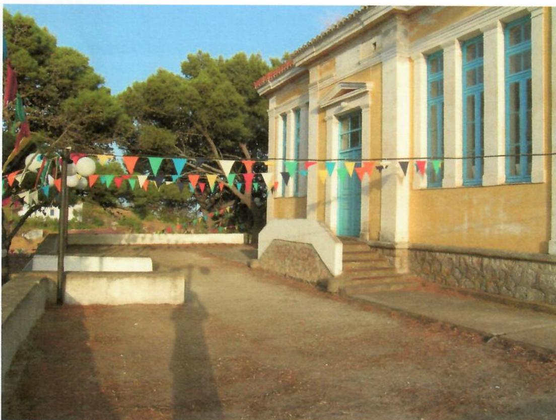
Εικόνα 8: Άποψη της βόρειας όψης του Παρθεναγωγείου
