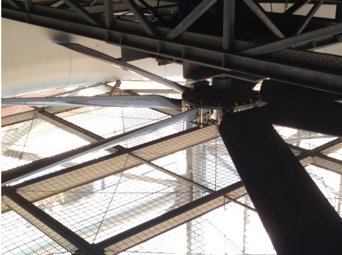
Εικόνα 9.1. Προτεινόμενος τρόπος στήριξης των περνωγίων. (αντικατάσταση των u-bolt με “μπουζόνια”)
