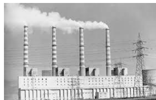
Σταθμός Παραγωγής Ενέργειας
