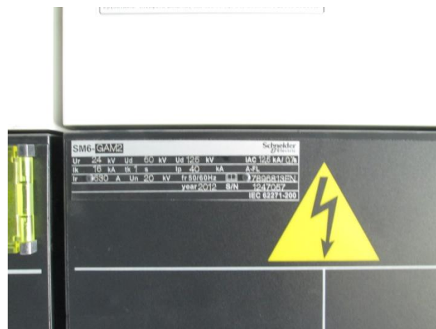
Σχήμα 3. 3: πινακίδα διακόπτη MT στην αναχώρηση
