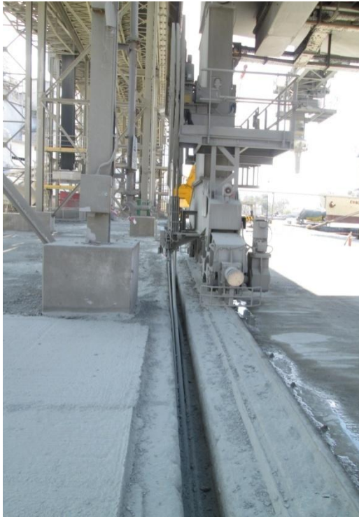
Σχήμα 3. 4: αυλάκι στο οποίο απλώνονται τα καλώδια Χαμηλής τάσης για την τροφοδοσία
