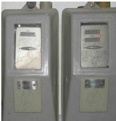
Εικόνα 1: Συμβατικοί επαγωγικοί-μηχανικοί μετρητές από πηγή [18]
