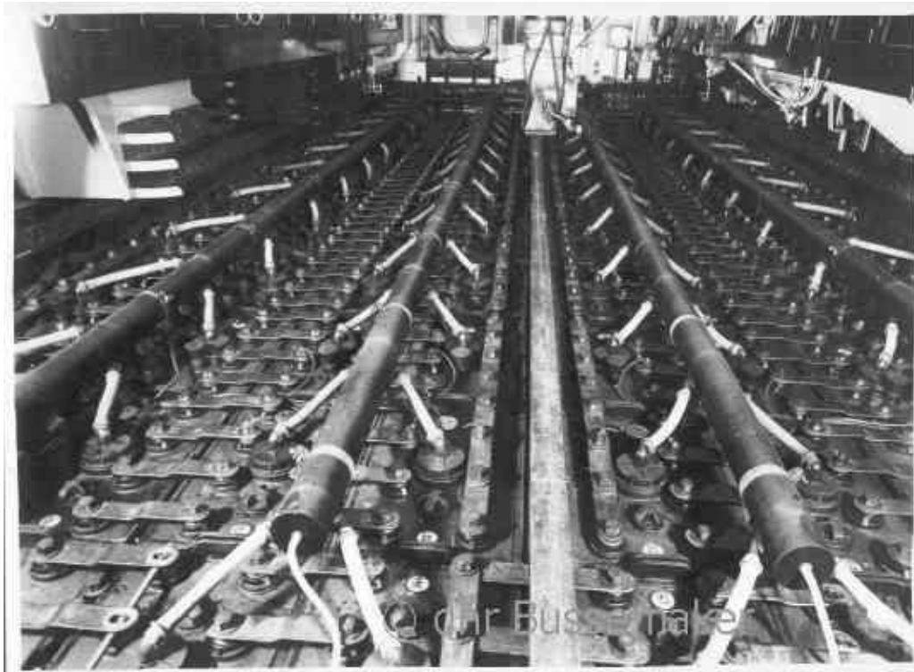
Σχήμα 33α : Ενδεικτική Διάταξη Συστήματος σωληνώσεων αερισμού μπαταριών
