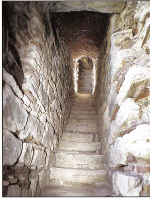
Κτιστή βυζαντινή κλίμακα ανόδου (Πηγή: 12 η εφορεία βυζαντινών αρχαιοτήτων , Το φρούριο του Πυθίου και το έργο της αποκαταστάσεως του .)
