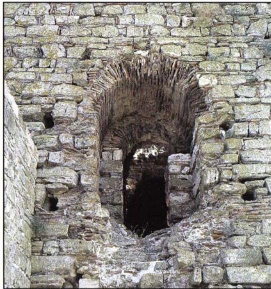
Αμυντικός βυζαντινός εξώστης(Πηγή: 12 η εφορεία βυζαντινών αρχαιοτήτων , Το φρούριο του Πυθίου και το έργο της αποκαταστάσεως του .)
