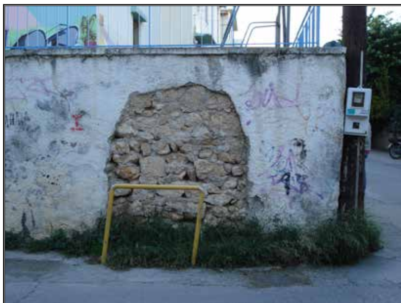
Η κρήνη κατά τις εργασίες μεταφοράς της και το σημερινό αποτύπωμα της στον αυλότοχο του Δημοτικού Σχολείου.
