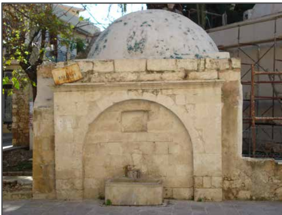
Η βόρεια κρήνη επί της οδού Αρκαδίου.
