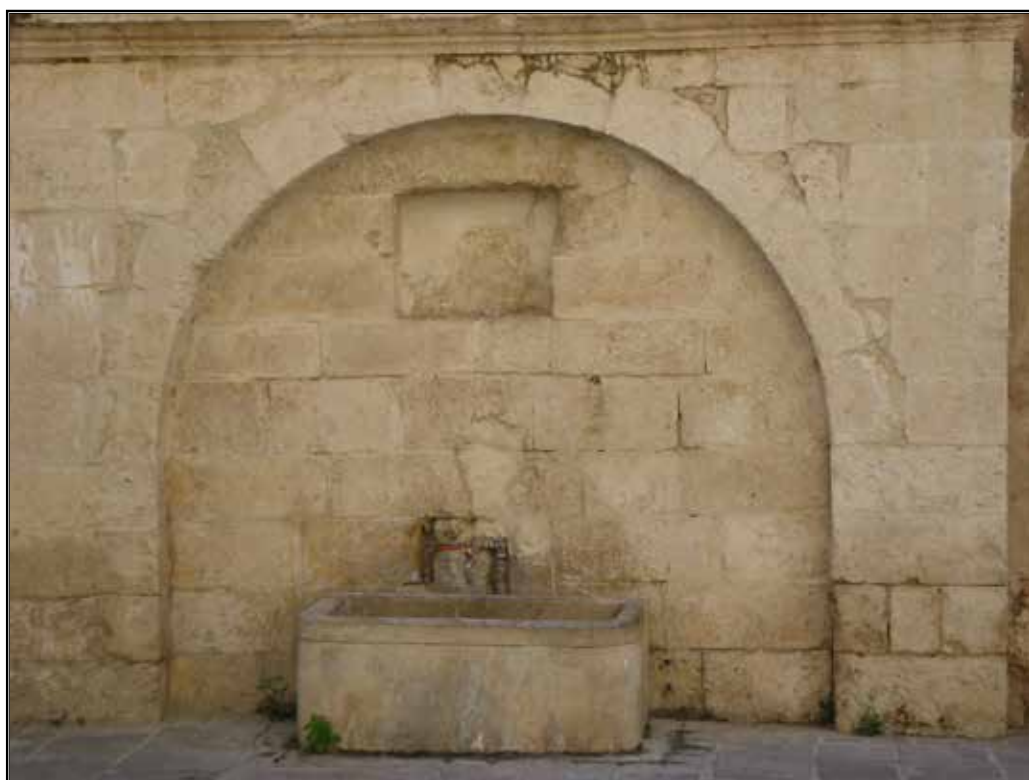
Η βόρεια κρήνη επί της οδού Αρκαδίου.
