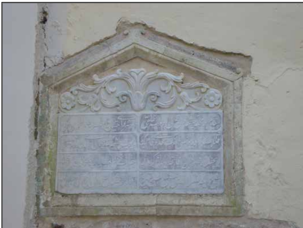
Η επιγραφή της κρήνης, πριν και μετά τον καθαρισμό της.
