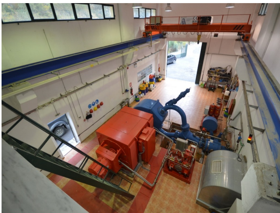
Εικόνα Π.4: Εσωτερική όψη κτηρίου ΜΥΗΕ
