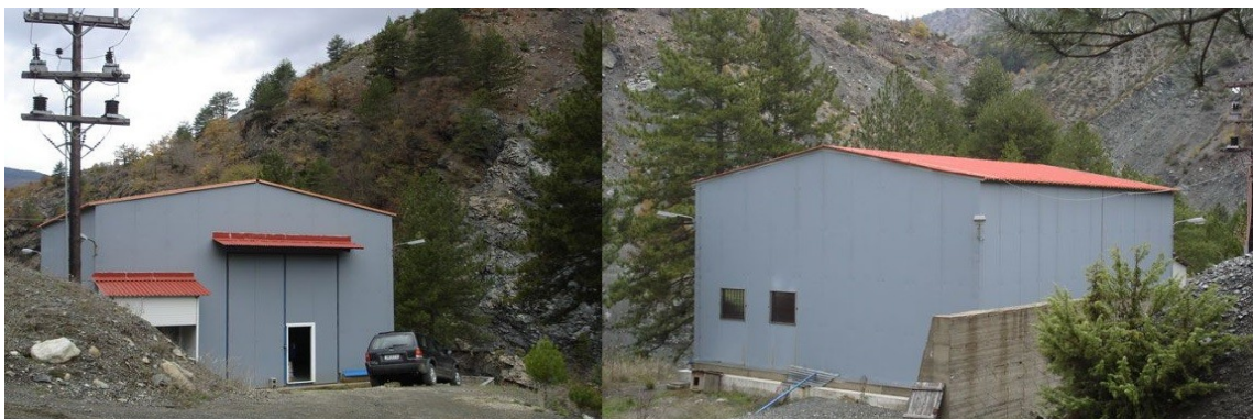
Εικόνα 6.8:Κτήριο ΜΥΗΕ Δίστρατον [35]
