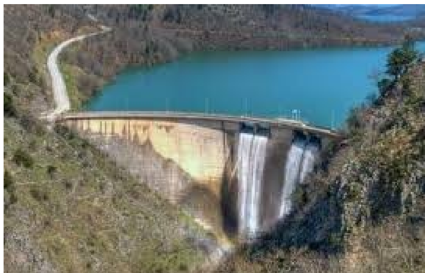
Εικόνα 2.7:Ενεργοποίηση υπερχειλιστών φράγματος Ταυρωπού
