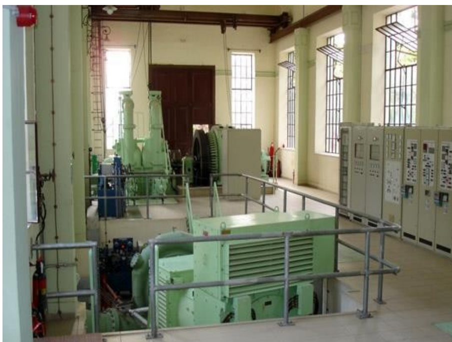
Εικόνα Π.2: Εσωτερική όψη του κτηρίου ΜΥΗΕ
