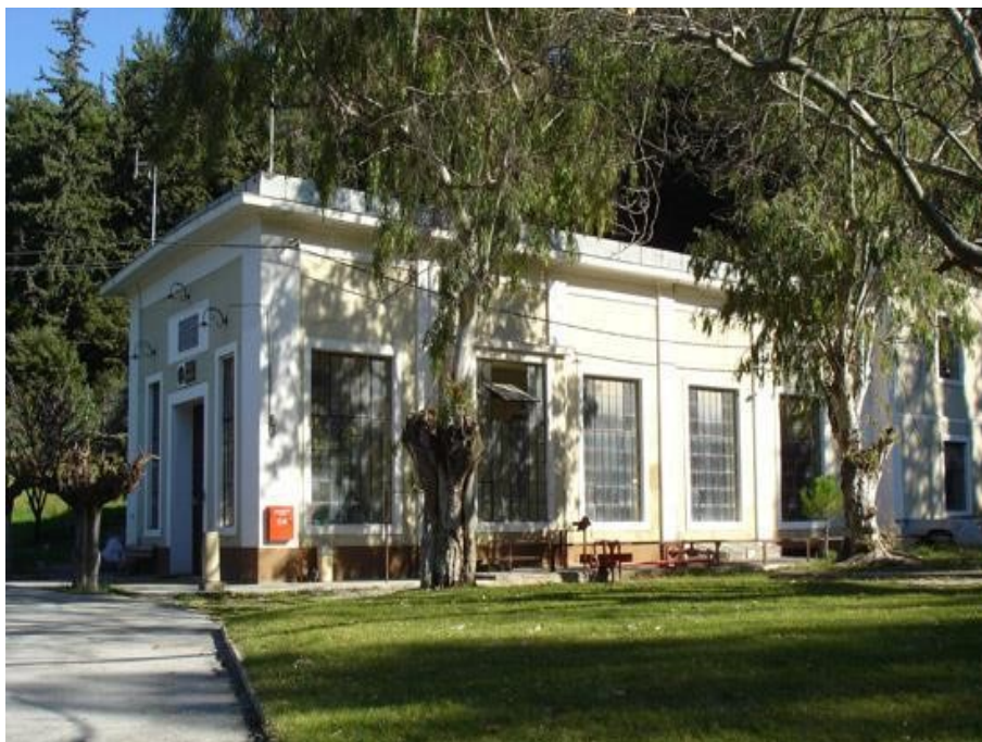
Εικόνα Π.1: Εξωτερική όψη κτηρίου ΜΥΗΕ
