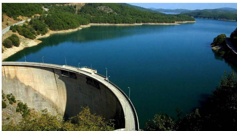
Εικόνα 2.5: Το τοξωτό φράγμα του Ταυρωπού
