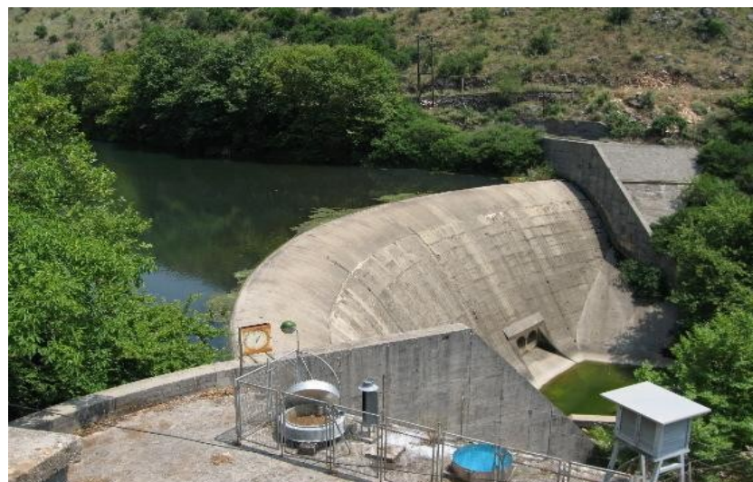
Εικόνα 2.3: Φράγμα σκυροδέματος του Λούρου
