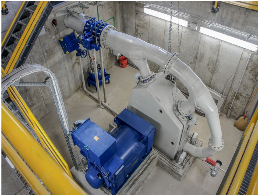
Εικόνα Π.7: Υδροστρόβιλος Pelton οριζόντιου άξονα 3 ακροφυσίων
