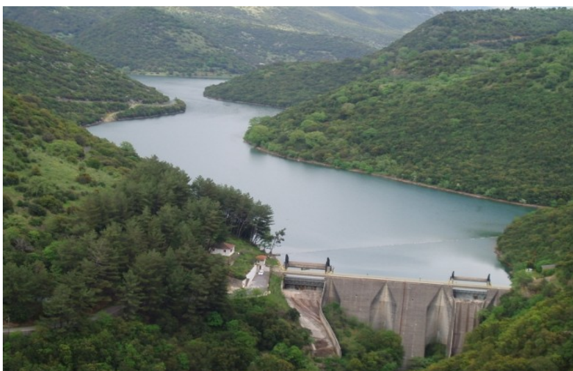
Εικόνα 2.6: Ταμιευτήρας φράγματος Λάδωνα
