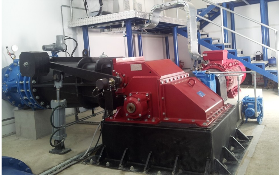
Εικόνα 2.13: Υδροστρόβιλος εγκάρσιας ροής
