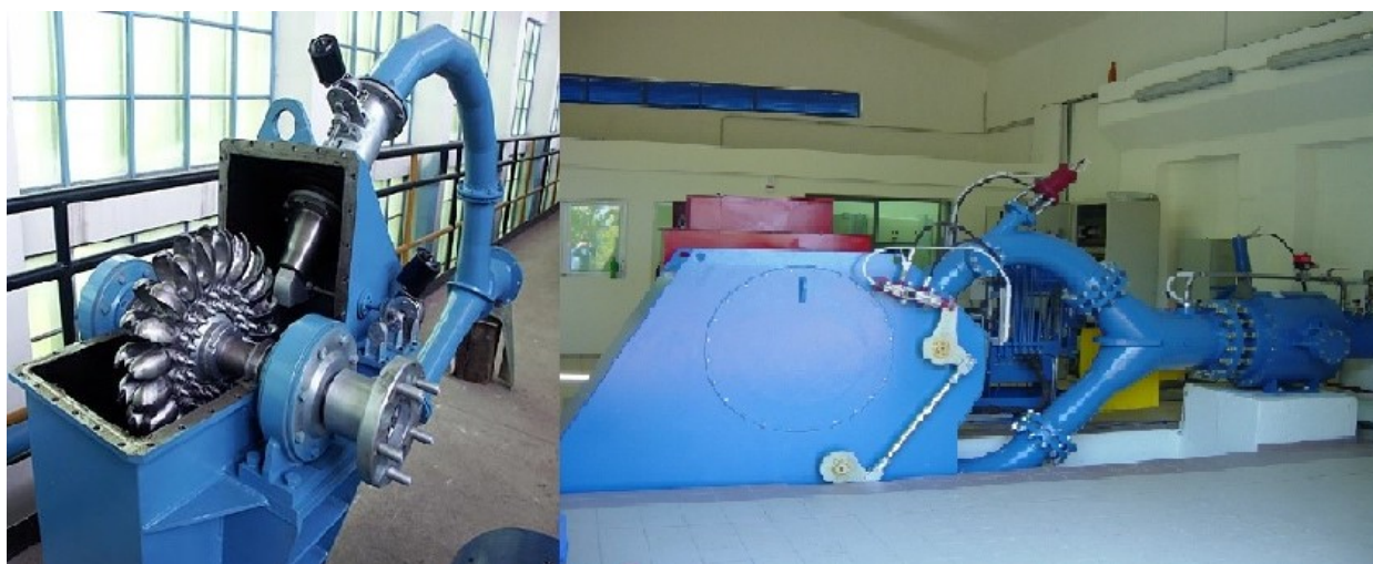
Εικόνα 2.12: Υδροστροβίλος Pelton 2 δεσμίδων
