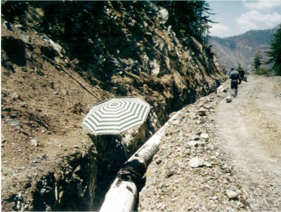
Εικόνα 6.7:Εργασίες θεμελίωσης αγωγού προσαγωγής [35]
