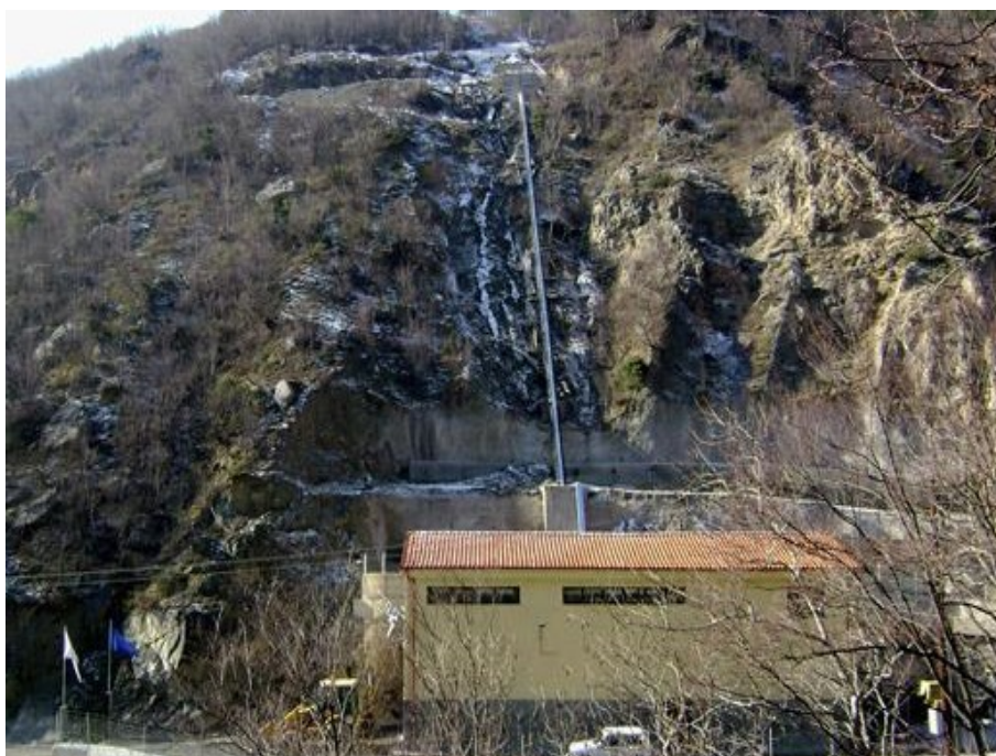
Εικόνα Π.3: Εξωτερική όψη του κτηρίου ΜΥΗΕ
