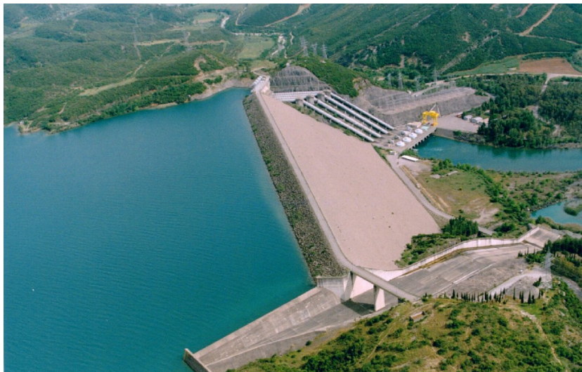
Εικόνα 2.1:Το χωμάτινο φράγμα Καστρακίου
