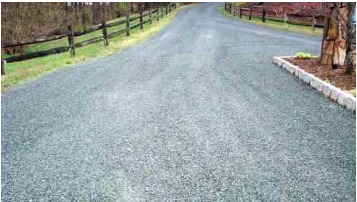
Εικόνα 17 - Χρήση αδρανών από ανακύκλωση για την διάστρωση επαρχιακού δρόμου ήπιας κυκλοφορίας (Πηγή : www.anakem.gr )
