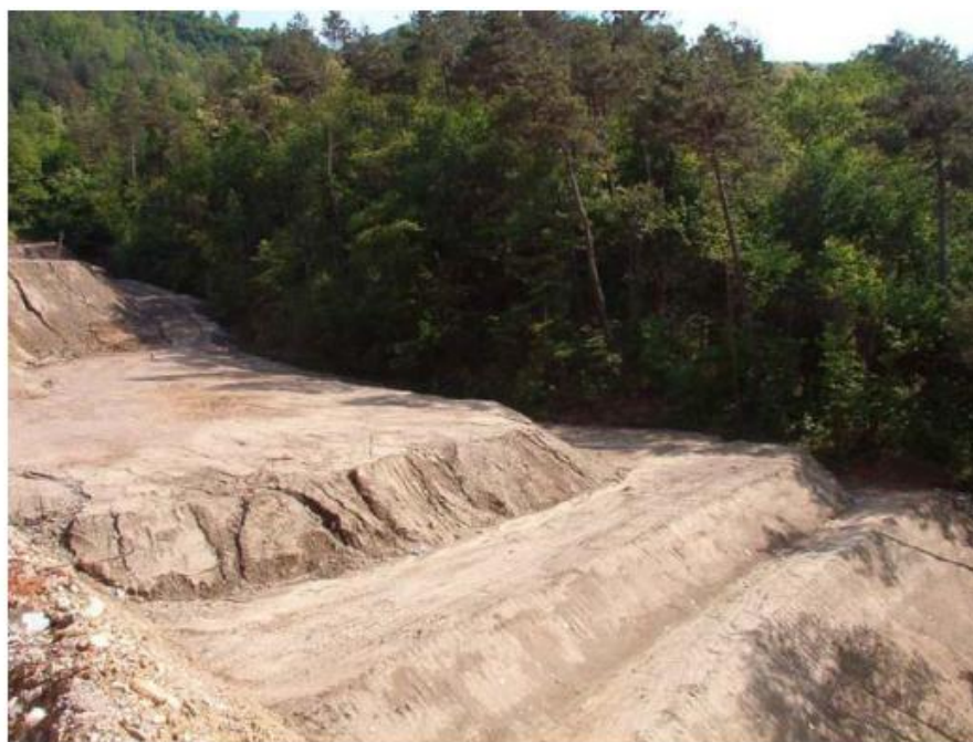
Εικόνα 15 - Χρήση αδρανών από ανακύκλωση για την αποκατάσταση του περιβάλλοντος (Πηγή : www.anakem.gr )
