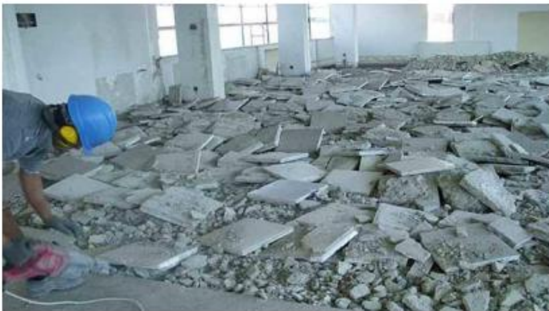
Εικόνα 2 Αφαίρεση πλακών δαπέδου από κτίριο πριν την κατεδάφιση (Πηγή : www.eoan.gr )
