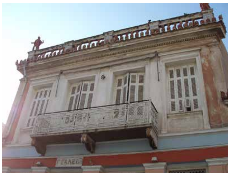
Εικ.4 Κύρια όψη –Εξώστης με φουρούσια και μεταλλικά κιγκλιδώματα
