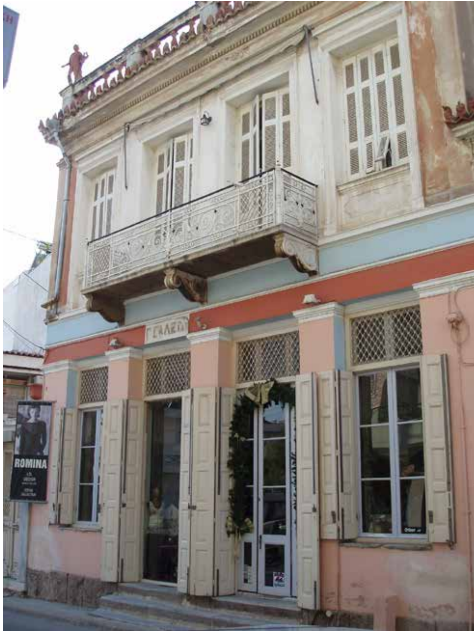
Εικ. 11 Κατάστημα- 1ος Όροφος
