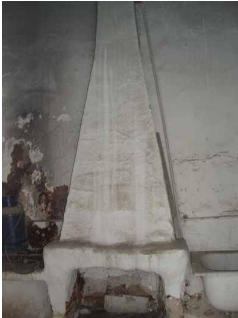
Εικ.21 Εγκαταλελειμμένο τζάκι ισόγειου κτίσματος
