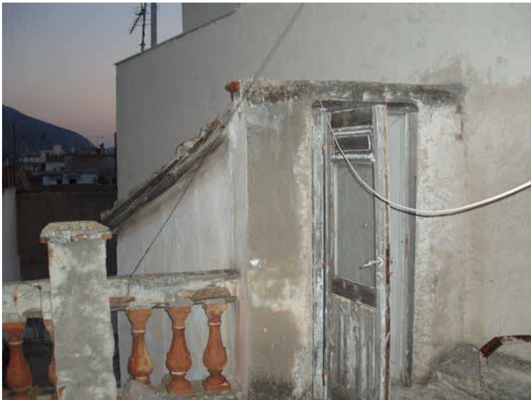
Εικ.53 Πόρτα δώματος
