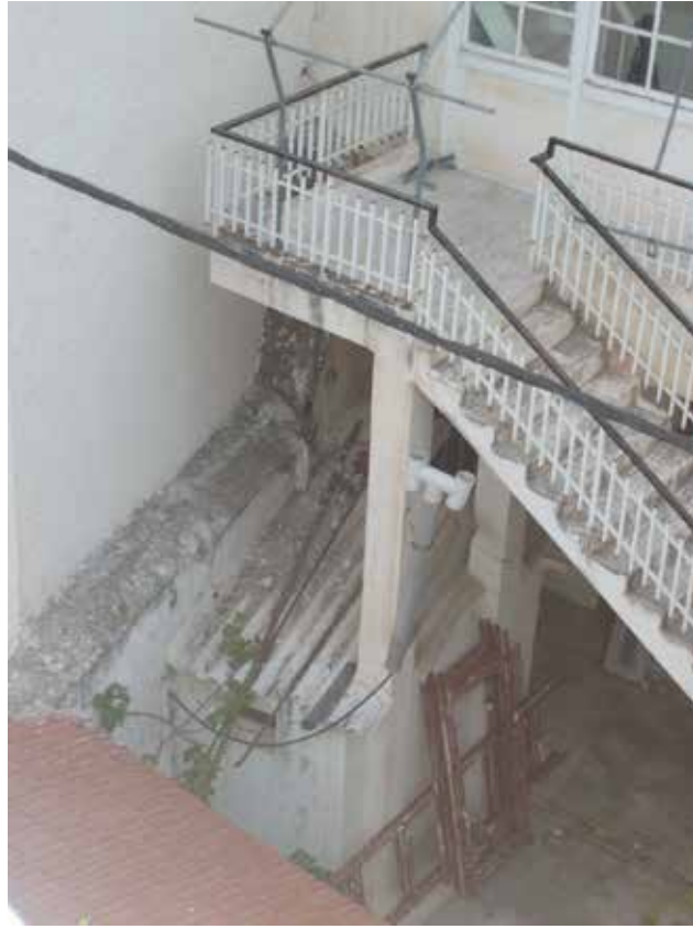
Εικ.28 Κλίμακα- Μικρή κτίσματα στην αυλή
