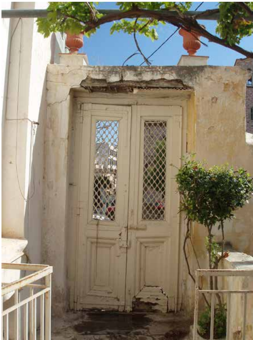
Εικ.15 Κύρια θύρα που οδηγεί στον όροφο και στην αυλή
