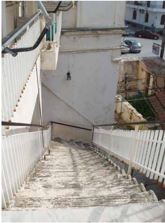
Εικ. 24 Κλίμακα που οδηγεί στον όροφο- Εξωτερικές ηλεκτρο-λογικές εγκαταστάσεις
