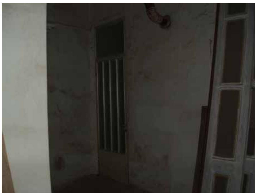
Εικ.17 Είσοδος ισόγειας κατοικίας
