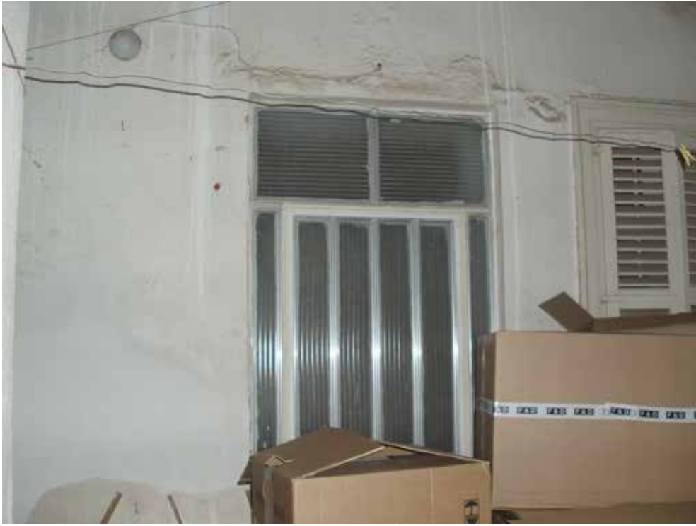
Εικ.18 Είσοδος ισόγειας κατοικίας
