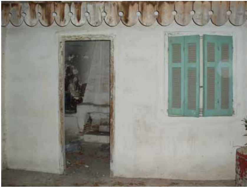
Εικ.19 Ισόγειο κτίσμα
