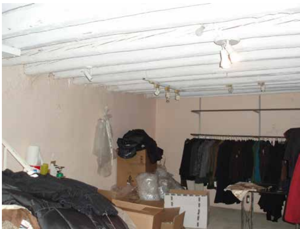
Εικ.50 Υπόγειο- Αποθήκη καταστήματος
