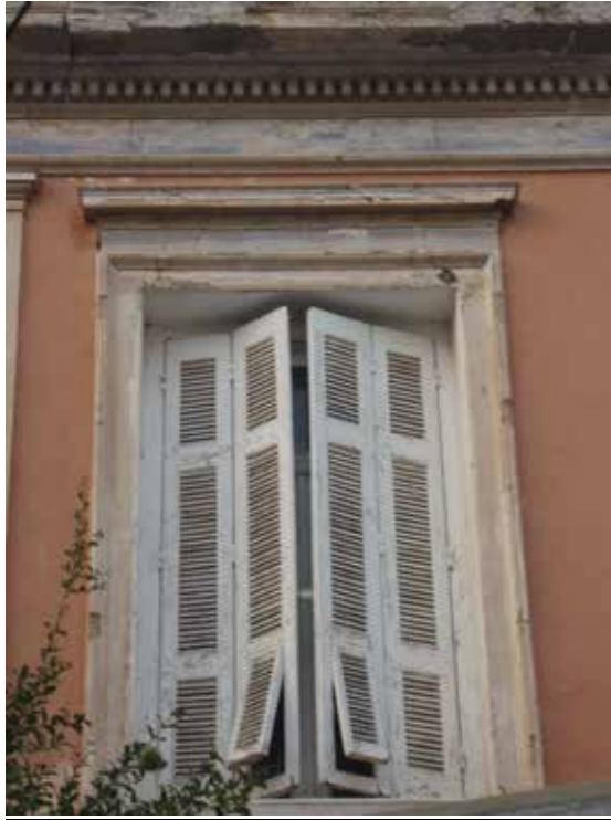
Εικ.36 Παράθυρο ορόφου στην όψη της αυλής
