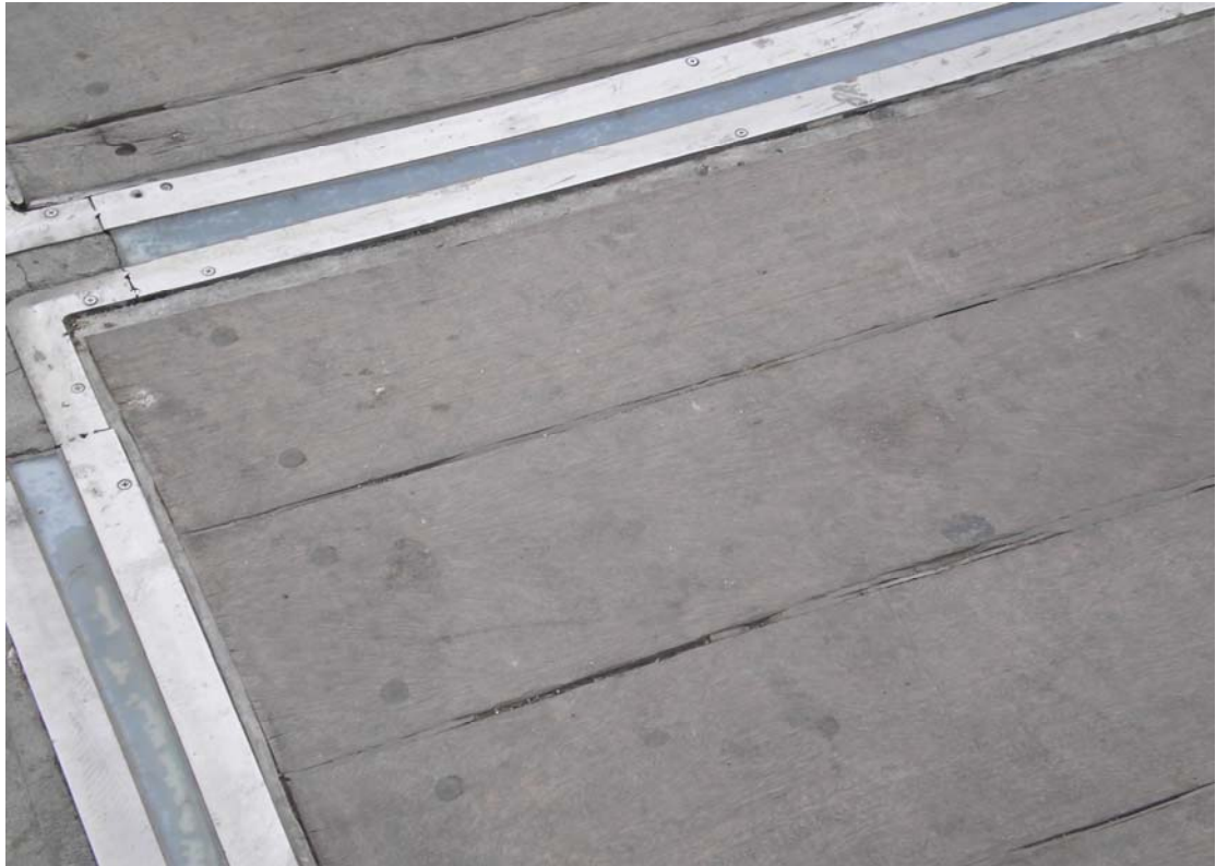
Εικόνα 41. Το ξύλινο δάπεδο η αλλιώς η ξύλινη πασαρέλα που δημιουργήθηκε κάθετα στην οδό Αθηνάς είναι κάπως έτσι. Εδώ ένα πάτωμα στο σαλόνι του σπιτιού έχεις, και κάνης αμάν να το διατηρήσεις σε καλή κατάσταση, φαντάσου όταν αυτό βρίσκεται τοποθετημένο σε πλατεία.
