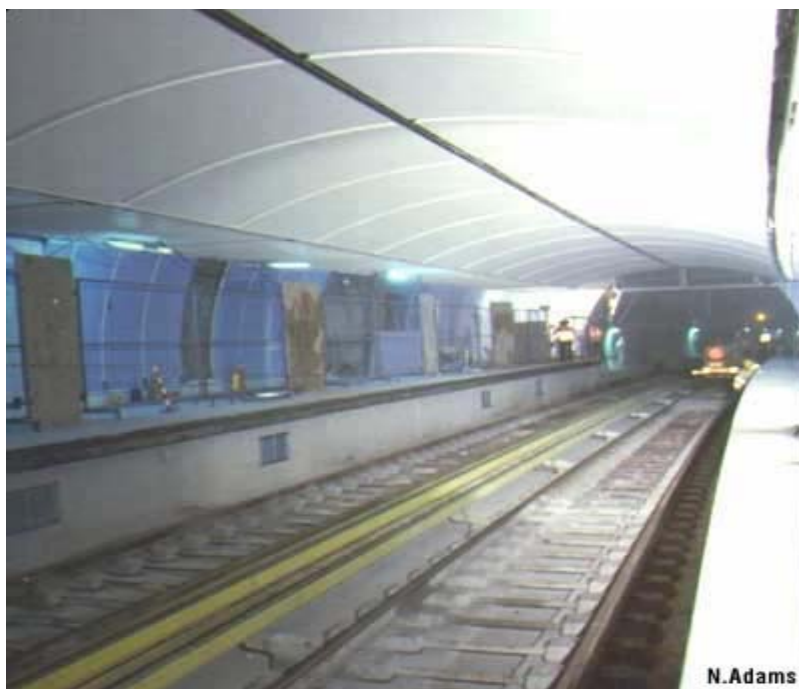
Εικόνα 6 α . Φωτογραφία του ΑΤΤΙΚΟΥ ΜΕΤΡΟΥ Ομόνοιας σε στάδιο κατασκευής. 3
