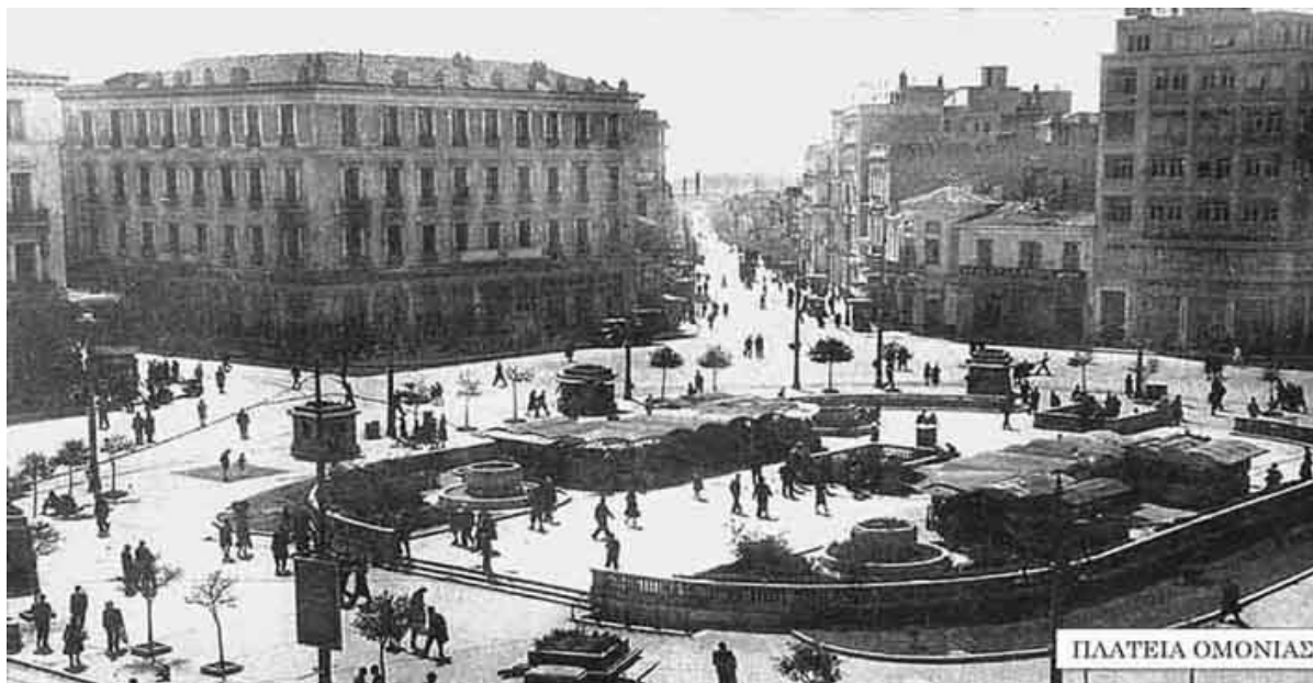
Εικόνα 3. Η κυκλική πλατεία Ομονοίας με περίπτερα για τους ανθοπώλες στο κέντρο της
