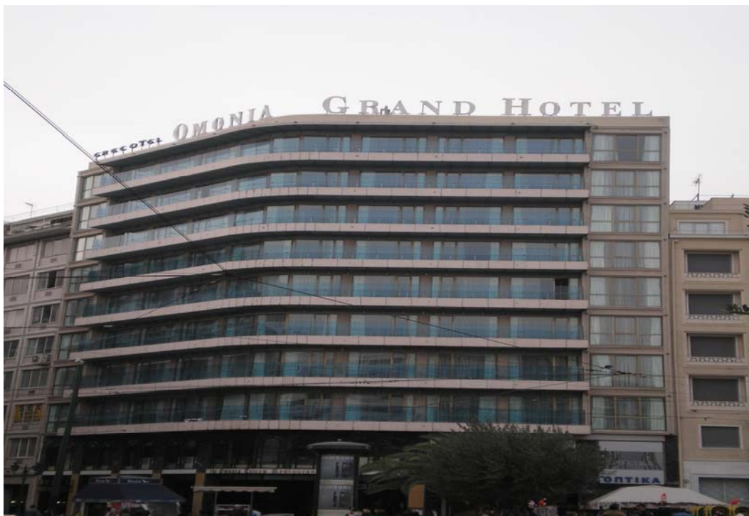
Εικόνα 13. Επιβλητικό κτίριο το οποίο στεγάζει το ΟΜΟΝΟΙΑ GRAND HOTEL. Στο ισόγειο στεγάζει καταστήματα. Βρίσκεται στην αρχή του Πειραιώς.
