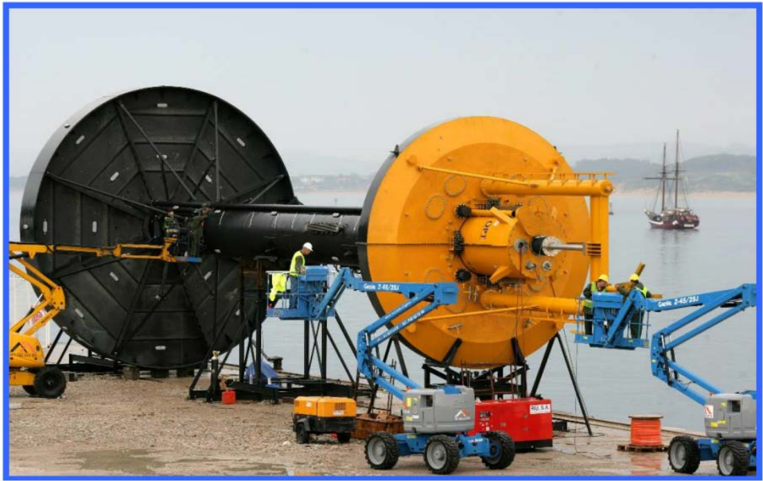
Εικόνα 32 Συναρμολόγηση τουρμπίνας Seagen.
