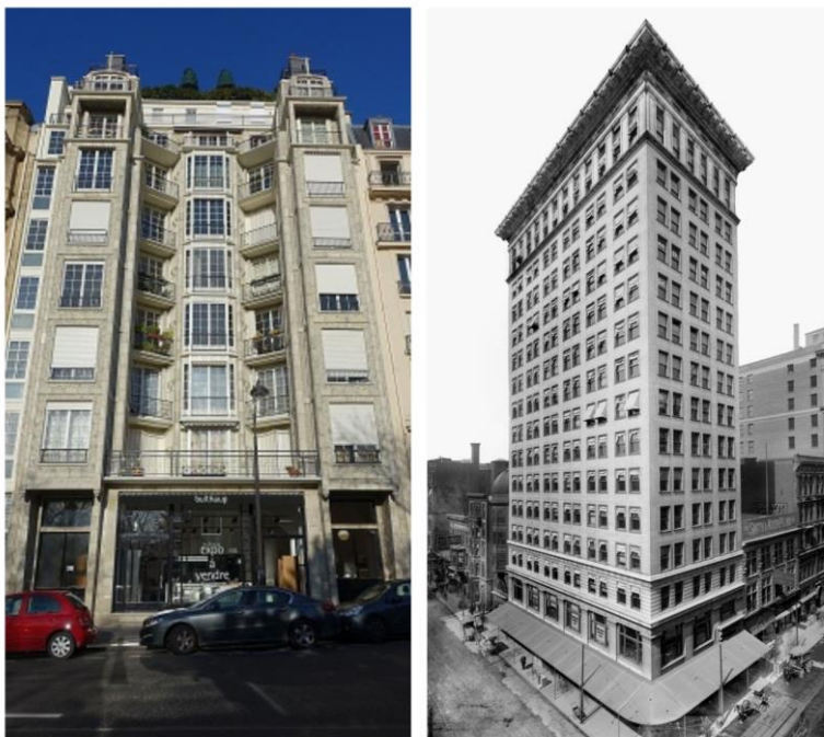
Εικόνα 1/ 2: Αριστερά- το κτίριο στο νούμερο 25 της Rue Franklin, Auguste Perret, Παρίσι / Δεξιά- πρώτος ουρανοξύστης από σκυρόδεμα, Cincinnati Οχάιο
