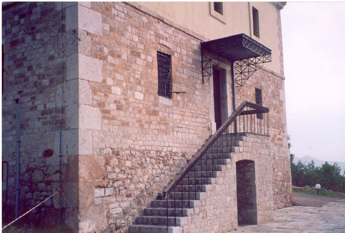
Εικ. 8.9 Η νότια όψη έχει μία είσοδο στο υπόγειο (που βρίσκεται στο ύψος του φυσικού εδάφους) και μία στο ισόγειο, που οδηγεί πέτρινη εξωτερική κλίμακα.
