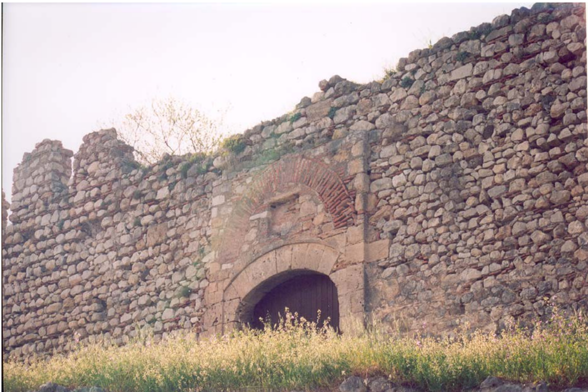
Εικ. 5.6 Εξωτερική όψη της Βορειοανατολικής (παλαιάς) κυρίας εισόδου του Κάστρου
