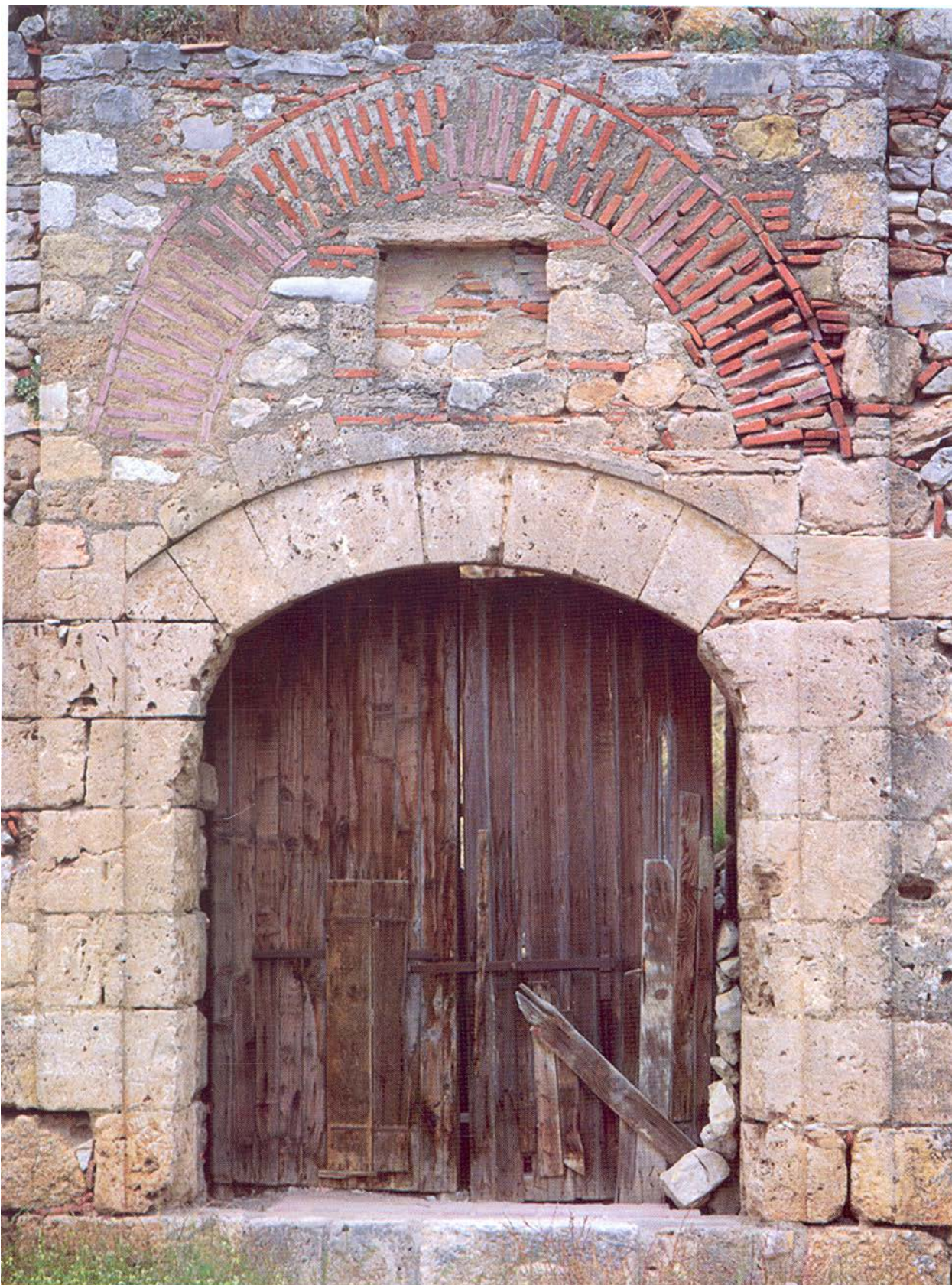
Εικ. 5.4 Εξωτερική όψη της Νοτιοανατολικής κύριας πύλης του Κάστρου. Στο τύμπανο που σχηματίζεται ανάμεσα στο τοξωτό υπέρθυρο και το πλίνθινο ανακουφιστικό τόξο διακρίνεται αβαθής κόγχη όπου μπορεί να ήταν τοποθετημένο ανάγλυφο, οικόσημο ή κτητορική επιγραφή.
