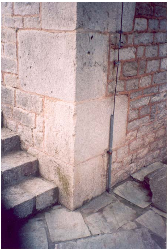
Εικ. 8.13 , 8.14 Παρατηρούμε τους γωνιόλιθους οι οποίοι είναι από διαφορετικό λίθο, πιο σκληρό και σε απόχρωση γκρι-άσπρο και τα πλαίσια των παραθύρων τα οποία είναι κατασκευασμένα από πωρόλιθο σε απόχρωση μπεζ.
