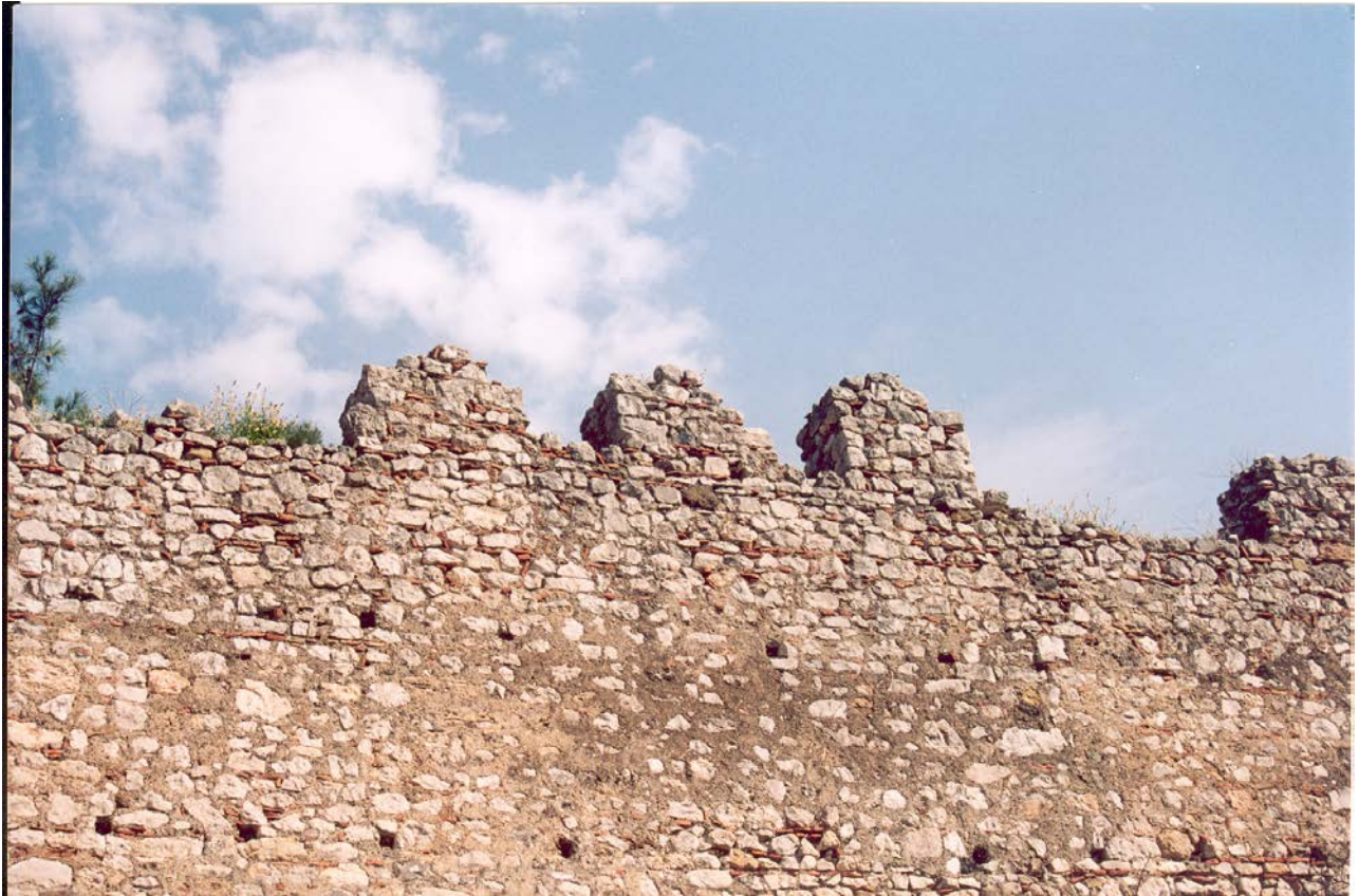
Εικ. 5.3 Άποψη της Δυτικής πλευράς των τειχών, στην οποία είναι εμφανής η χρήση του ασβεστοκονιάματος ως συνδετικού υλικού. Οι συμμετρικές σπές που διακρίνονται κατά μήκος του τείχους έφεραν ξύλα που λειτουργούσαν ως ικριώματα για την κατασκευή του ανώτερου στρώματος του τείχους.
