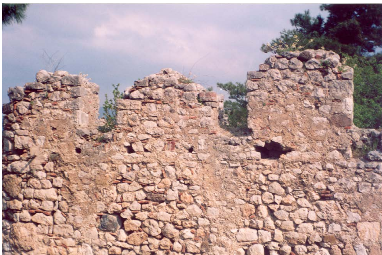
Εικ. 8.4 , 8.5 Τυφεκιοθυρίδες κατά μήκος του περιβόλου.
