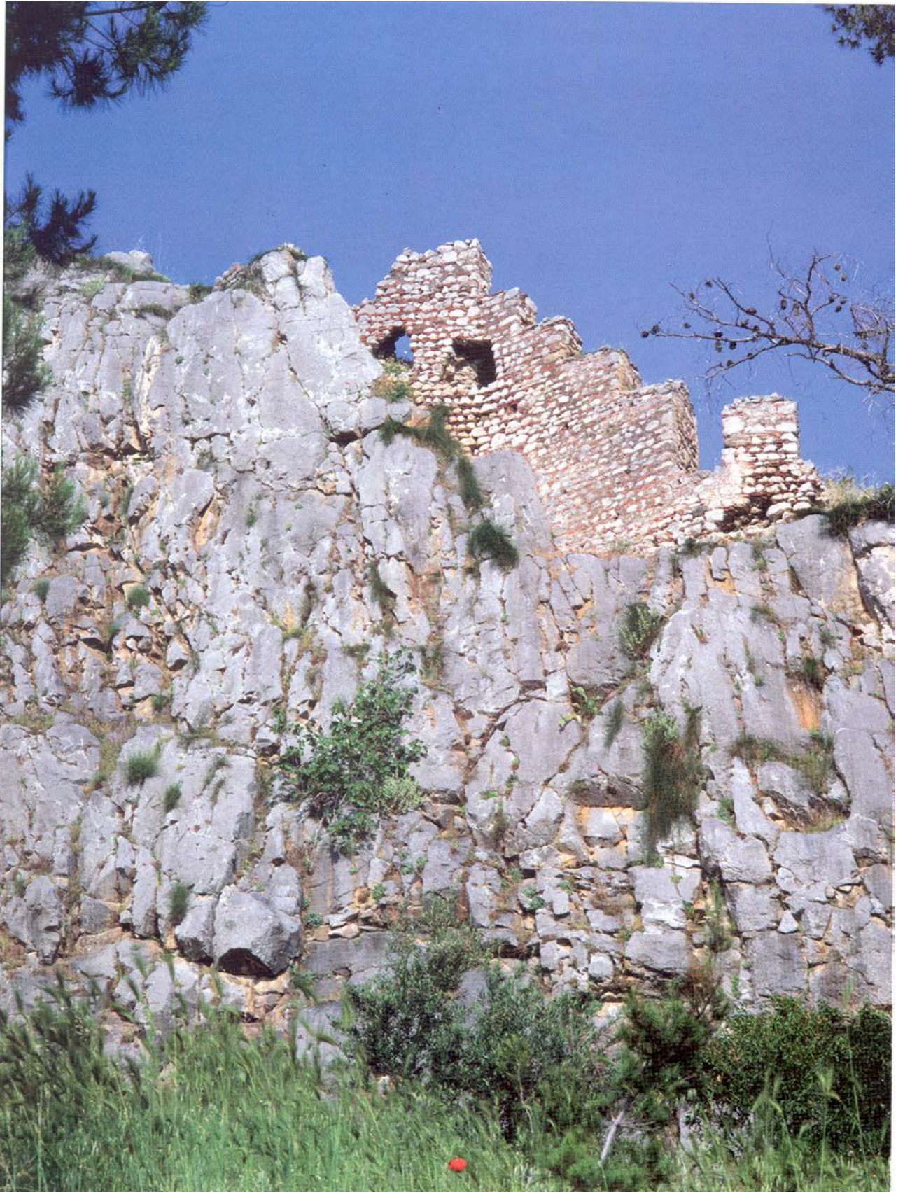
Εικ. 7.3 Τμήμα του οχυρωματικού περιβόλου στη Νοτιοδυτική γωνία του λόφου, θεμελιωμένο πάνω στο βράχο.
