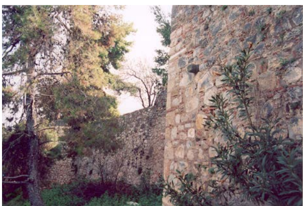
Εικ. 2.3, 2.4 Ηφαιστειογενής λίθος (τόφφος) στη Βορειοανατολική πλευρά των τειχών. Η θέση του στο τείχος φανερώνει ότι πιθανότατα χρησιμοποιήθηκε από τους Καταλανούς ως πάσσαλος για το δέσιμο βοηθητικών σχοινιών, προκειμένου να διευκολύνεται η ανάβαση των λίθων στη δύσβατη πλαγιά. Αυτό μας φανερώνει πως ο τρόπος καθέλκυσης των μεγάλων λίθων σε απόκρημνες πλαγιές και γενικά δύσβατες περιοχές παρέμεινε σχεδόν ίδιος, ακόμα και μετά την πάροδο περισσότερων από 1800 χρόνων.
