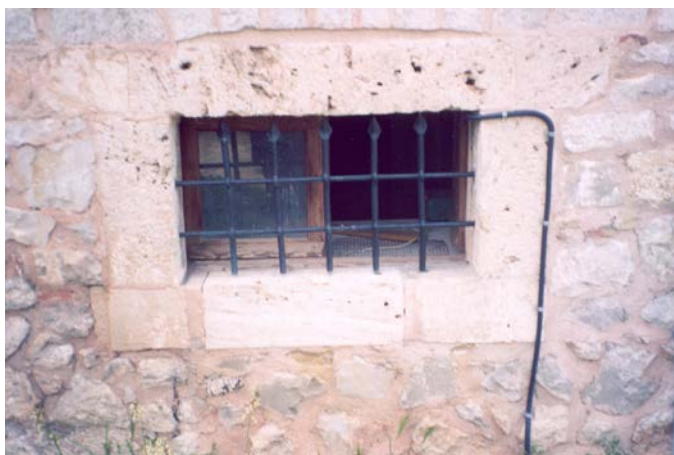
Εικ. 8.13 , 8.14 Παρατηρούμε τους γωνιόλιθους οι οποίοι είναι από διαφορετικό λίθο, πιο σκληρό και σε απόχρωση γκρι-άσπρο και τα πλαίσια των παραθύρων τα οποία είναι κατασκευασμένα από πωρόλιθο σε απόχρωση μπεζ.
