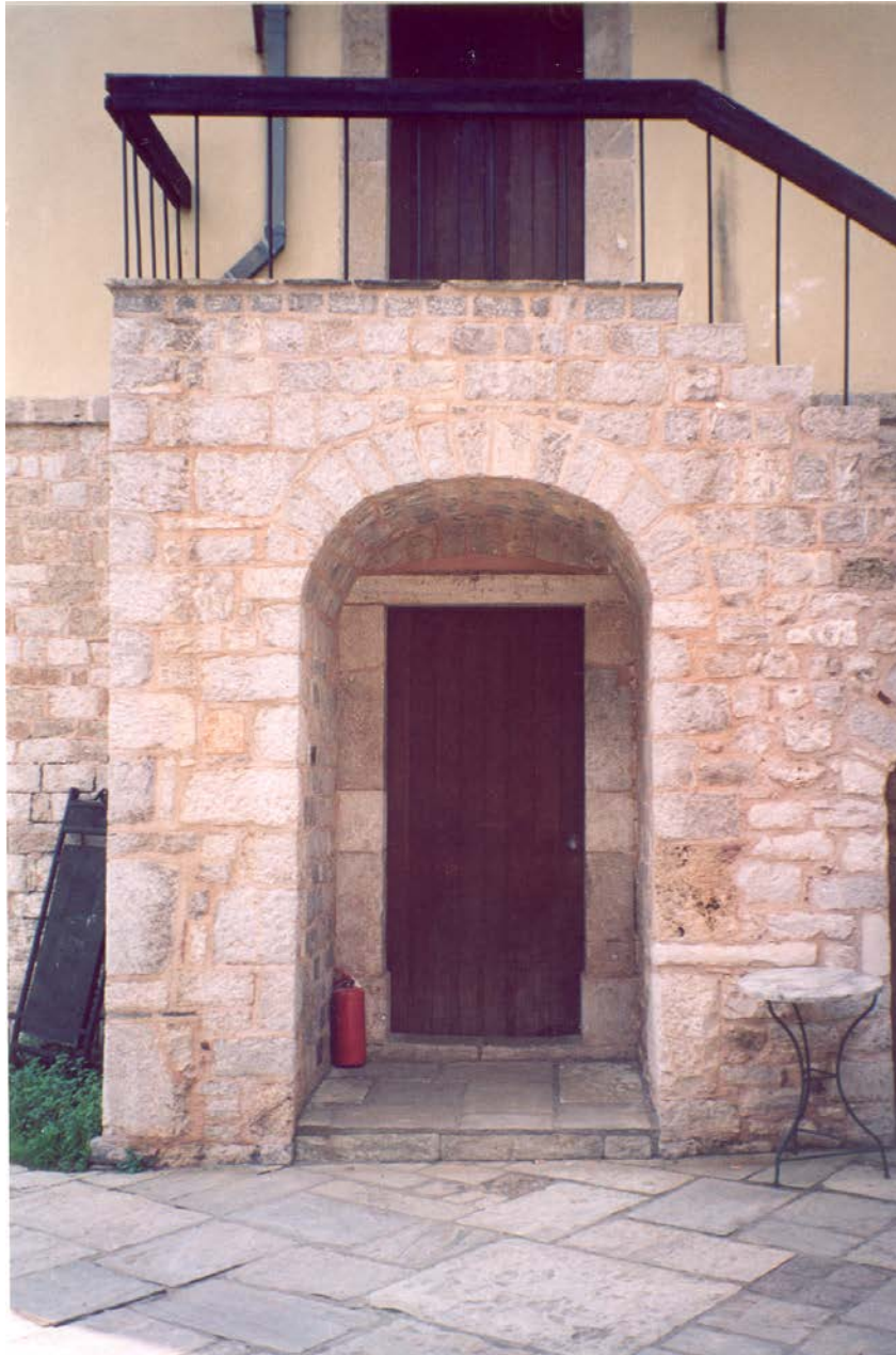
Εικ. 8.10 Η βόρεια όψη φέρει από μια είσοδο στο ισόγειο και στον όροφο, με πέτρινη εξωτερική κλίμακα
