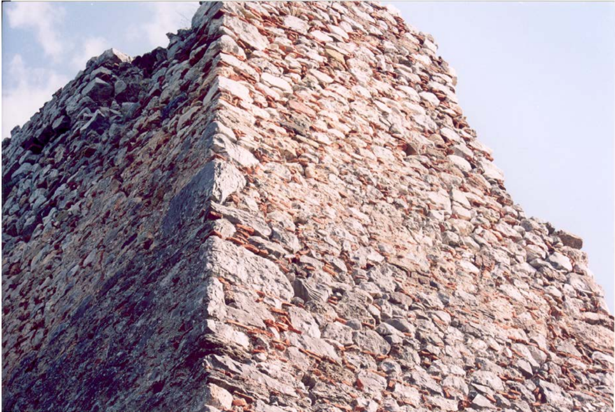
Εικ. 5.2 Πύργος της Βορειοδυτικής γωνίας του Κάστρου, όπου είναι εμφανείς οι Φραγκικές και Καταλανικές προσθήκες (χρήση κεραμικών και αμμοκονιάματος)
