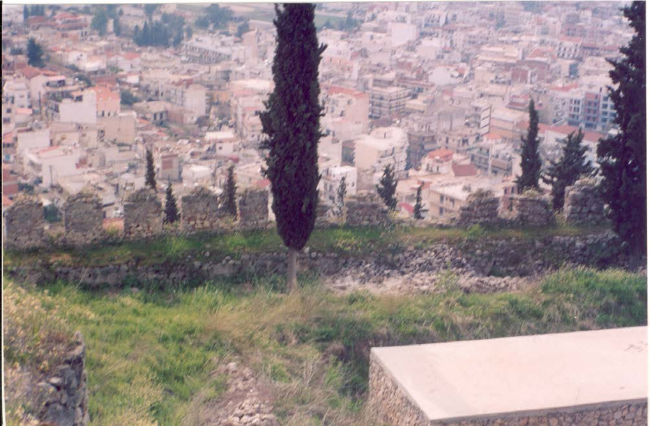
Εικ. 5.9 Καθ' όλη σχεδόν τη ζώνη του περιβόλου, διακρίνονται προσθήκες της περιόδου αυτής και διατηρούμενες πολεμίστρες.
