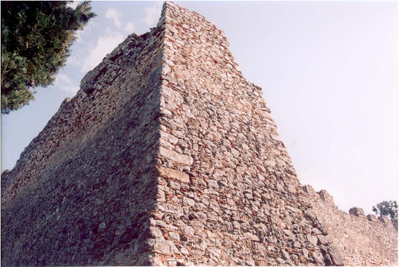
Εικ. 3.2 Η χρήση κεραμοπλαστικών στοιχείων είναι εμφανής σε όλο το Κάστρο
