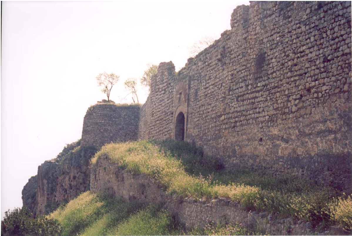
Εικ. 5.7 Εξωτερική όψη της Βορειοανατολικής (παλαιάς) κυρίας εισόδου του Κάστρου
