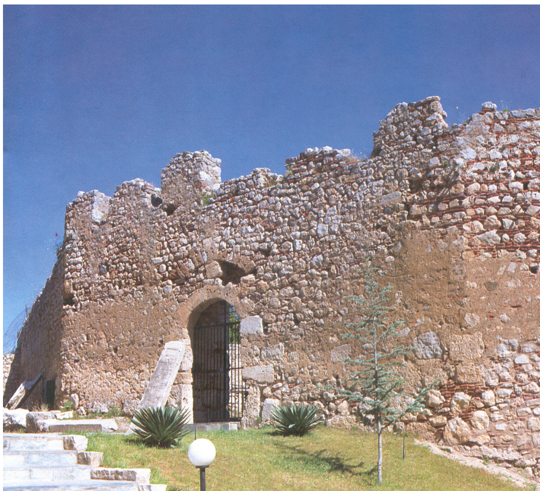
Εικ. 8.1 Ακροπύργιο. Η είσοδος στο τελευταίο καταφύγιο του Κάστρου γίνεται από πύλη με τοξωτό υπέρθυρο στο νότιο διαχωριστικό τοίχο του, ο οποίος σώζει στο επάνω τμήμα του περίδρομο και επάλξεις.
