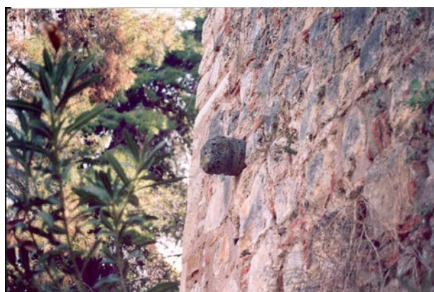
Εικ. 2.3, 2.4 Ηφαιστειογενής λίθος (τόφφος) στη Βορειοανατολική πλευρά των τειχών. Η θέση του στο τείχος φανερώνει ότι πιθανότατα χρησιμοποιήθηκε από τους Καταλανούς ως πάσσαλος για το δέσιμο βοηθητικών σχοινιών, προκειμένου να διευκολύνεται η ανάβαση των λίθων στη δύσβατη πλαγιά. Αυτό μας φανερώνει πως ο τρόπος καθέλκυσης των μεγάλων λίθων σε απόκρημνες πλαγιές και γενικά δύσβατες περιοχές παρέμεινε σχεδόν ίδιος, ακόμα και μετά την πάροδο περισσότερων από 1800 χρόνων.
