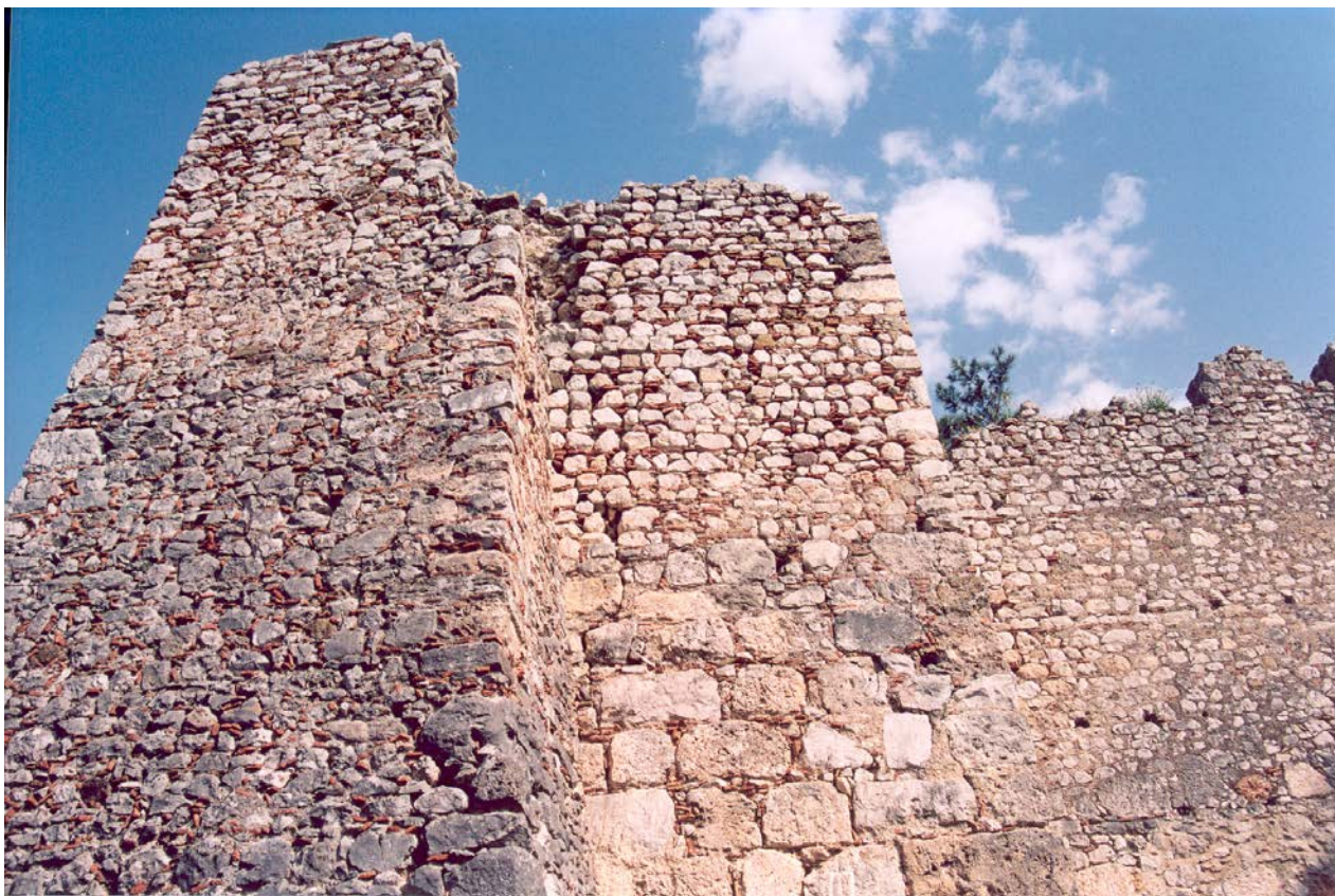
Εικ. 5.5 Διακρίνονται τμήματα που έχουν κτισθεί από μικρούς λίθους, ενώ τα μεταξύ τους κενά έχουν πληρωθεί με μικρές κεράμους και αμμοκονίαμα.
