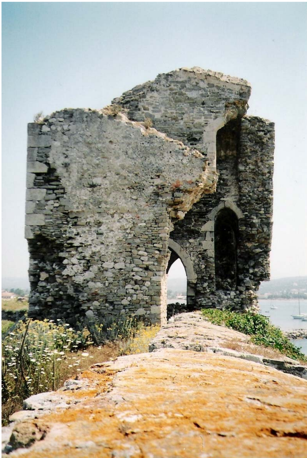
φωτ.41 Νοτιοανατολικός πύργος.
