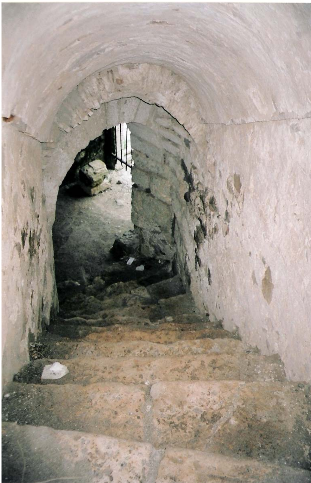
φωτ.35 Εσωτερική σκάλα στο μπούρτζι.
