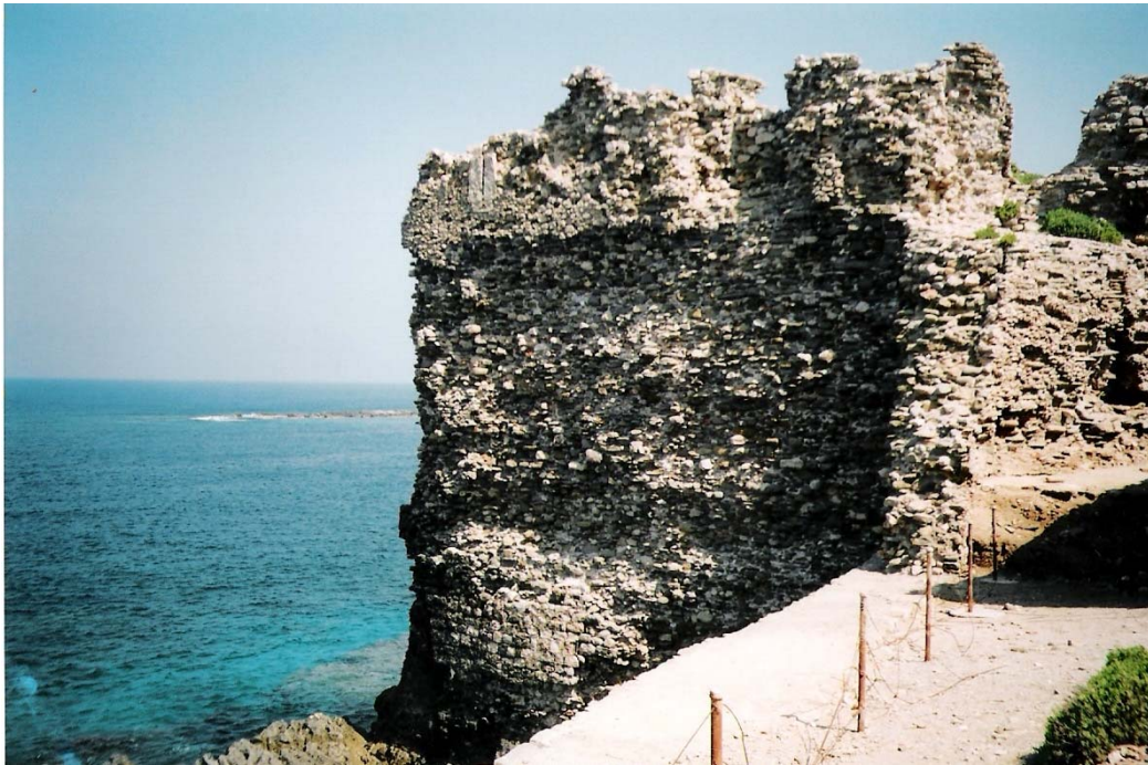
φωτ.43 Νοτιοανατολικός πύργος.
