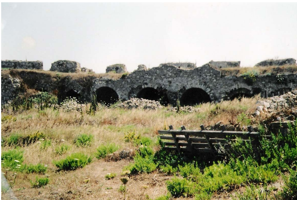
φωτ.62 Εσωτερικό τείχος
