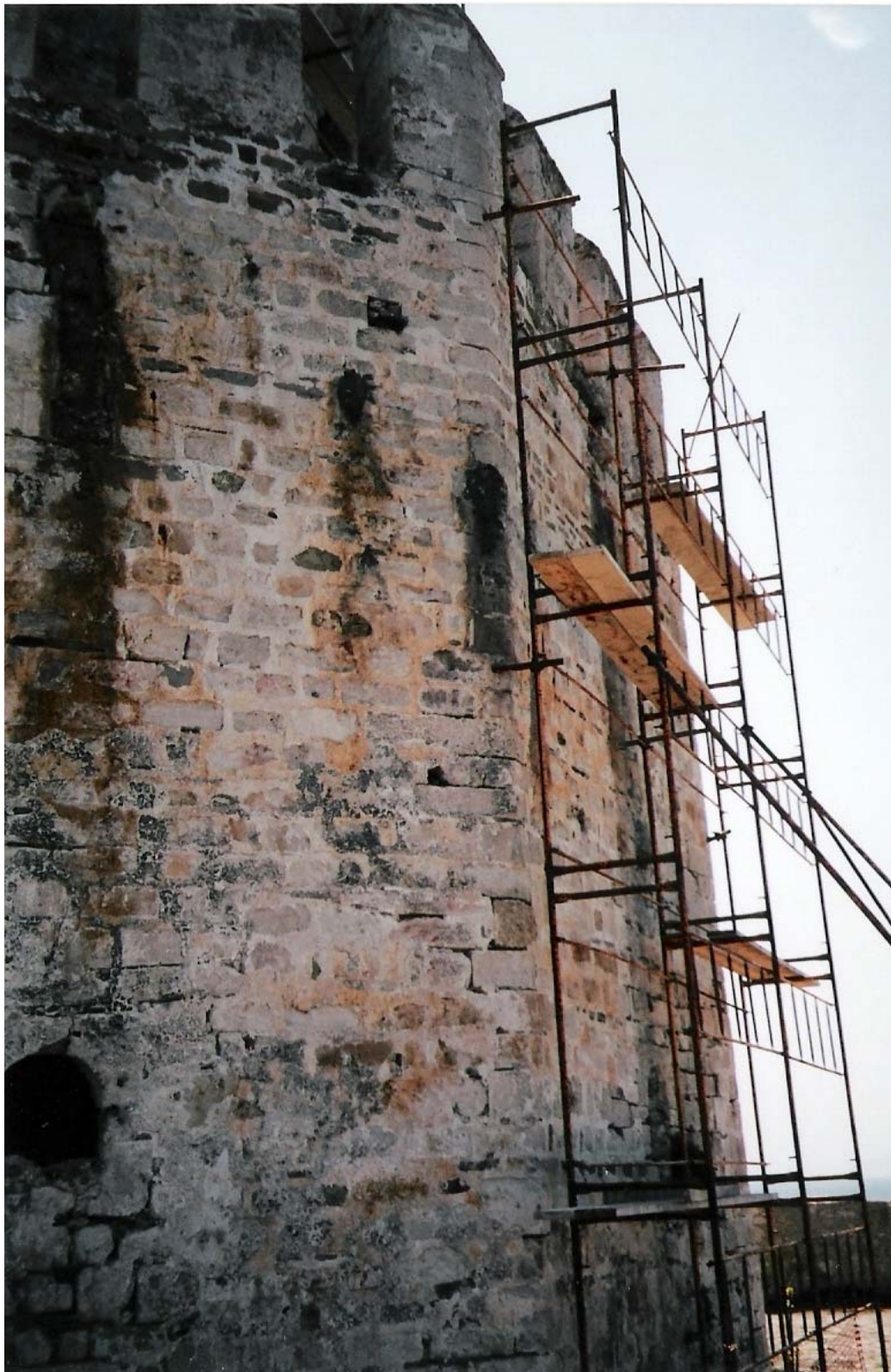
φωτ.48 Εργασίες αναστήλωσης στο Μπούρτζι.
