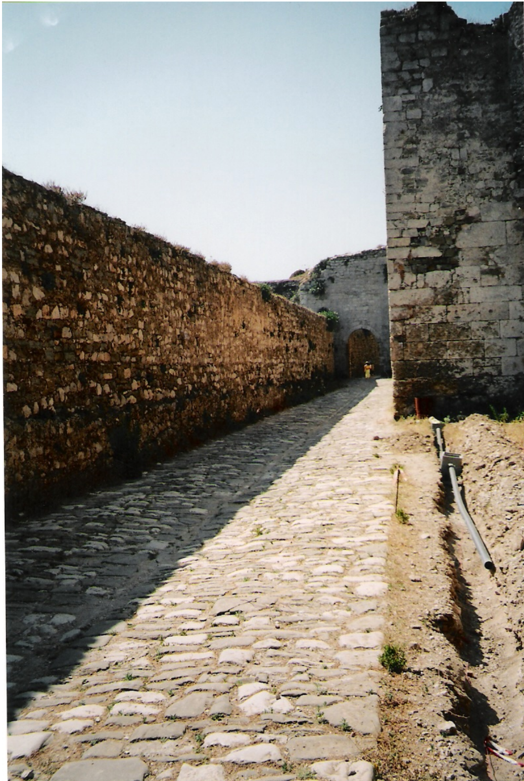
φωτ.53 Η κύρια εσωτερική πλακόστρωτη οδός . Το εσωτερικό τείχος έφερε κανονιοθυρίδες και τετράγωνους πύργους. Παρατηρούμε εργασίες για το φωτισμό του κάστρου.
