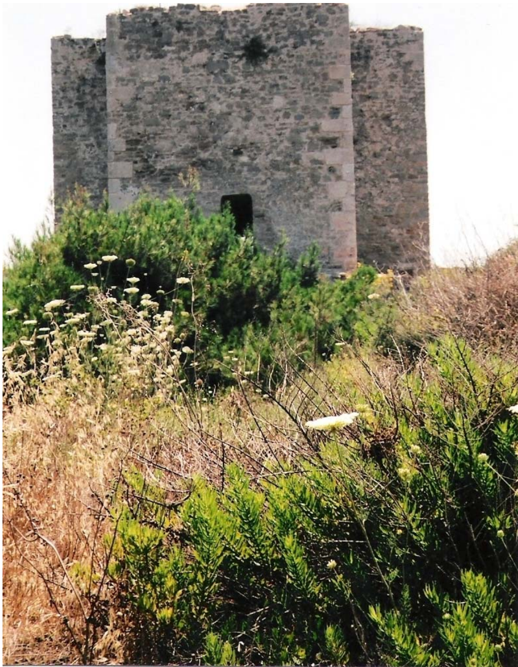
φωτ.72 Εσωτερική άποψη της Πύλης Storra.
