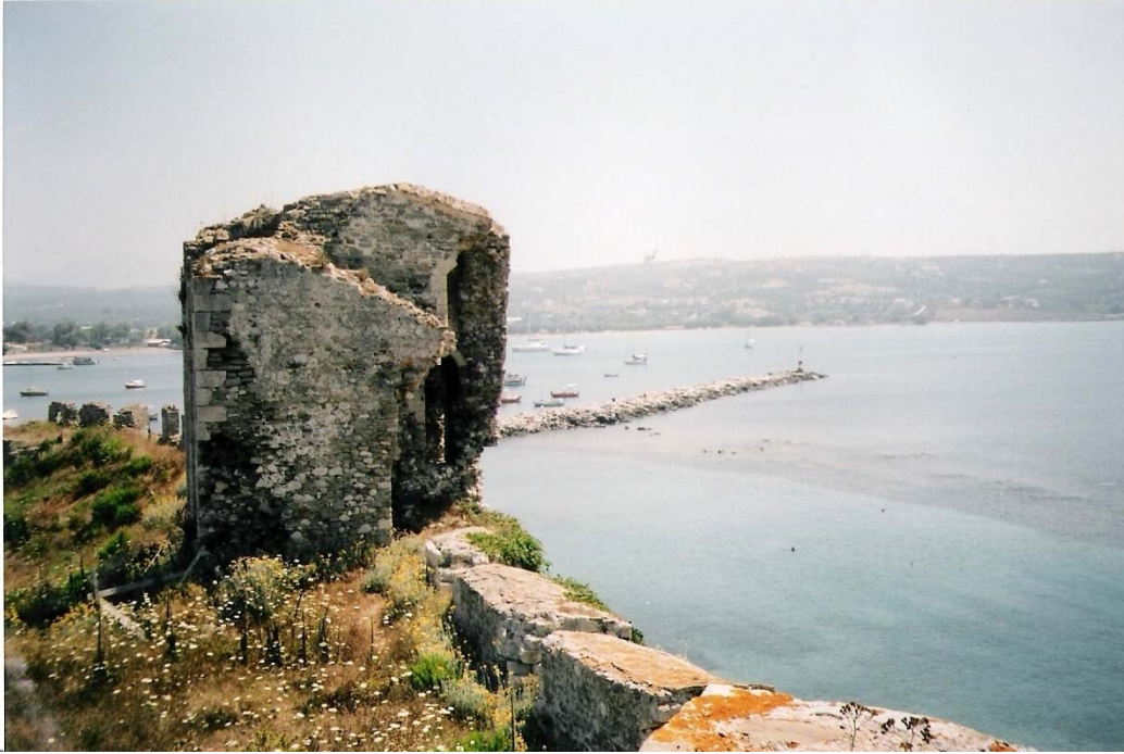
φωτ.42 Άποψη του λιμανιού της Μεθώνης, μαντρακι, όπου αμυδρά ξεχωρίζουν τα όρια του παλαιού μόλου. Στα αριστερά ο νέος μόλος που κτίστηκε από τους Ιταλούς μηχανικούς.
