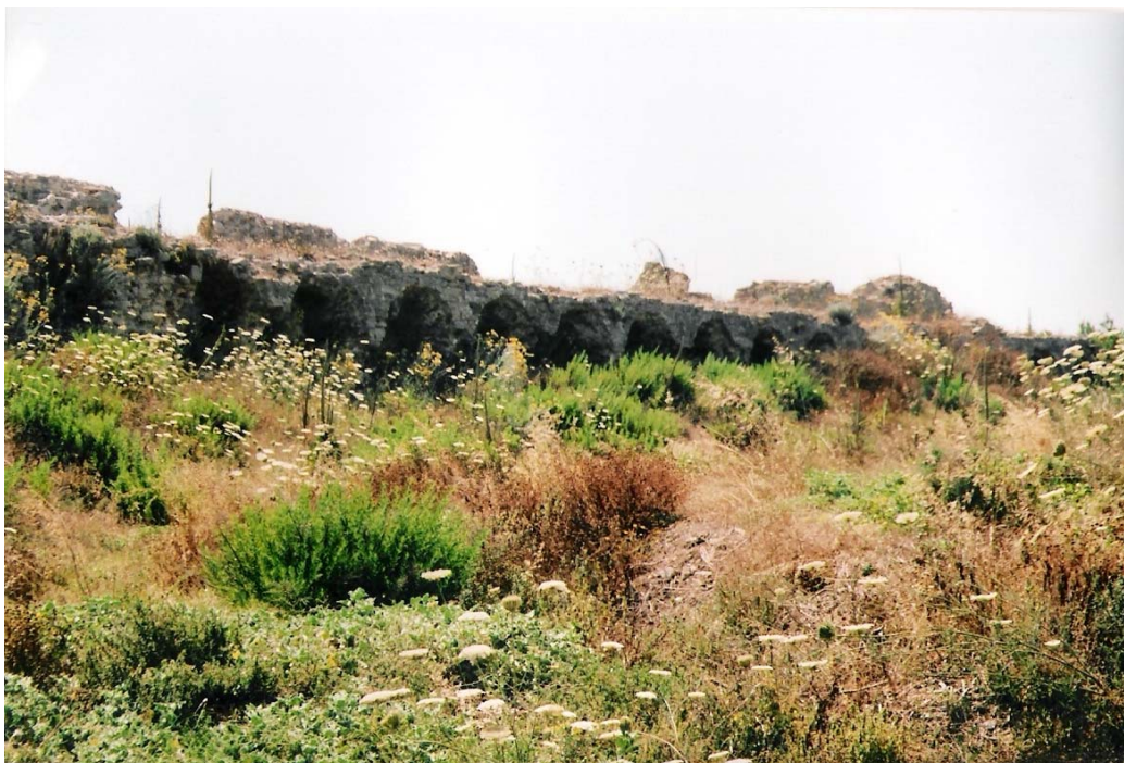
φωτ.63 Εσωτερικό τείχος.
