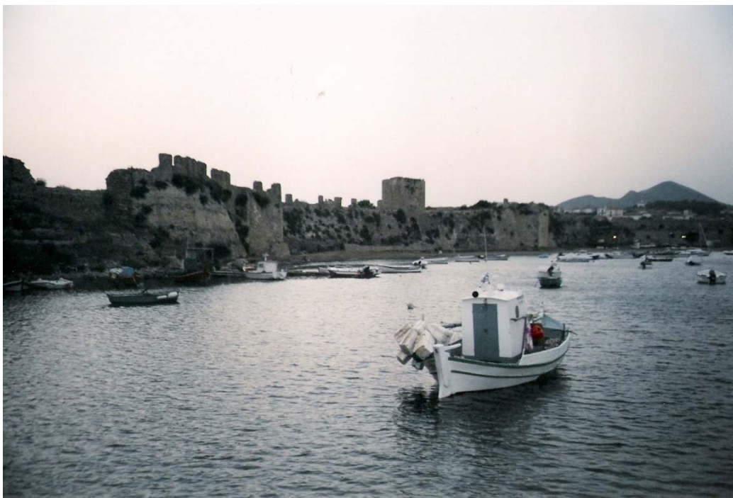
φωτ.12 Ανατολικό τείχος του κάστρου
