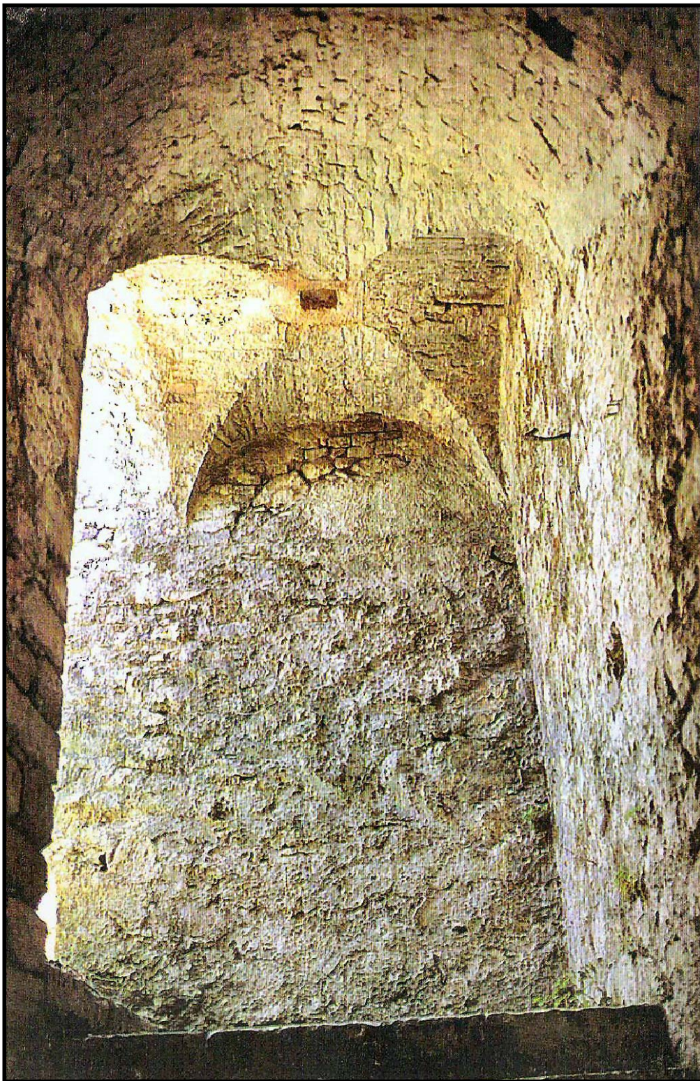
Εικόνα 68. Λεπτομέρεια του θόλου της κλιμακωτής στοάς που καταλήγει στην κορυφή του Πύργου της Θάλασσας
