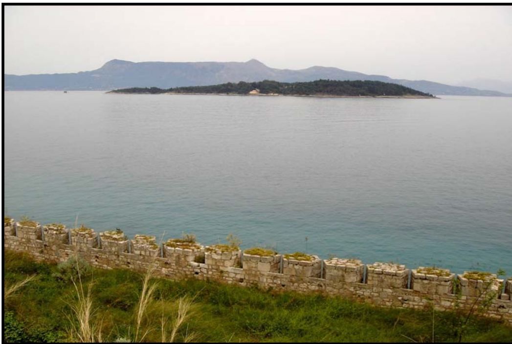
Εικόνα 113. Αποχωματώσεις των βενετσιάνικων κανονιοθυρίδων του οχυρού Camrana.
