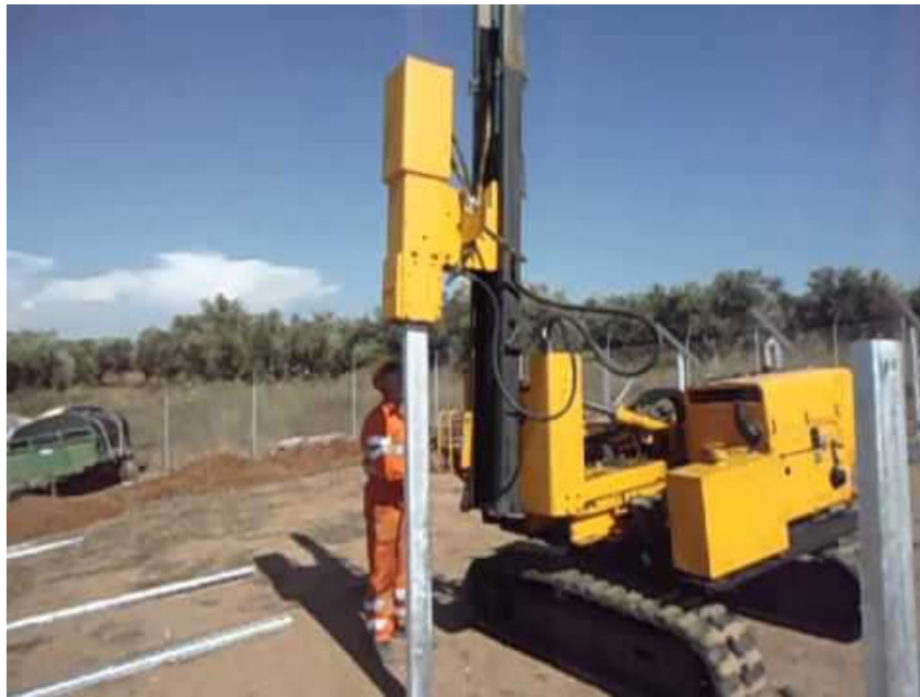
Εικόνα 3.10: Διαδικασία πασσαλόπηξης, www.orteco.com
