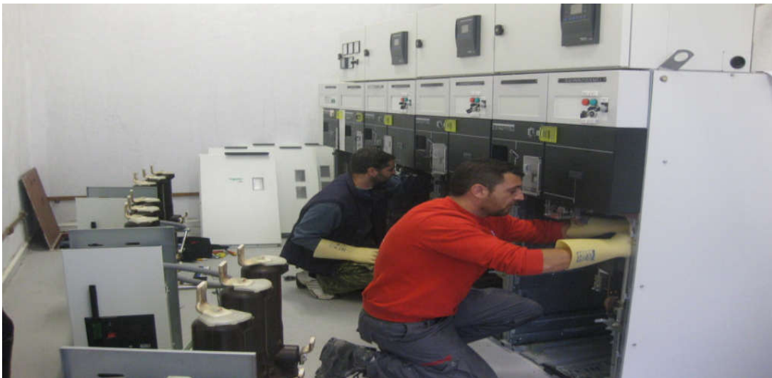
Εικόνα 3.6: Συντήρηση πεδίου μέσης τάσης, www.kontaratos.gr
