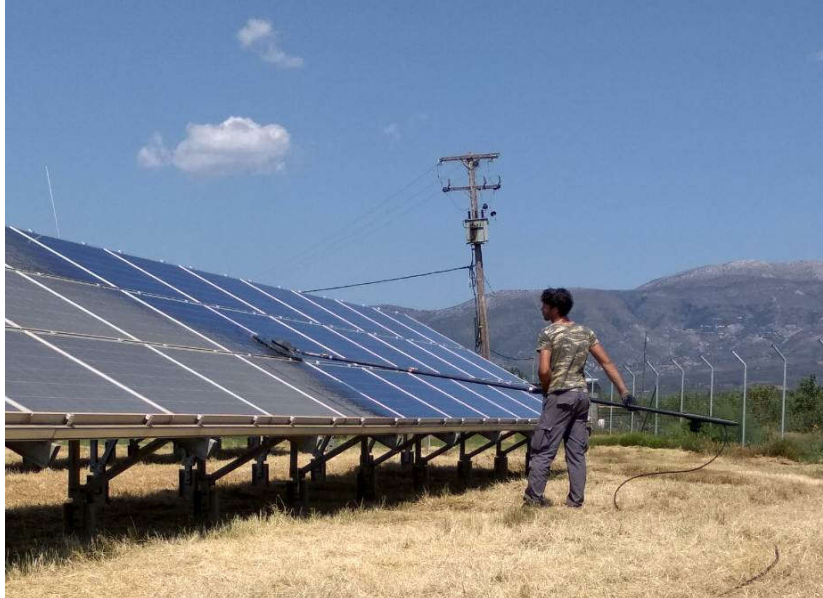
Εικόνα 3.16: Πλύσιμο Φ/Β πλαισίων με τη χρήση περιστροφικής βούρτσας
