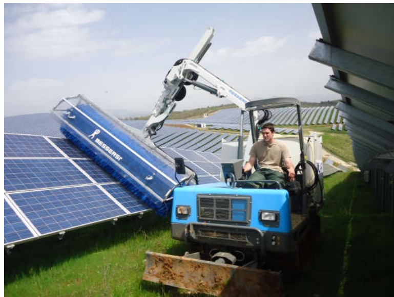
Εικόνα 3.17: Πλύσιμο Φ/Β πλαισίων με τη χρήση περιστροφικής βούρτσας, http://www.messersi.it/en/photovoltaic-roboklin-25/
