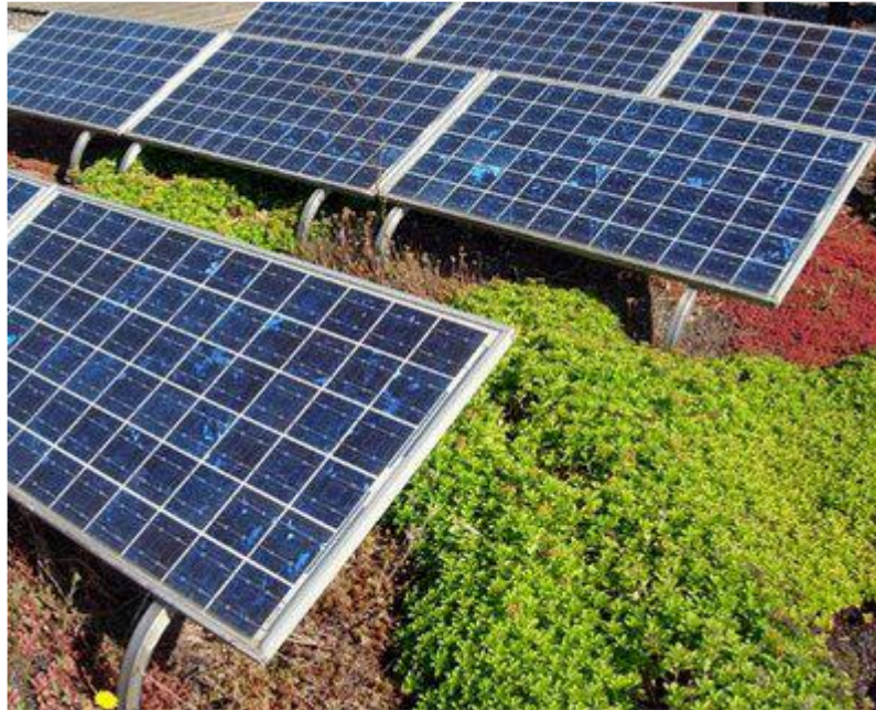
Εικόνα 7: Φυτεμένο δώμα με φωτοβολταϊκά
