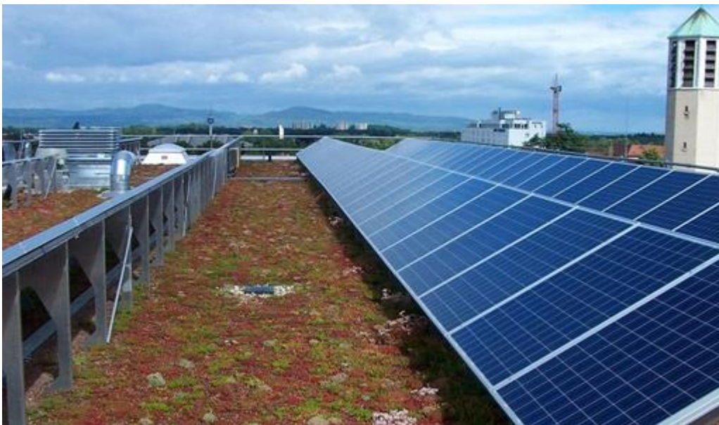
Εικόνα 10: Φυτεμένο δώμα με φωτοβολταϊκά
