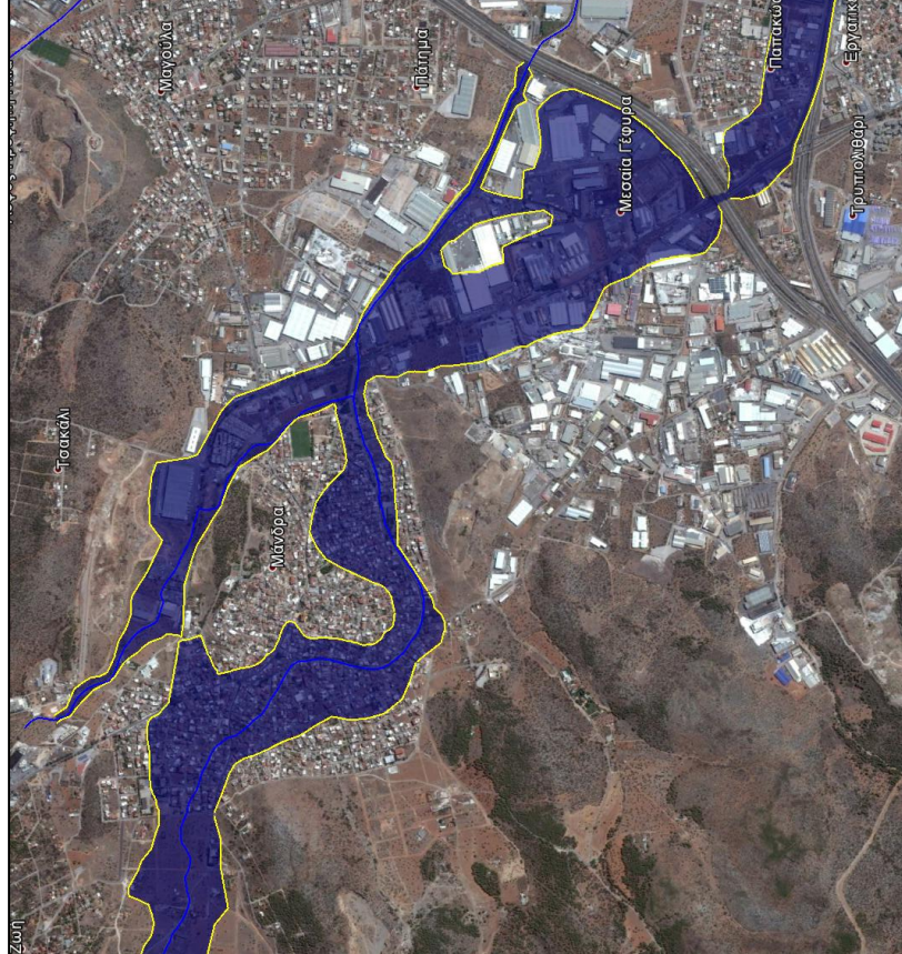
Εικόνα 7. Η περιοχή που πλημμύρισε με βάση τους Λέκκας κα. (2017). Άξιο αναφοράς είναι πως η ύπαρξη του Εθνικού δικτύου σε συνδυασμό με τα φερτά υλικά και την αδυναμία του δικτύου αποστράγγισης των υδάτων οδήγησε στην συγκέντρωση νερού ακριβώς πάνω από τον δρόμο.
