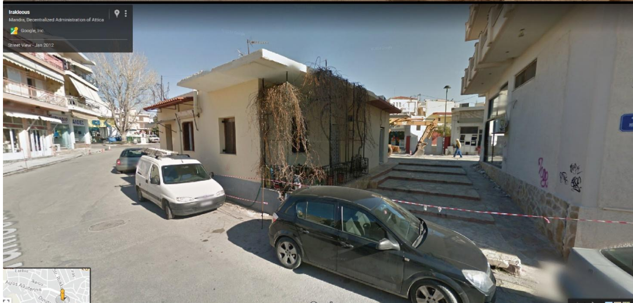
Εικόνα 27. Καταστροφές σε κτήρια στον οδό Ηρακλέους (εικόνα 9), σε σύγκριση με την κατάσταση πριν το συμβάν με την βοήθεια του Google street view από το 2012) (κάτω). Από την μεταφορά υλικών και μπαζών, έχουν προκληθεί ζημιές στην εξωτερική πλευρά του κτιρίου. Εξωτερικές κατασκευές για την στήριξη αναρριχητικών φυτών έχουν καταστραφεί, ενώ το μέγιστο ύψος του νερού ήταν περίπου 1 μέτρο (πάνω).
