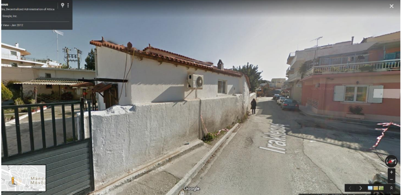
Εικόνα 13. Η μέγιστη στάθμη που καταγράφηκε ήταν πάνω από 2,5 μέτρα επί της οδού Ηρακλέους (καφέ κόκκινο χρώμα, πάνω εικόνα), σε σύγκριση με την κατάσταση πριν το συμβάν με την βοήθεια του Google street view από το 2012 (κάτω) (εικόνα 9).
