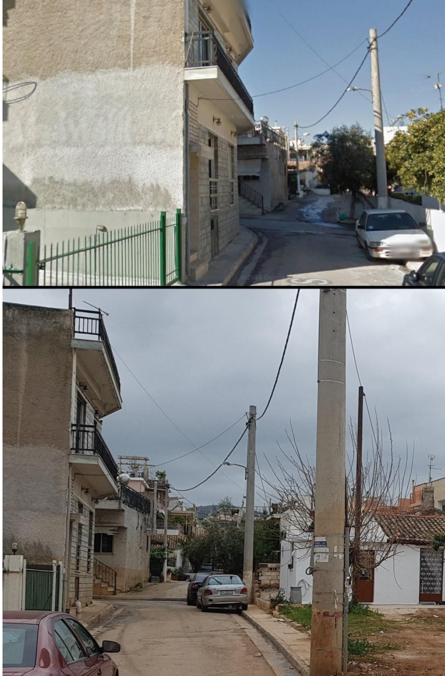
Εικόνα 15. Αποτύπωμα τις μέγιστης στάθμης του νερού περίπου 1 μέτρο (καφέ κόκκινο χρώμα σε πάροδο επί τις οδού Δημητράς (εικόνα 9), (κάτω εικόνα), σε σύγκριση με την προτεραία κατάσταση (πάνω εικόνα) (Google street view, 2012),
