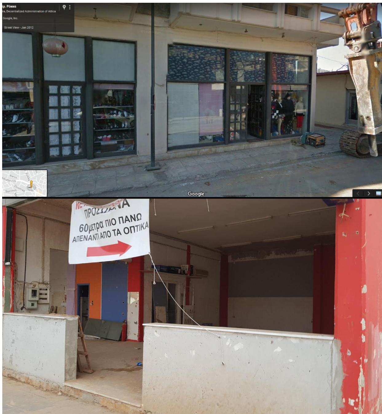
Εικόνα 22. Καταστροφές στο εξωτερικό τμήμα καταστήματος επί της οδού Στ. Ρόκα (εικόνα 9). Γενικά, καταστήματα ή άλλοι χώροι όπου είχαν σαν εξωτερική επιφάνεια από τζαμαρίες (πάνω εικόνα, Google street view, 2012), υπέστησαν ολοσχερείς καταστροφές (κάτω).
