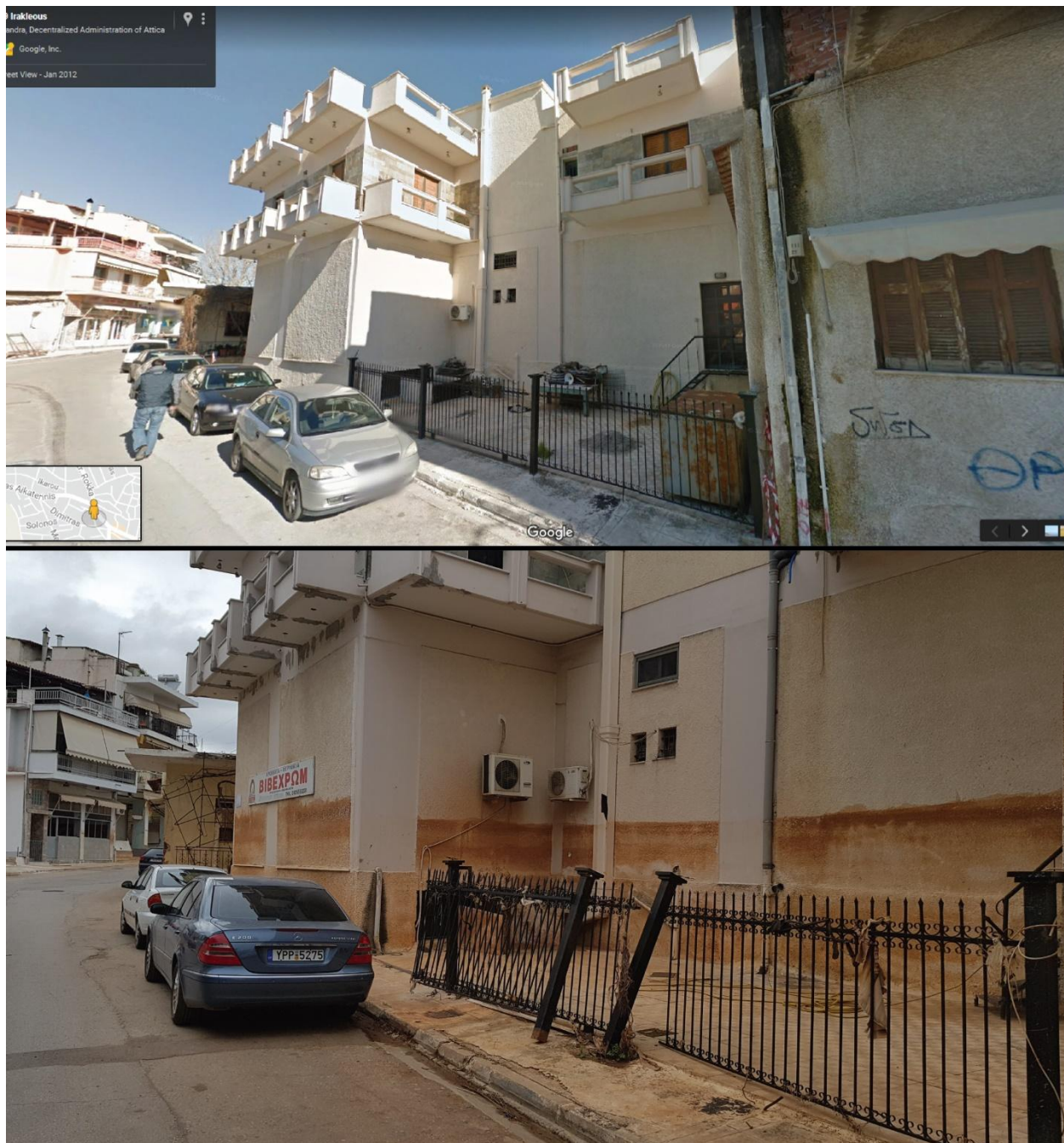
Εικόνα 12. Το ίχνος της μέγιστης στάθμης της πλημμύρας ήταν περίπου 1,8 μέτρα επί της οδού Ηρακλέους (εικόνα 9, καφέ κόκκινο χρώμα) (κάτω), σε σύγκριση με την κατάσταση πριν το συμβάν με την βοήθεια του Google street view από το 2012) (πάνω).
