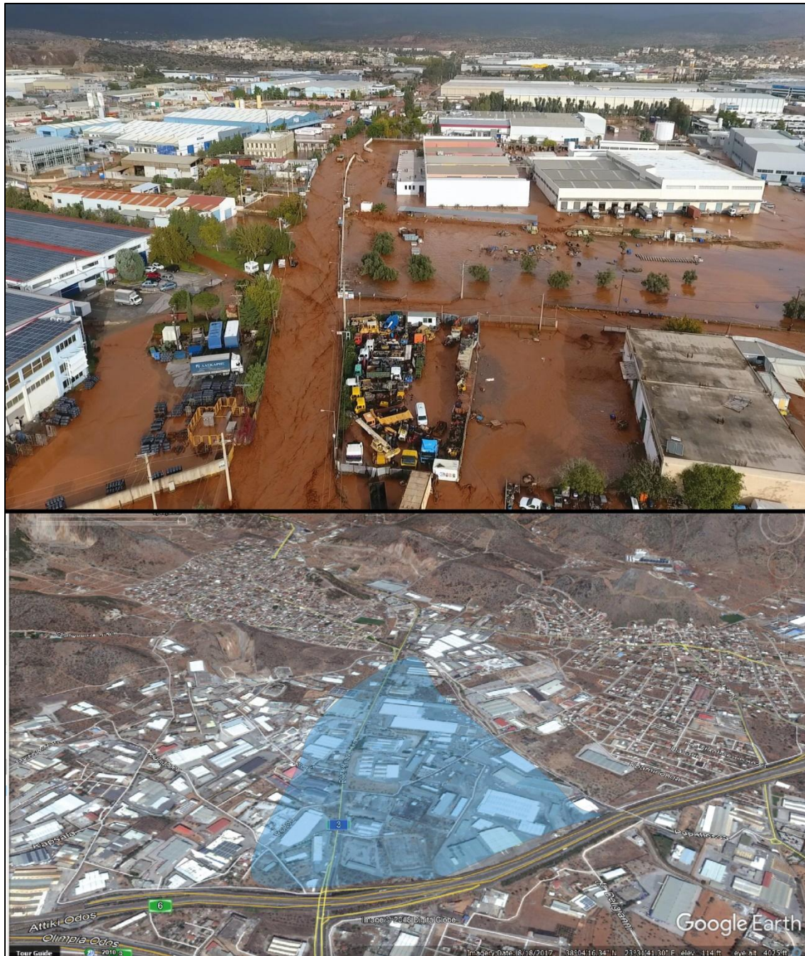
Εικόνα 36. Σοβαρές καταστροφές από την πλημμύρα στο βιομηχανικό πάρκο της Μάνδρας (πάνω εικόνα). Η ύπαρξη της εθνικής οδού, σε συνδυασμό με την αστοχία του αντιπλημμυρικού έργου, οδήγησε στην συσσώρευση νερών και στις εκτεταμένες καταστροφές του πάρκου (κάτω εικόνα, τροποποιημένο από Λέκκας κα., 2017).
