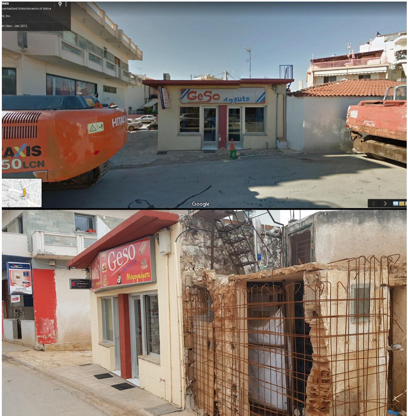
Εικόνα 24. Ολοκληρωτική καταστροφή οικοδομήματος επί των οδών Αγ. Αικατερίνης και Ευ. Κοροπούλη (εικόνα 9). Η μικρή μονοκατοικία (πάνω εικόνα, Google street view, 2012), υπέστη ολική κατάρρευση τις τοιχοποιίας (κάτω). Απουσιάζει εντελώς σκεπή, και το μεγαλύτερο μέρος του οικοδομήματος. Οι ιδιοκτήτες της έχουν προσπαθήσει να δισώσουν την κατασκευή, τοποθετώντας μεταλλικό πλέγμα γύρω αυτήν.
