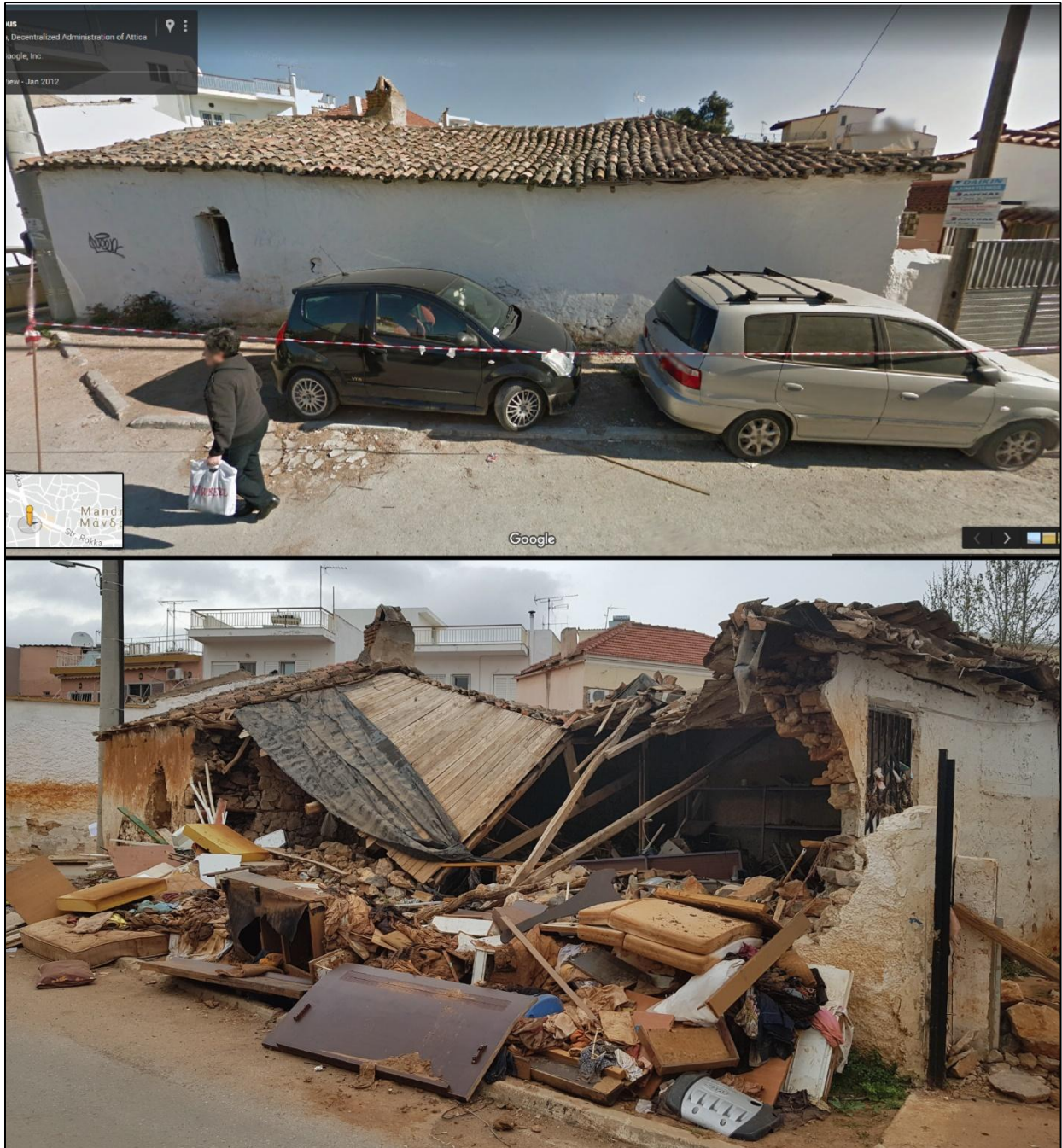
Εικόνα 26. Ολοσχερής καταστροφή του κτιρίου επί της οδού Δημητράς (εικόνα 9). Η σκεπή του κτιρίου έχει καταρρεύσει, όπως επίσης και το τμήμα της τοιχοποιίας που ήταν εκτεθειμένο προς την πλευρά του δρόμου (κάτω), σε σύγκριση με την κατάσταση πριν το συμβάν με την βοήθεια του Google street view από το 2012) (πάνω).
