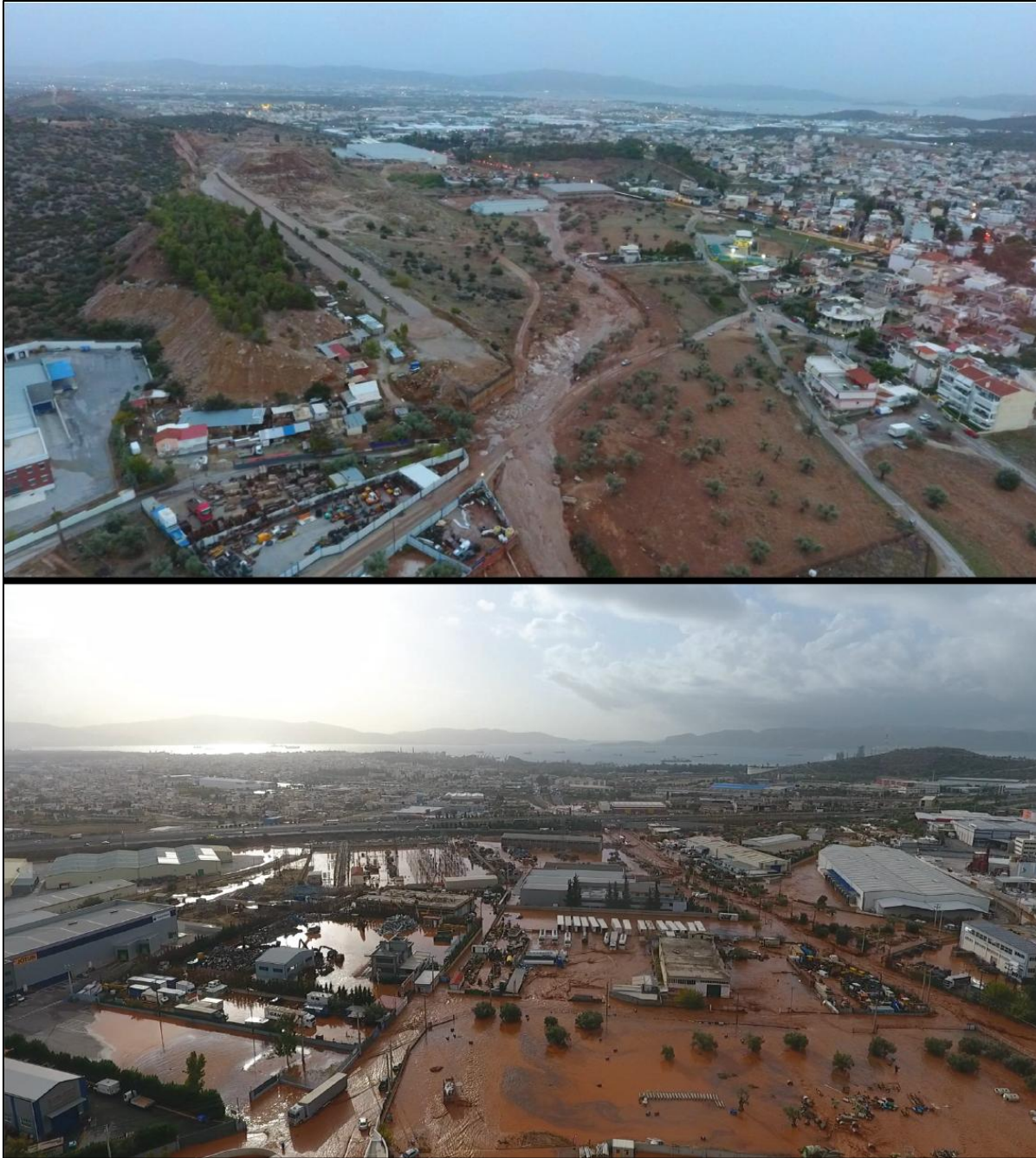
Εικόνα 17. Εκτεταμένες καταστροφές παρατηρούνται και έξω από τα όρια του οικισμού. Στο ρεύμα Σούρες (πάνω), αποθήκες καταστράφηκαν ολοσχερώς, καθώς και νοτιότερα του οικισμού κοντά στο Εθνικό οδικό δίκτυο (κάτω) (τροποποιημένο από Λέκκας κα., 2017).
