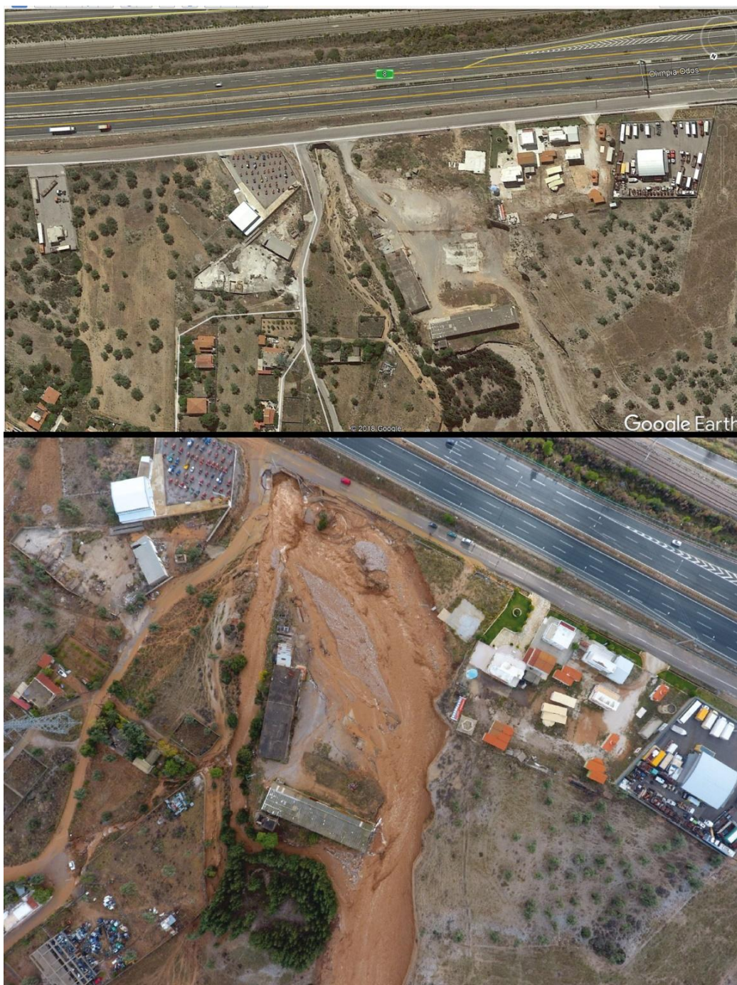
Εικόνα 38. Η γέφυρα στο ύψος της εθνικής οδού στο κόμβο της Νέας Περάμου αποδείχτηκε ελλιπής, αδυνατώντας να αποστραγγίσει τα ρέοντα ύδατα με αποτέλεσμα τις εκτεταμένες καταστροφές του οδικού δικτύου (κάτω εικόνα τροποποιημένο από Λέκκας κα., 2017), σε σύγκριση με την πρότερη κατάσταση (πάνω εικόνα), από το Google Earth (10/2017).
