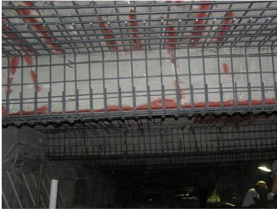
Εικόνα 14: Διαδικασία εφαρμογής μανδύα με εκτοξευόμενο σκυρόδεμα.
