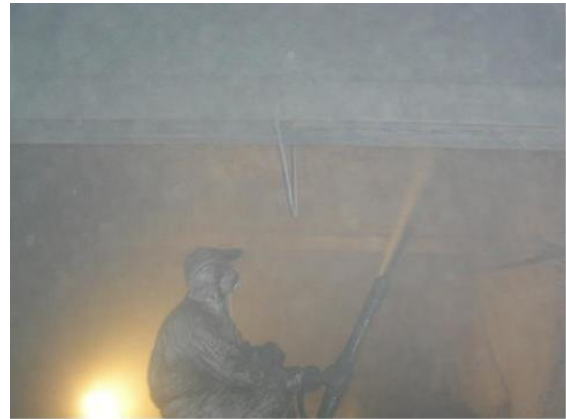
Εικόνα 14: Διαδικασία εφαρμογής μανδύα με εκτοξευόμενο σκυρόδεμα.
