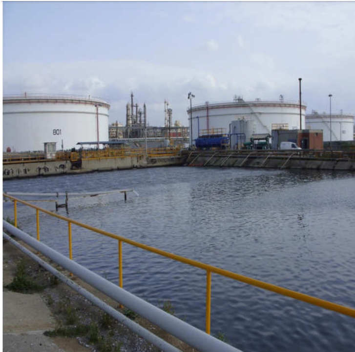
Εικόνα 14: Μονάδα βιολογικής κατεργασίας και ο τελικόςελαιοδιαχωριστής
