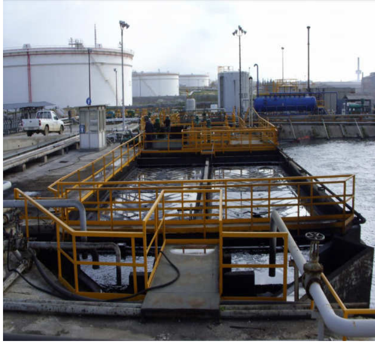
Εικόνα 13: Αρχικός ελαιοδιαχωριστής API
