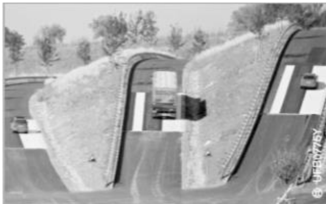
Εικόνα 11 Δοκιμές του συστήματος ελέγχου πρόσφυσης
