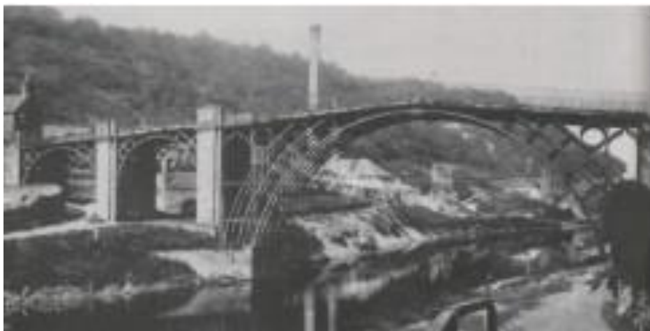
Εικόνα 1.1 Η πρώτη γέφυρα από χυτοσίδηρο Coalbrookdale Αγγλία 1777 [Δ1]
