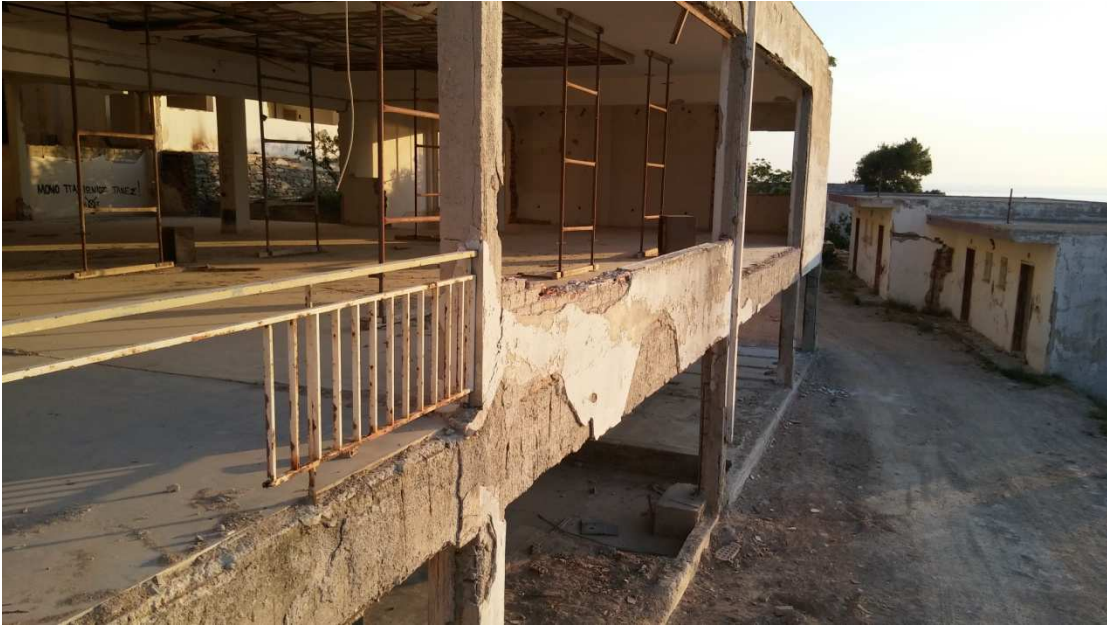
Εικόνα 4.4: Αποξηλωμένα τμήματα κτιρίου (Ισόγειο)
