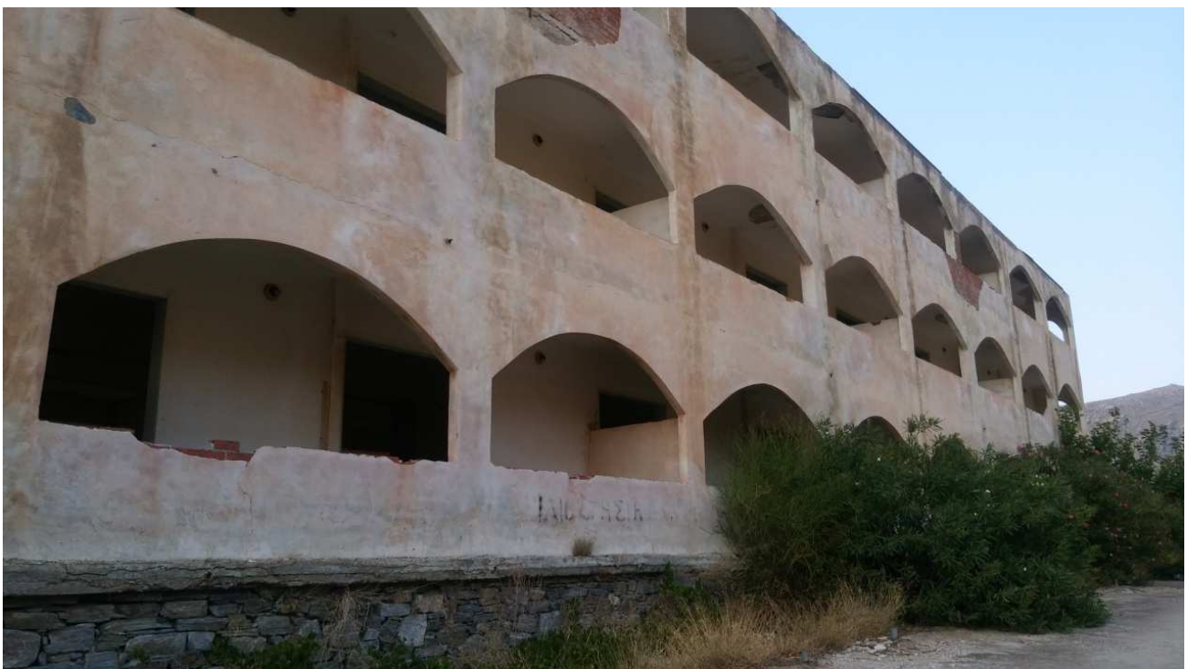
Εικόνα 4.1: Όψη τμήματος Ξενοδοχείου
