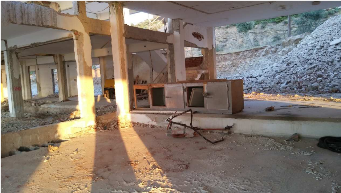
Εικόνα 4.5: Αποξηλωμένα τμήματα κτιρίου (Ισόγειο)
