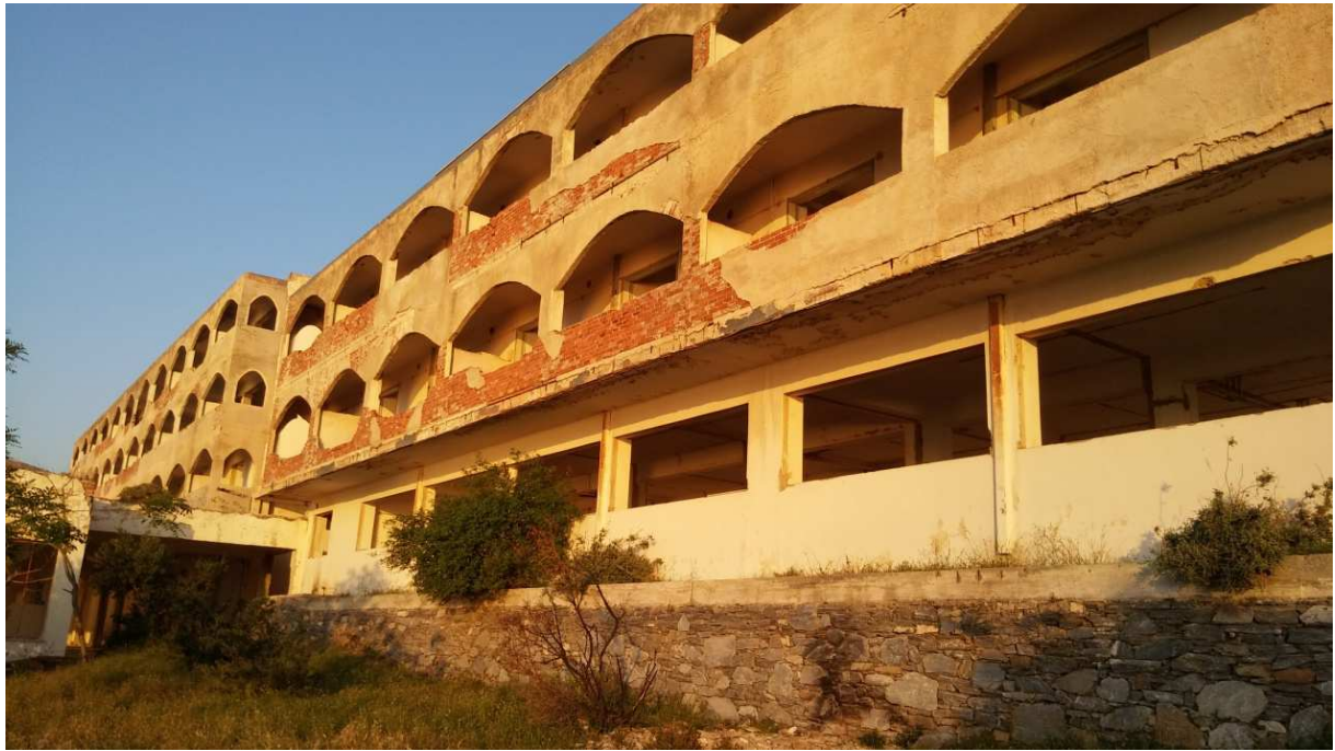
Εικόνα 4.2: Όψη τμήματος Ξενοδοχείου
