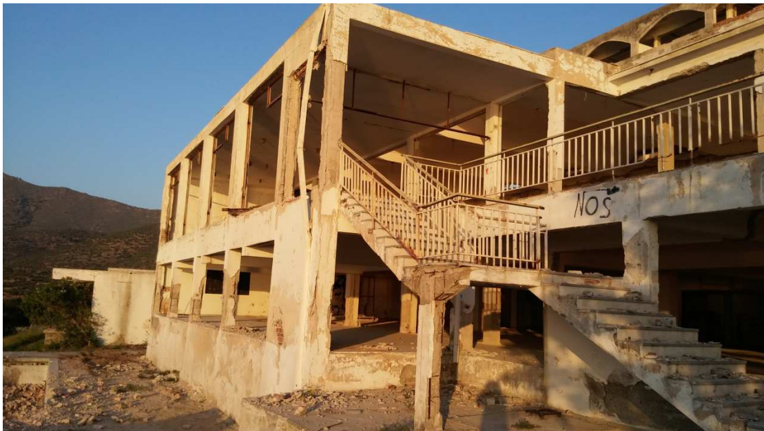
Εικόνα 4.3: Αποξηλωμένα τμήματα κτιρίου (Ισόγειο-Υπόγειο)
