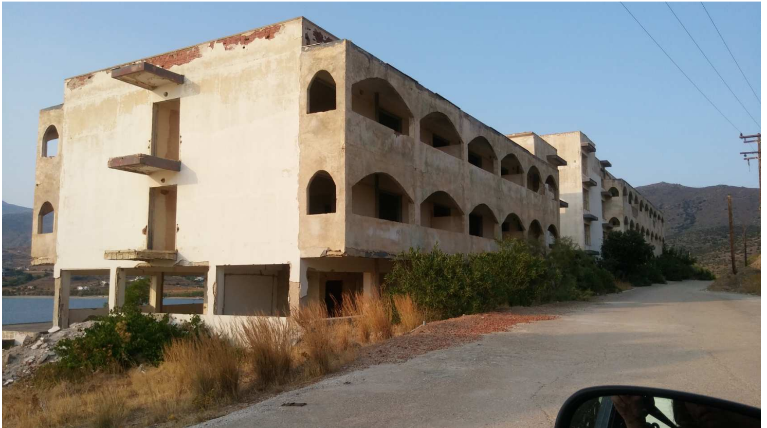
Εικόνα 4.14: Νοτιοδυτική και νοτιοανατολική όψη Α' & Β' ορόφου (Τμήμα Α)
