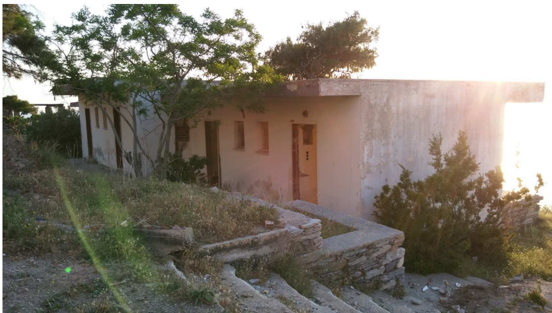
Εικόνα 4.18: Νοτιοανατολική όψη ανεξάρτητων κτισμάτων
