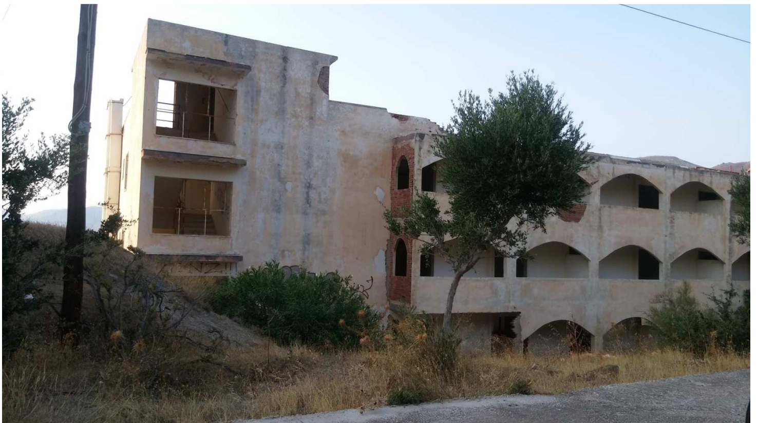
Εικόνα 4.15: Νοτιοανατολική όψη Α' & Β' ορόφου (Τμήμα Γ)
