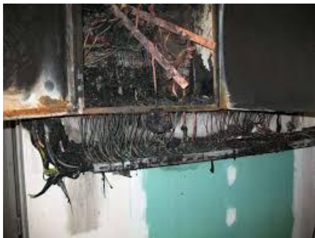
Εικόνα 2-9 Βραχυκυκλωμένα καλώδια Πηγή: ec.europa.eu
