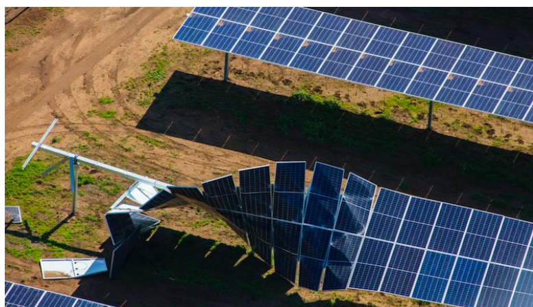
Εικόνα 2-4 Αποκόλληση φ/β πλαισίων από τη βάση στήριξης τους Πηγή: pv-magazine-usa.com
