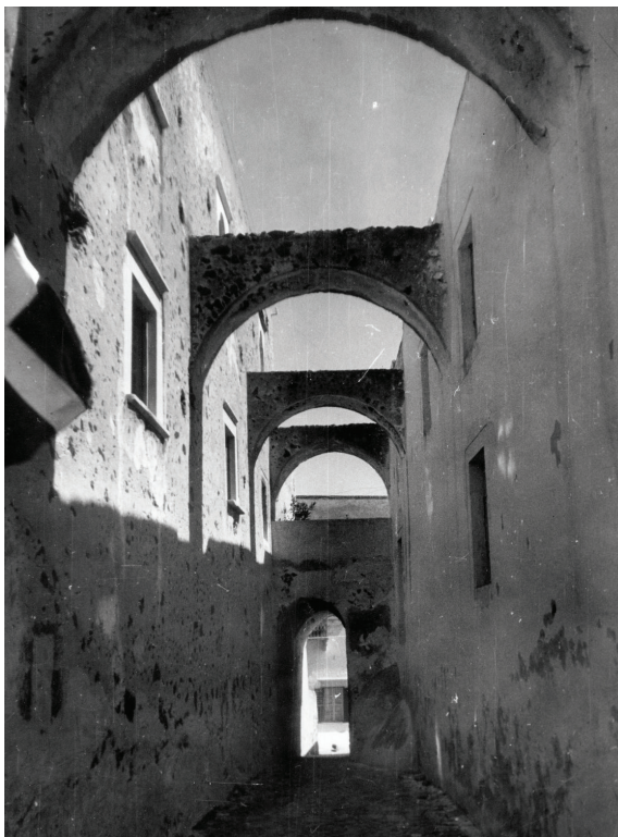
Εικόνα 21. Αντηρίδες (© Συλλογή Λ. Ζώρζου). 39
