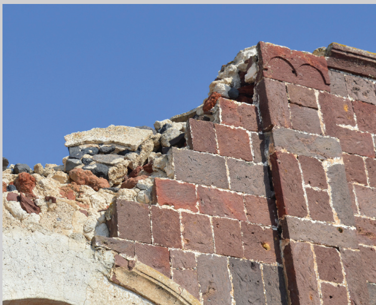
Εικόνα 37. Τοιχοποιία η οποία ενισχύεται εξωτερικά με μια στρώση από λαξευτούς λίθους. 66
