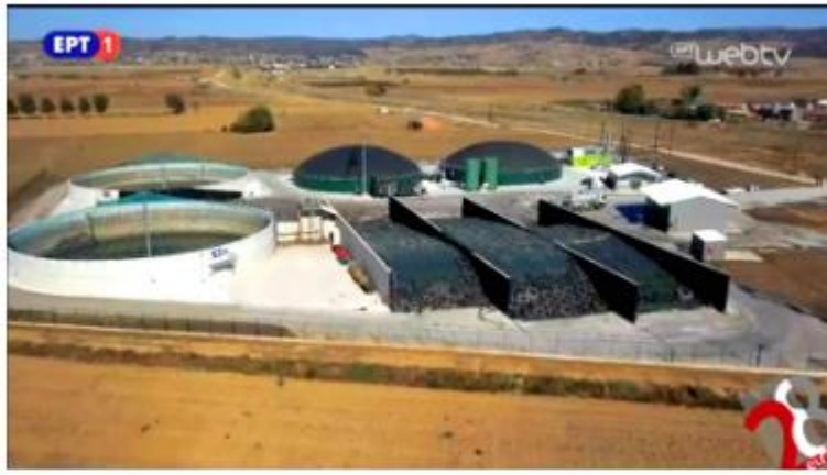
Εικόνα 17 Εγκαταστάσεις Βιοαέριο Λαγκαδά
