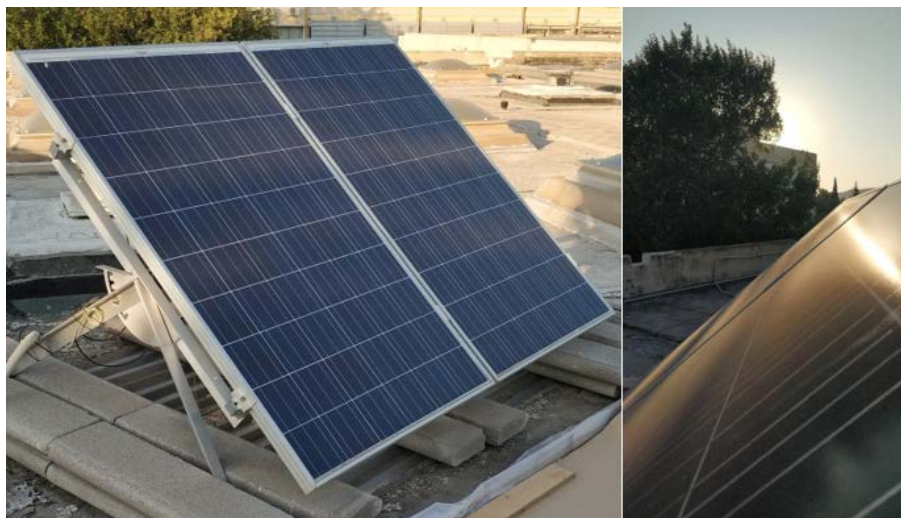
Σχήμα 5.6 - Απεικόνιση παρεμβαλόμενων αντικειμένων μεταξύ φωτοβολταϊκού πλαισίου και ήλιου κατά τις απογευματινές ώρες.
