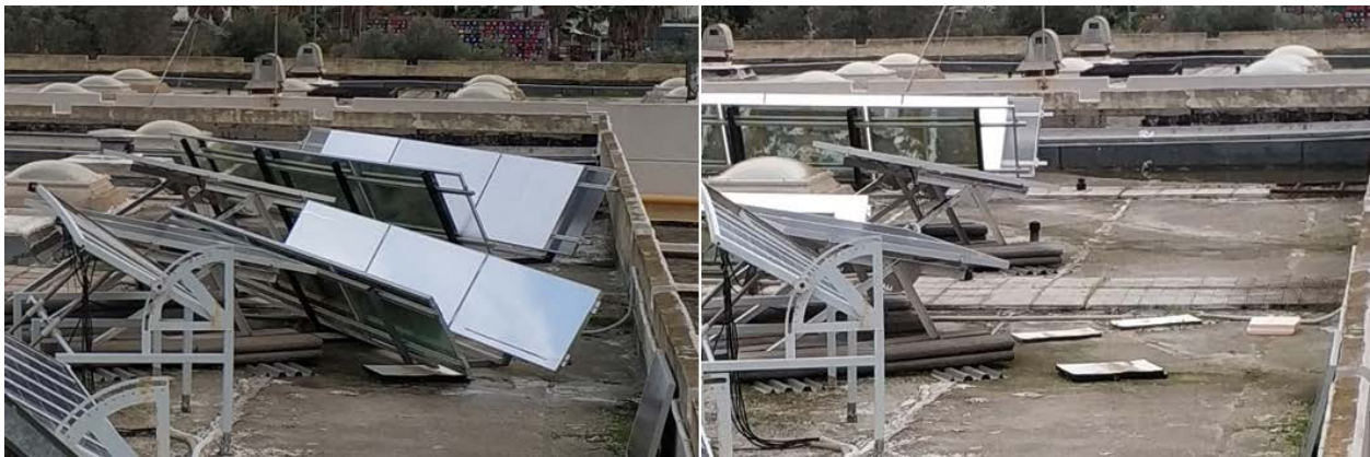
Σχήμα 4.1 - Απομάκρυνση κατόπτρων
