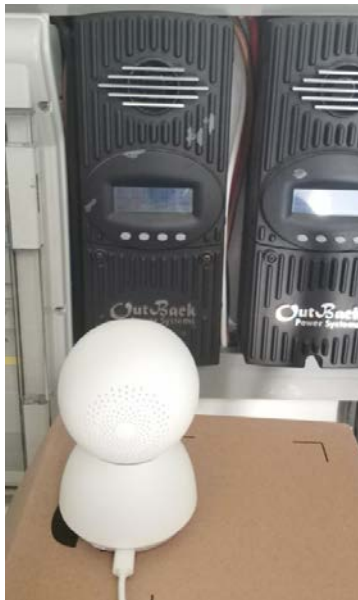
Σχήμα 4.7 - Λήψη μετρήσεων παραγωγής ενέργειας από φορτιστή μπαταριών με κάμερα
