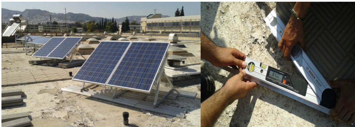
Σχήμα 5.18 - Εγκατάσταση φωτοβολταϊκών πλαισίων (2015)
