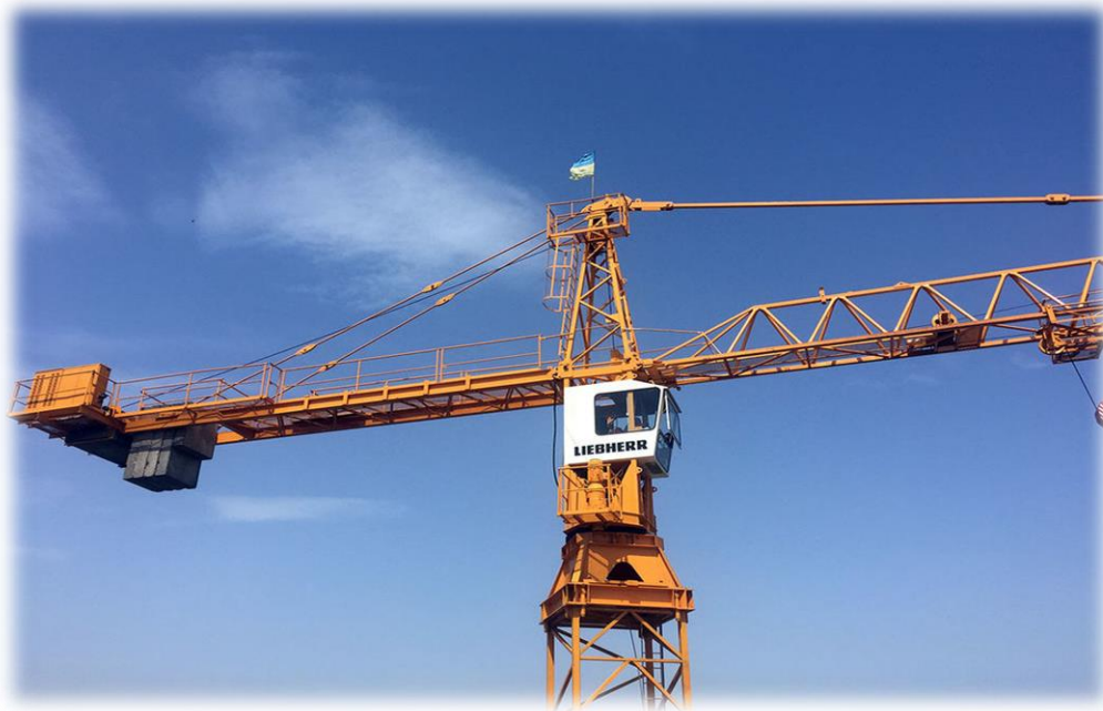
Εικόνα 12: Περιστρεφόμενος γερανός πύργου (liebherr.com, 2019)
