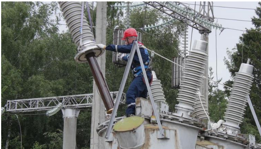
Εικόνα 2.3 Διαδικασία τοποθέτησης των μονωτήρων σε έναν τριφασικό Μ/Σ υψηλής τάσης. [46]
