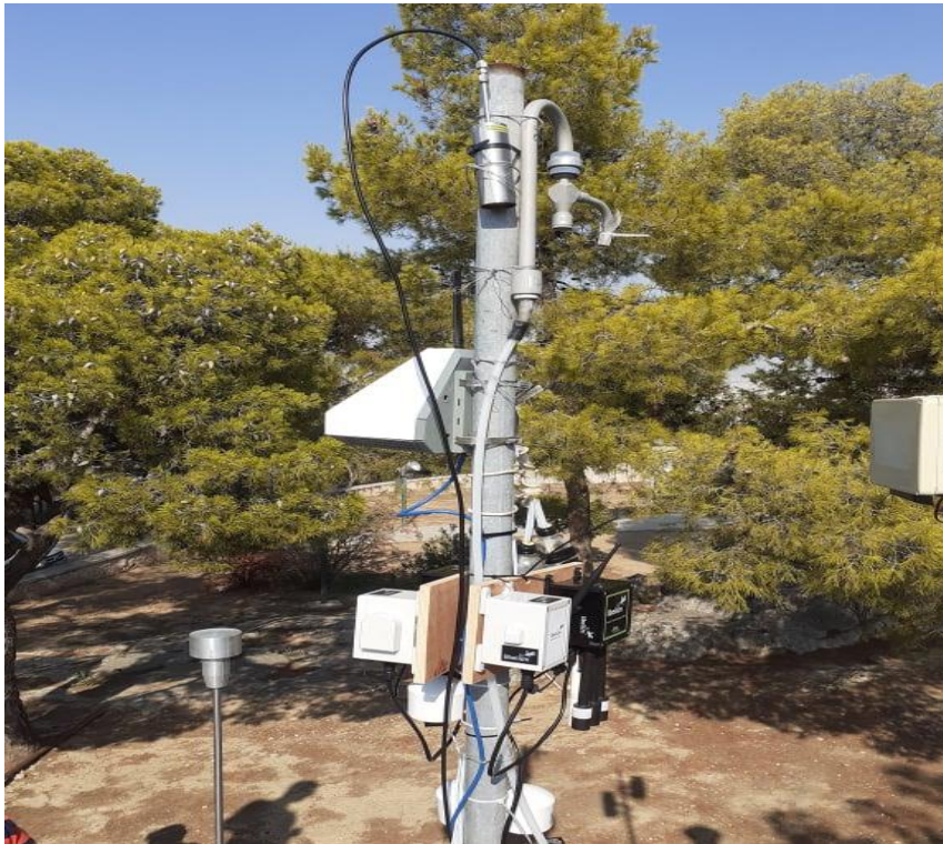
Εικόνα 4.16 : Εγκατάσταση εξοπλισμού στο Αστεροσκοπείο (Πηγή: Προσωπικό αρχείο)
