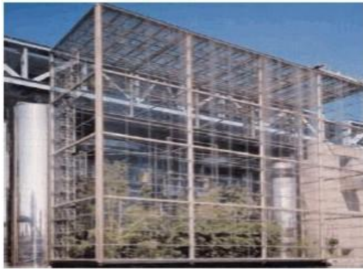
Εικόνα 18. Χρήση δομικού υαλοστασίου ως τοιχοποιία σε κτίριο.
